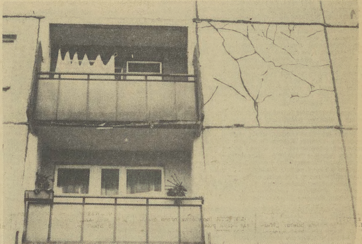
To nie ozdorna elewacja z abstrakcyjnymi wzorami, to szpary i pęknięcia ściany domu, przez które nie tylko wilgoć przedostaje się do wnętrza.
