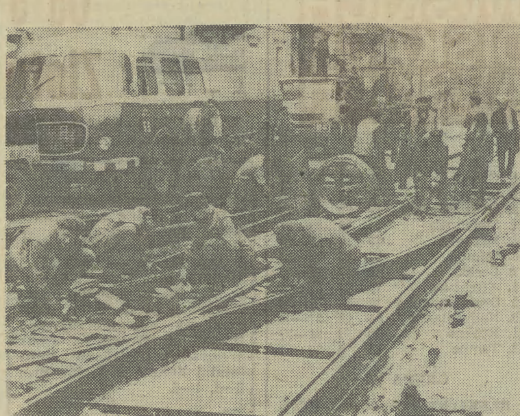
Pracuje tu wielu ludzi, ale tylko kilku spośród nich to pracownicy MPK. Gdyby nie pomoc wojska, remont trwałby o wiele dłużej. Fot. ST. MAKAREWICZ
