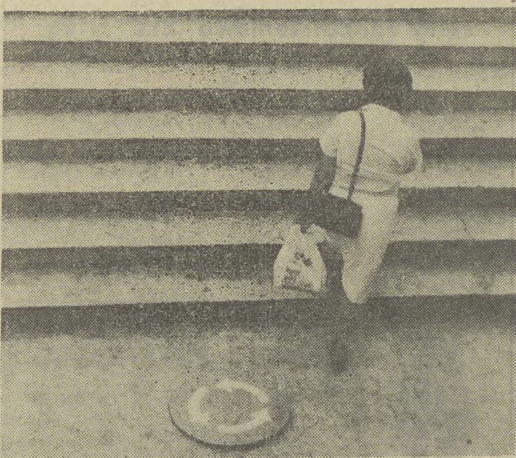
Krakowskie przejścia podziemne są z reguły budowlami prostymi i koryzysta się z nich łatwo. Czyżby tu wyjątek? Fot.: JACEK BEDNARCZYK
