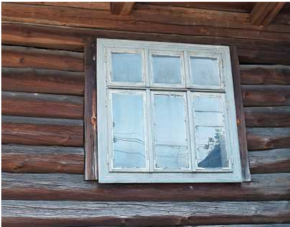
Fot. nr 97. Okno w fasadzie.
