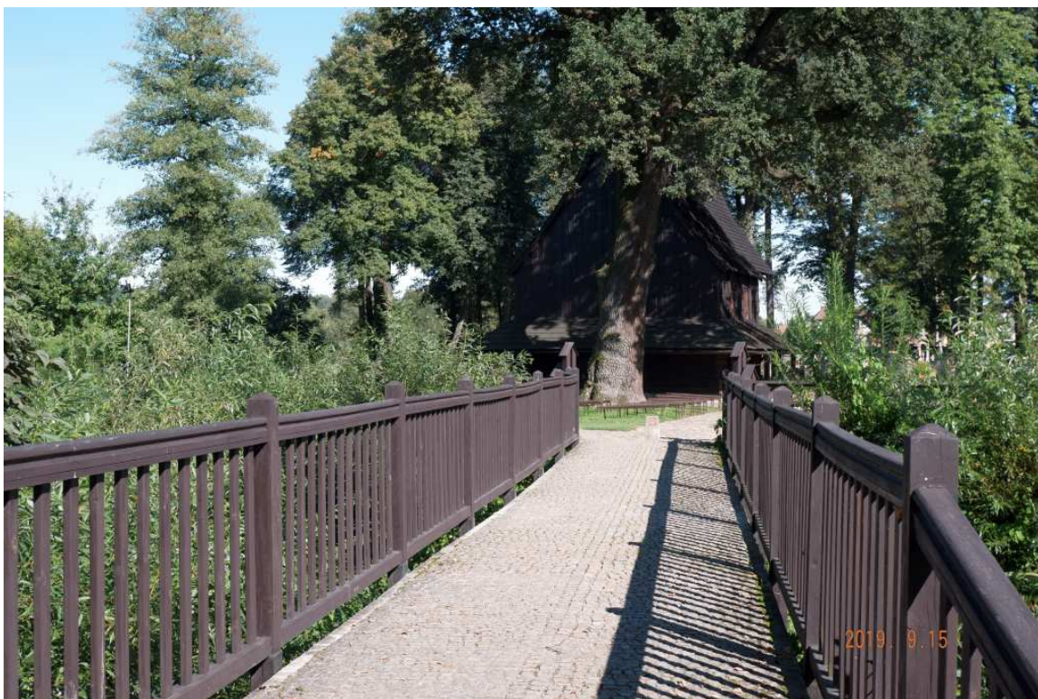
Fot. nr 146. Mostek na Uszwicy w ciągu drogi na cmentarz.
