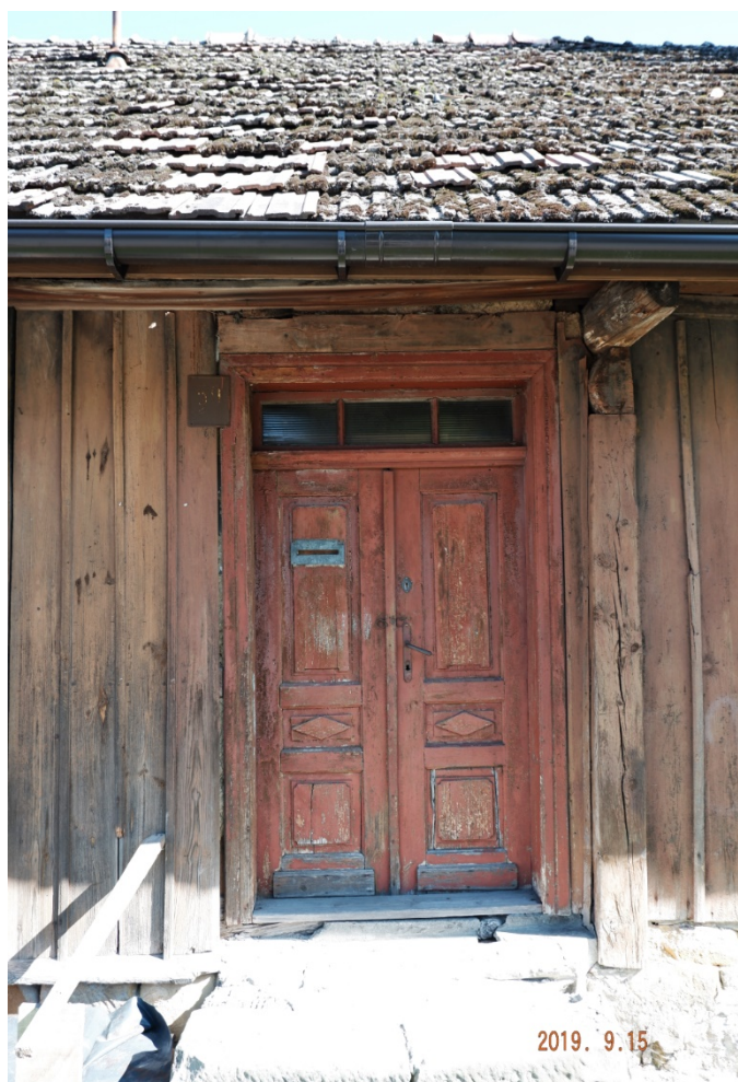
Fot. nr 64. Oryginalne drzwi.
