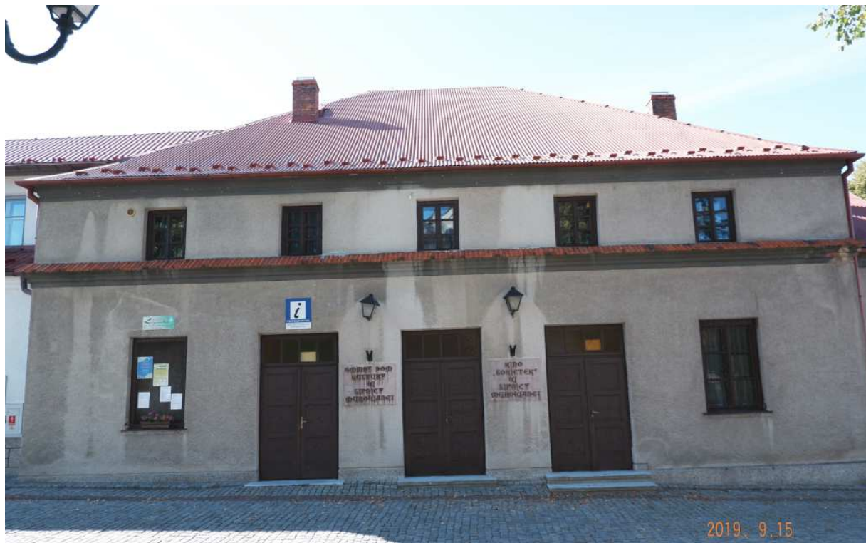
Fot. nr 121. Budynek kina Łokietek pod nr 43.
