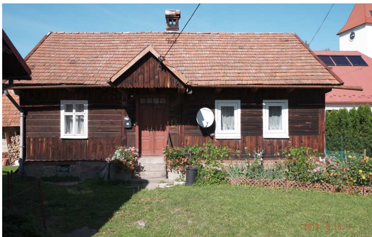
Fot. nr 72. Plastikowe okna bez podziałów wołają o zgrozę.
