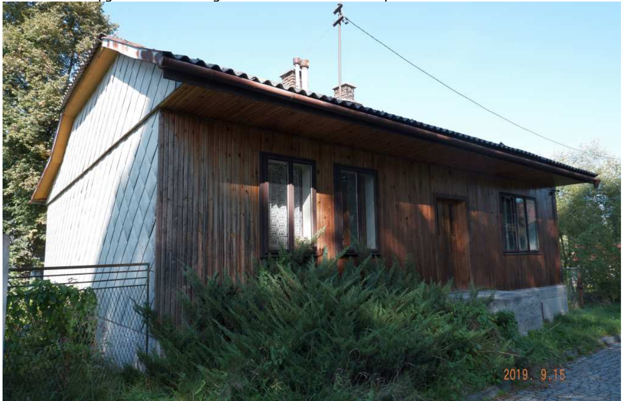
Fot. nr 100 (100-101). Dom pod nr 100. Nie figuruje do ewidencji zabytków. Fasada i okna nieoryginalne. Można go ostrożnie datować na przełom I i II ćwierci XX wieku.
