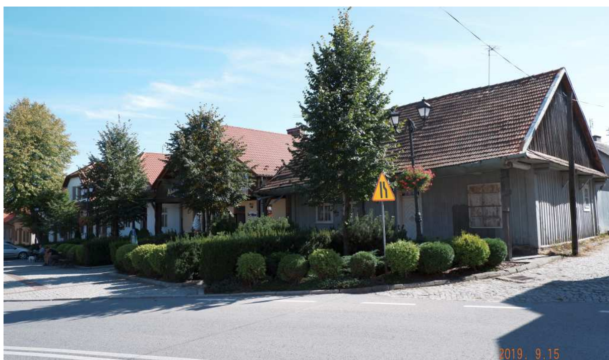
Fot. nr 22 (22-23). Pierzeja południowa.
