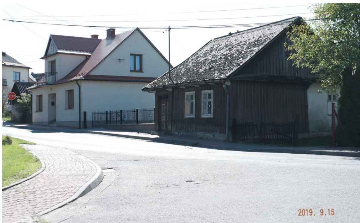
Fot. nr 62. W tle przebudowany obiekt pod nr 60.
