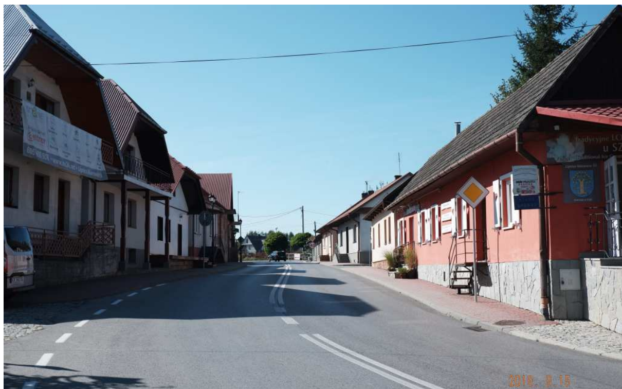
Fot. nr 51. Fragment drogi wojewódzkiej nr 966 przy wylocie z Rynku ku Muchówce.
