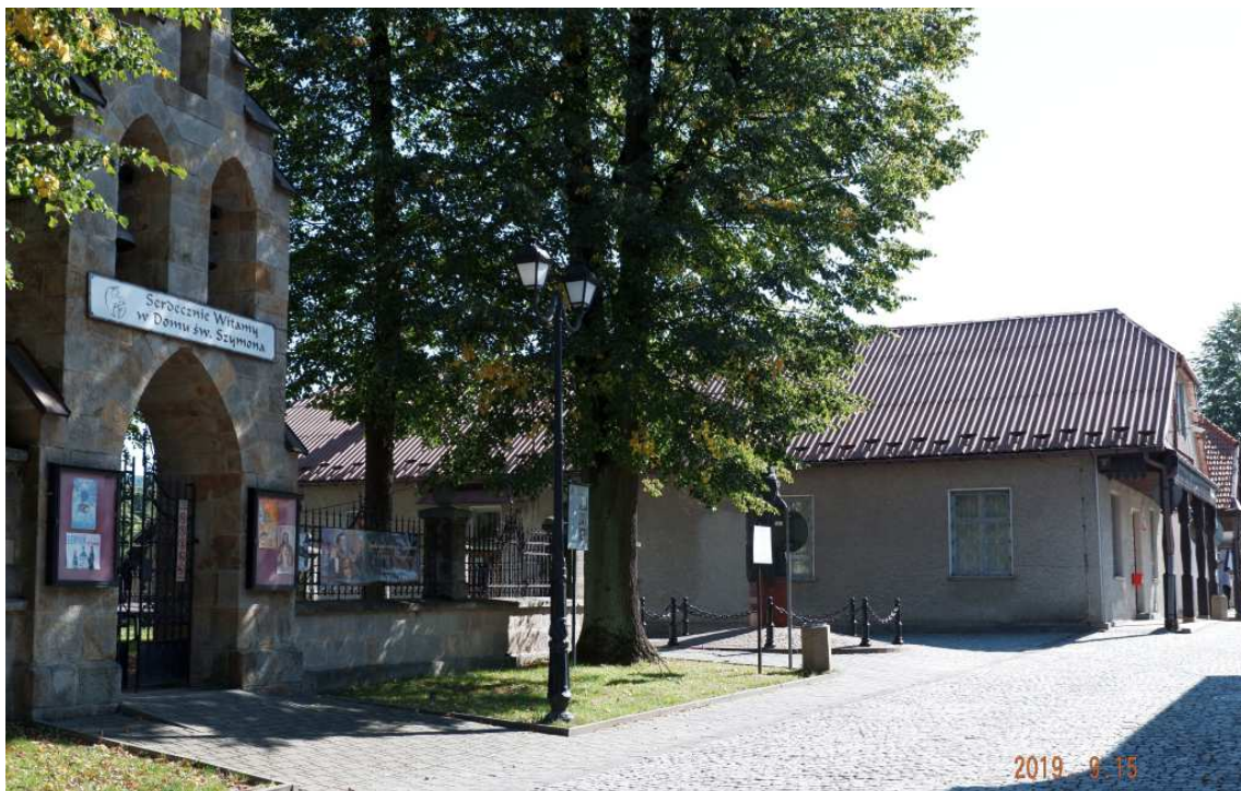
Fot. nr 123 (123-129). Kościół św. Szymona, który znajduje się w rejestrze zabytków i jego przedpole.
