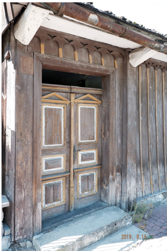
Fot. nr 61. Oryginalne drzwi, choć już bez świetlika w ich górnej części.
