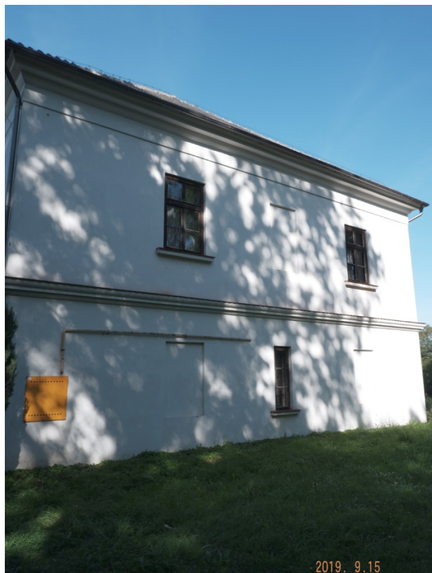
Fot. nr 203. Ściana południowa.
