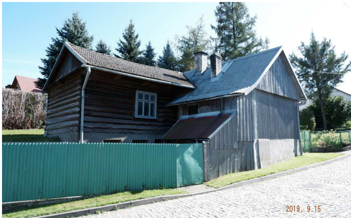
Fot. nr 95 (95-98). Dom pod nr 39, zapewne międzywojenny i jego detale. Nie jest wpisany do ewidencji zabytków, choć na to zasługuje.
