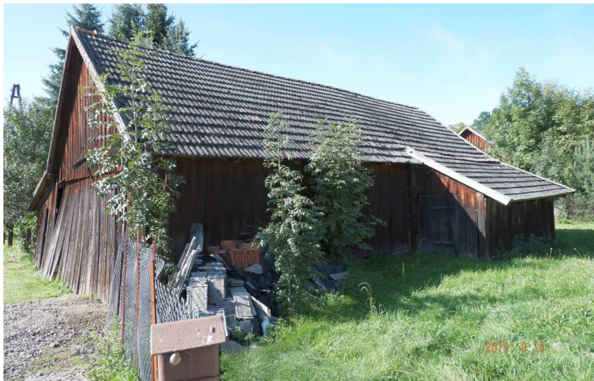
Fot. nr 189. Stodoła z sąsiedztwa cmentarza i drogi wojewódzkiej nr 966 (na posesji nr 237?)
