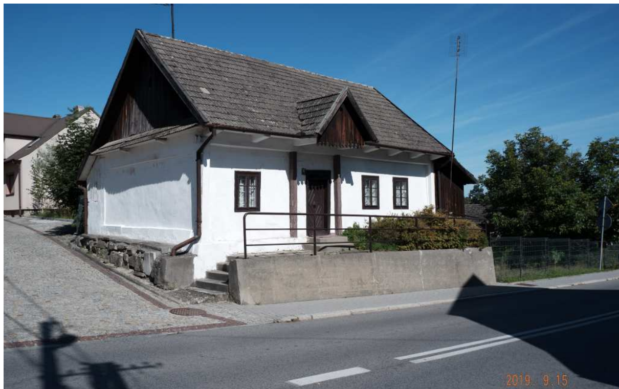
Fot. nr 135 (135-136). Fasada podcieniowego domu, który (o dziwo) nie widnieje w ewidencji zabytków, a jest to obiekt o typowo klasycystycznych cechach.
