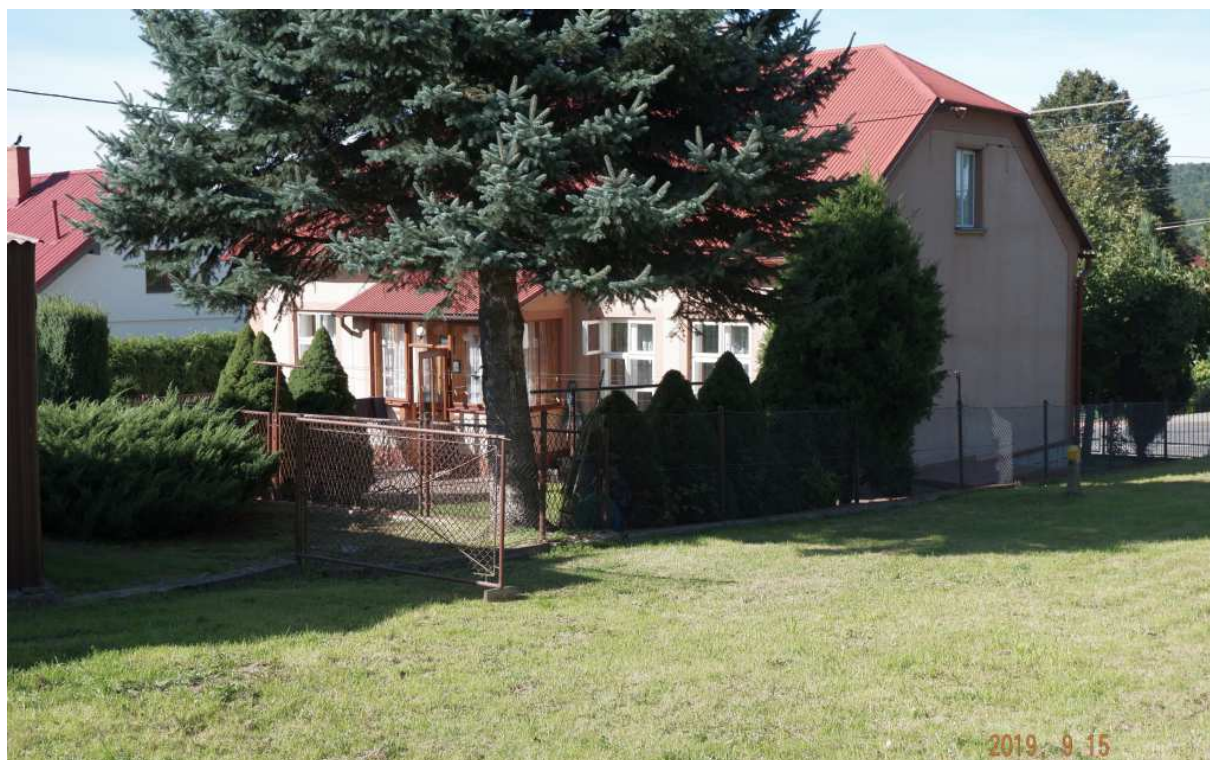
Fot. nr 195. Tylina część domu.
