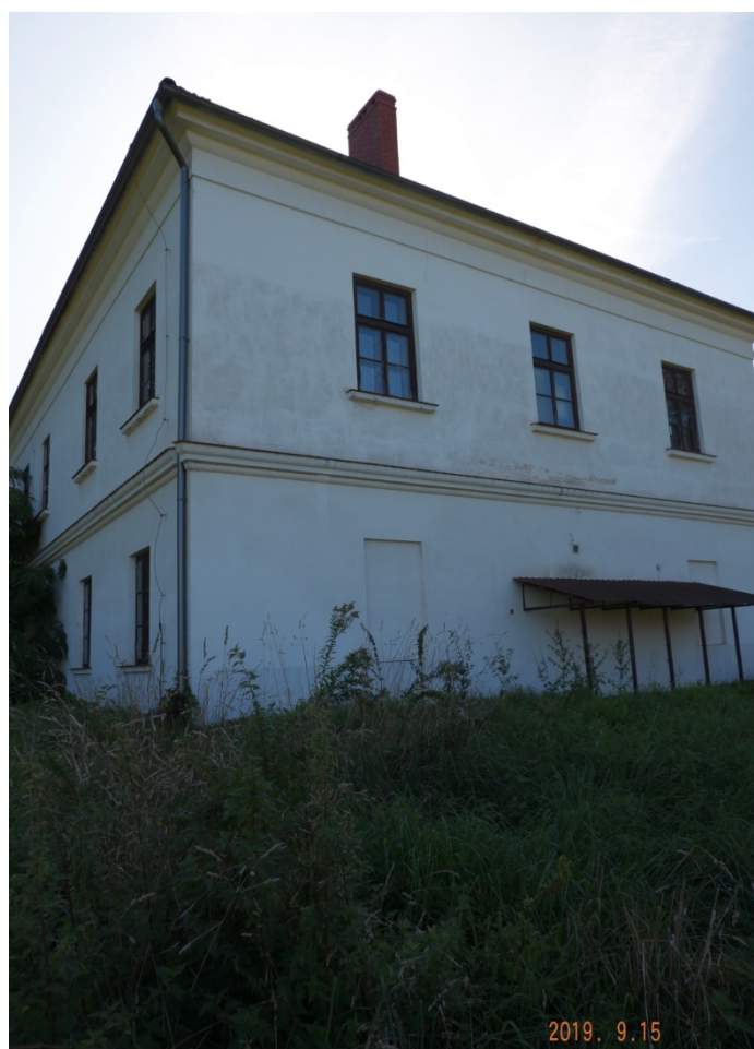
Fot. nr 206. Ściana północna.
