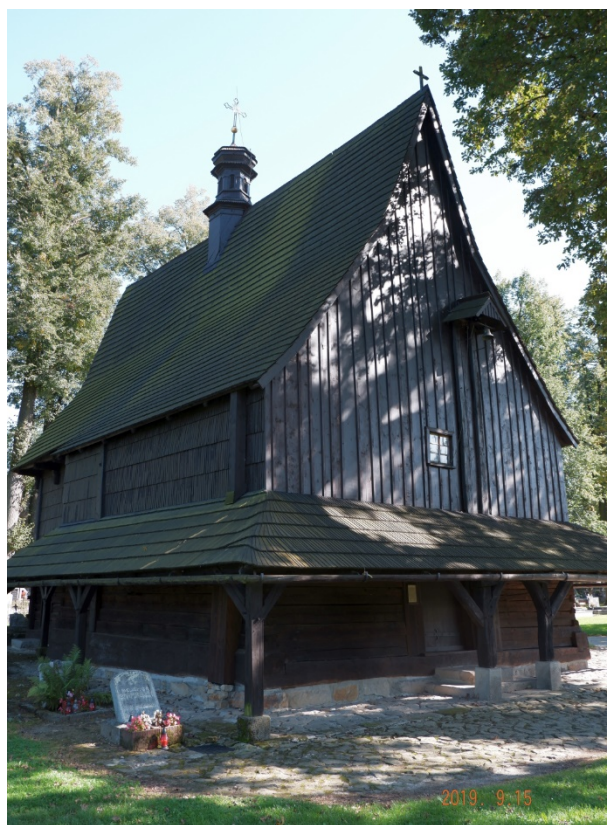
Fot. nr 152. Widok na nawę kościoła od strony zachodniej.
