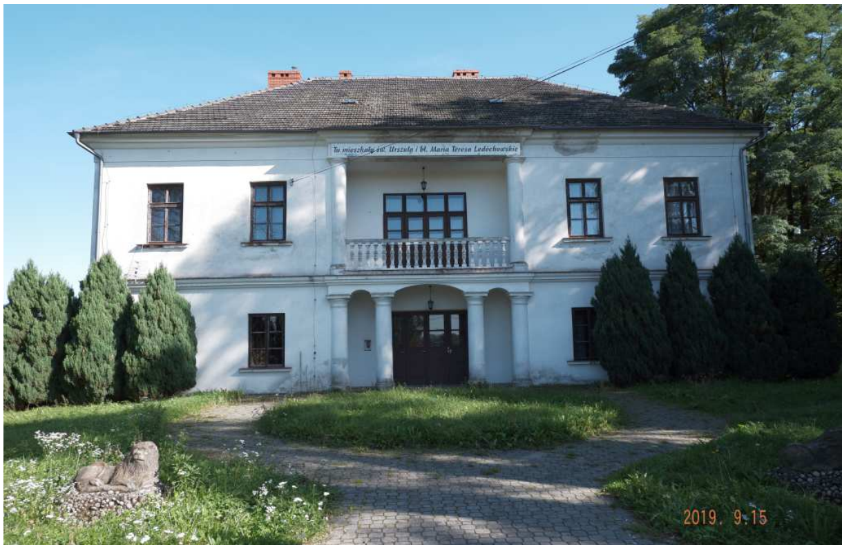
Fot. nr 200 (200-206). Dwór Leduchowskich na skraju Lipnicy Dolnej (nr 229). Obiekt z II ćwierci XIX wieku.
