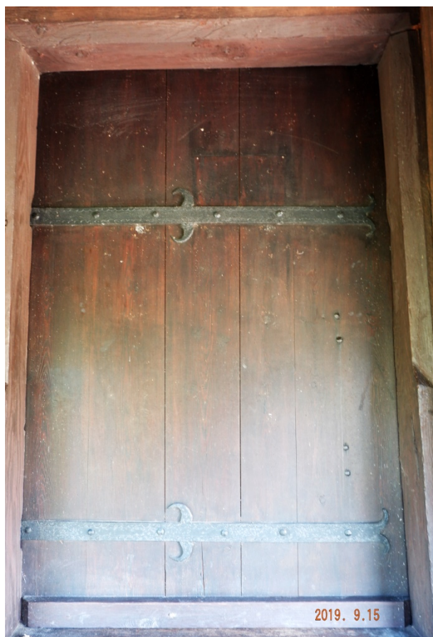
Fot. nr 151. Drzwi od strony zachodniej.
