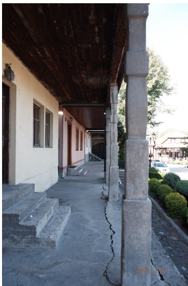
Fot. nr 38. Podcienie z kolumnami.
