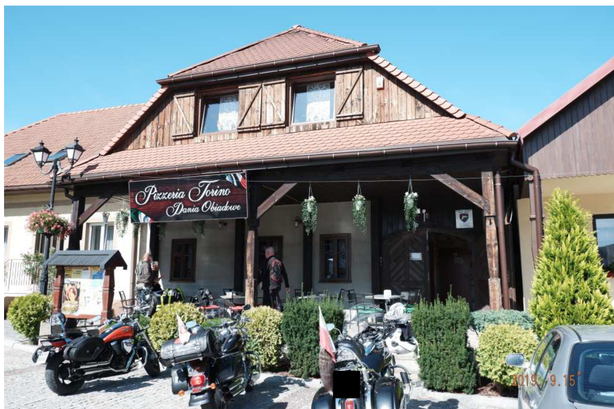
Fot. nr 32. Dom pod nr 22. Obiekt z roku 1841, wpisany do rejestru zabytków.
