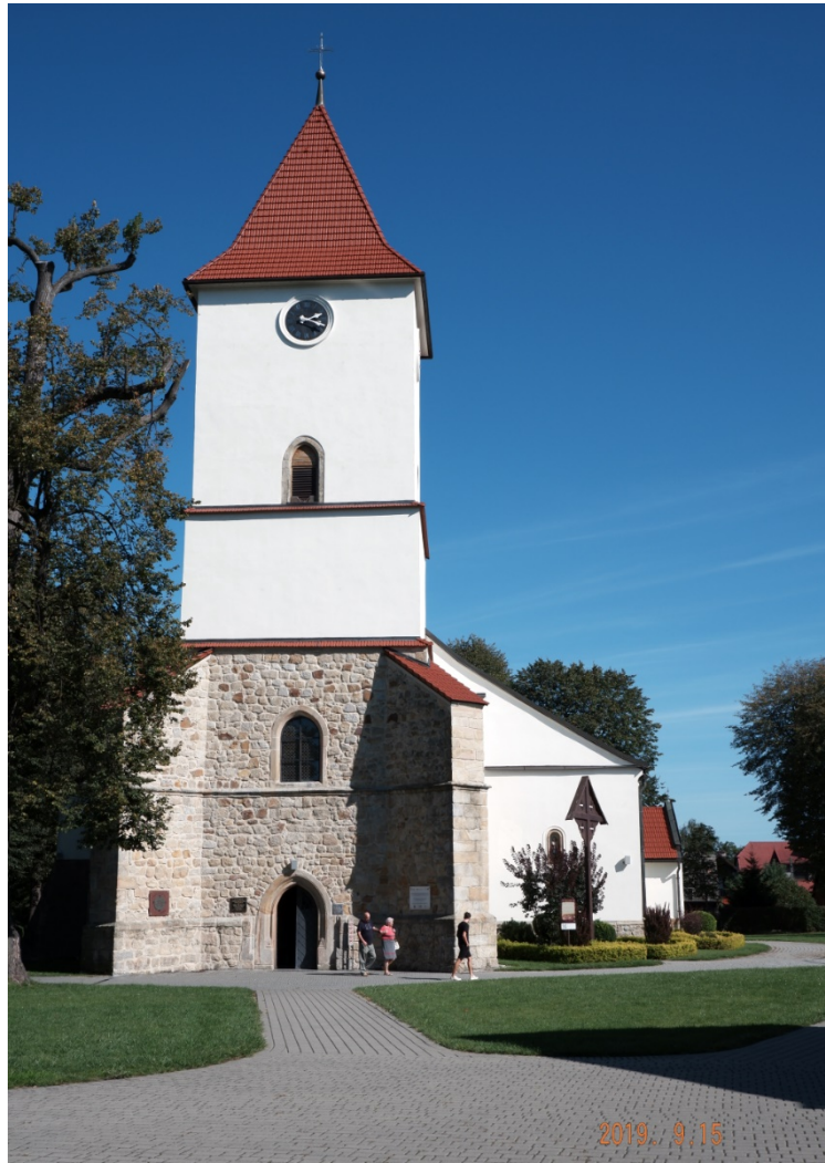
Fot. nr 79. Fasada gotyckiego obiektu, który figuruje w rejestrze zabytków.
