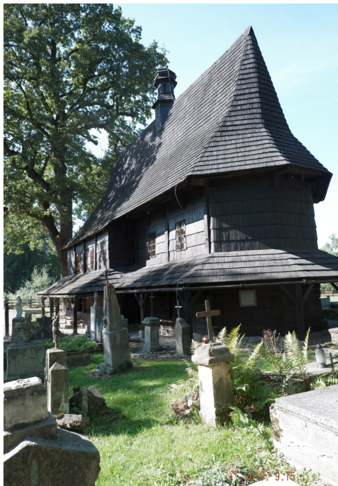
Fot. nr 157 (157-158). Cmentarne otoczenie kościoła od stron: wschodniej i południowej.
