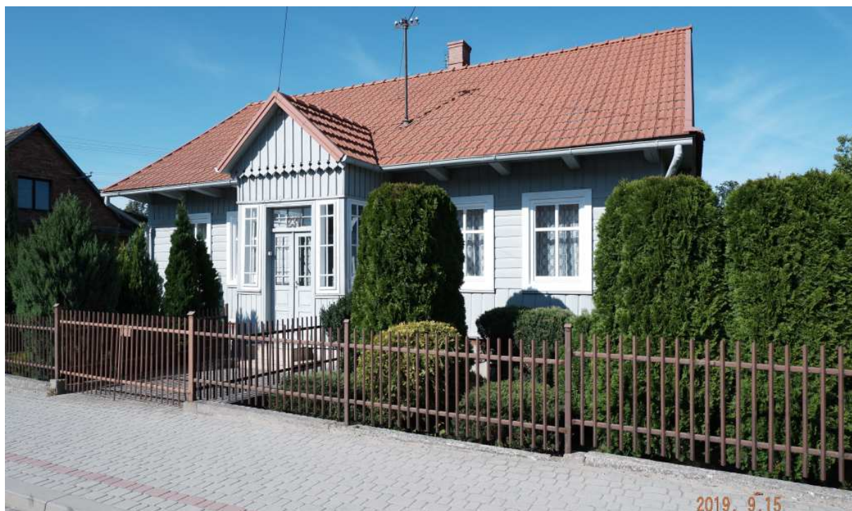
Fot. nr 191 (191-192). Dom spod nr 237, pochodzący zapewne z I ćwierci XX wieku. Obiekt nie znajduje się w ewidencji zabytków.
