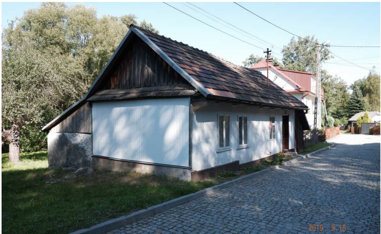
Fot. nr 102 (102-103). Chałupa pod nr 76. Nie jest wpisana do ewidencji zabytków, choć może pochodzić z I ćwierci XX wieku.
