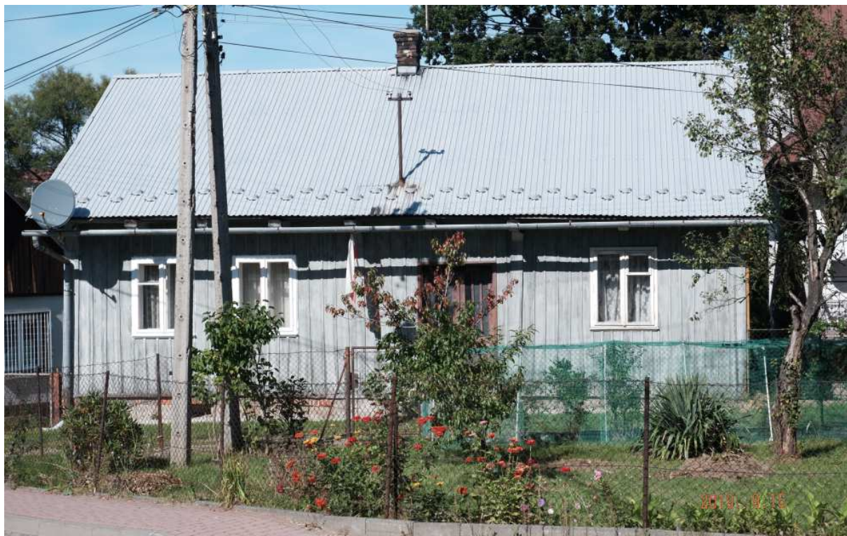
Fot. nr 68. Dom pod nr 67. Nie ma go w ewidencji zabytków.
