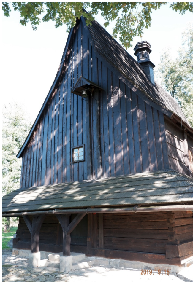
Fot. nr 149 (149-151). Ściana frontowa nawy w ujęciu od strony zachodniej.
