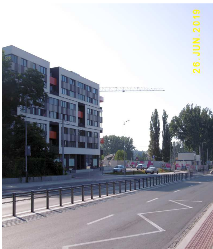
Fot. nr 195. Trwa zabudowa przestrzeni po niskich domach przy ulicy Wielickiej 105-111.
