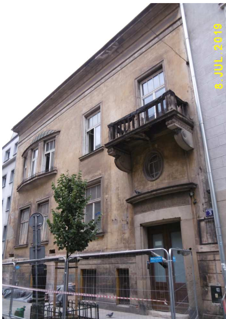
Fot. nr 89. Jak po remoncie będzie wyglądała kamienica prof. Natansona z ulicy Studenckiej 3? W jej parterze ma zostać utworzone trywialne pomieszczenie sklepowe.
