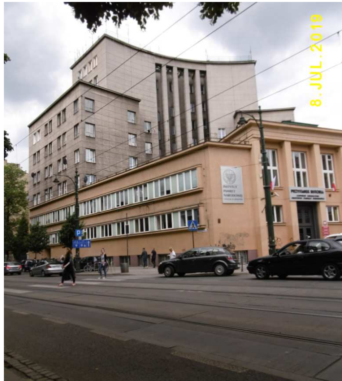
Fot. nr 119 (119-120). Budynek dawnego gmachu Banku Rolnego, który powstał w miejscu neogotyckiego budynku hotelu Krakowskiego, wyburzonego pod koniec lat 30.
