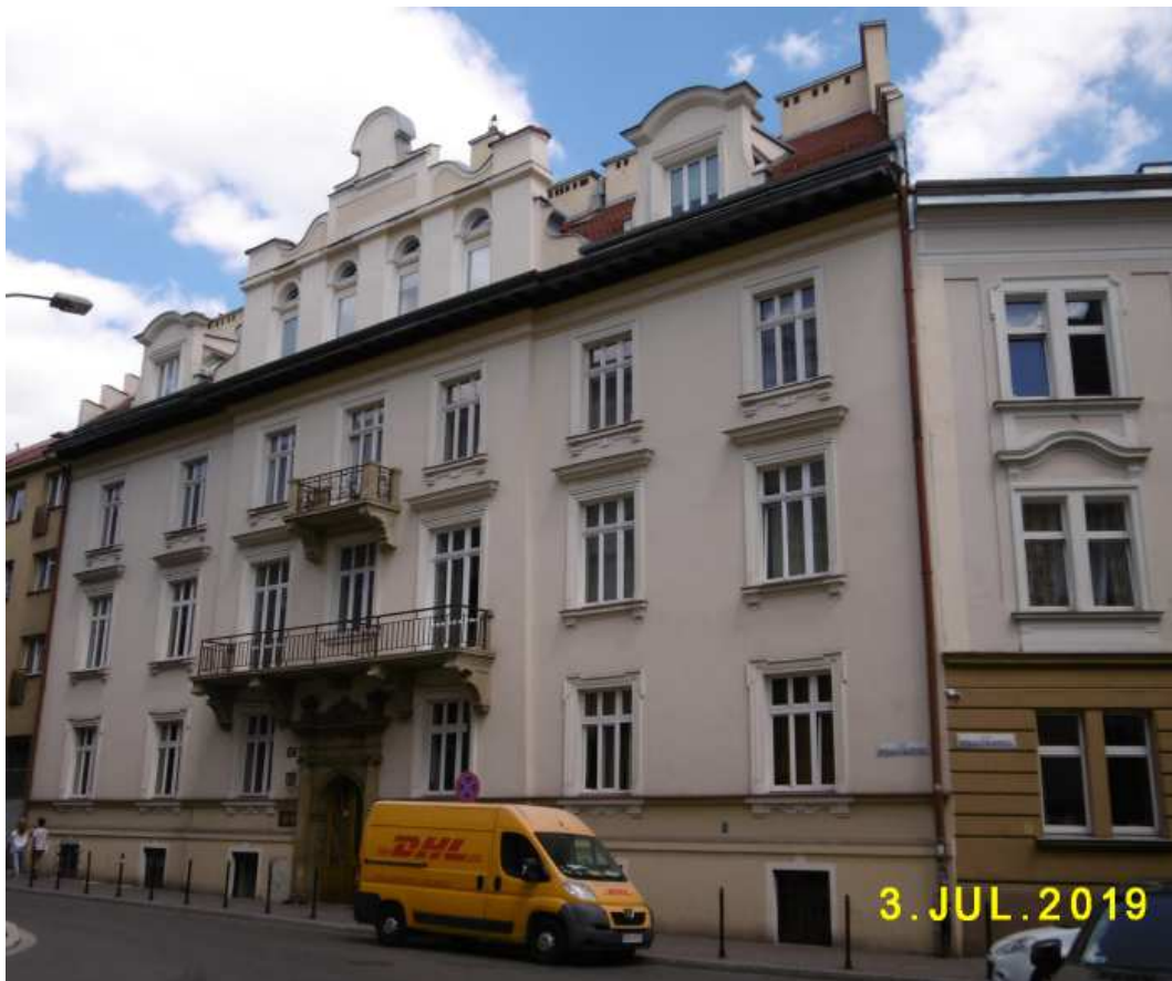
Fot. nr 70 (70-72). Neorenesansowa kamienica z ulicy Zybkiewicza 8.
