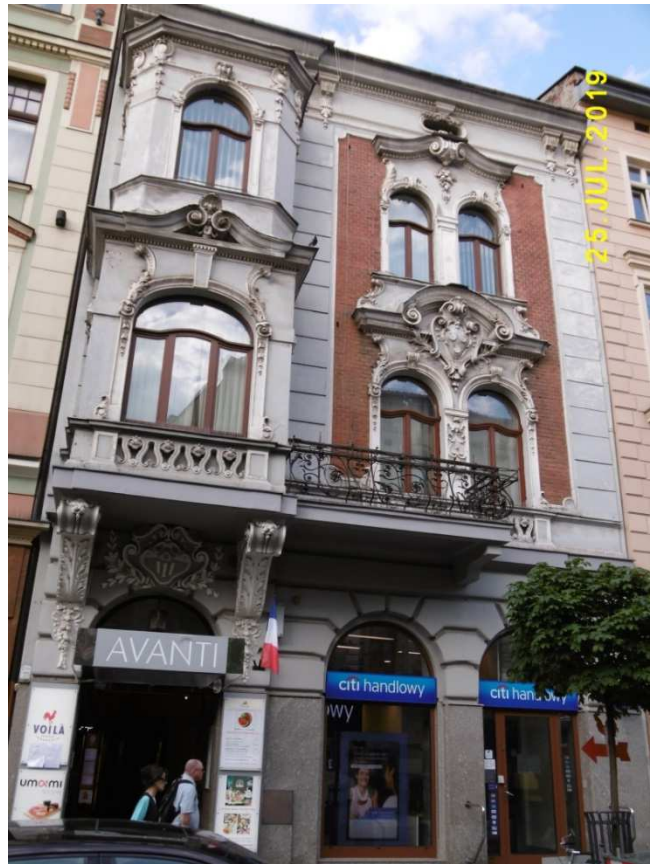
Fot. nr 105. Eklektyczna kamienica spod nr 7.
