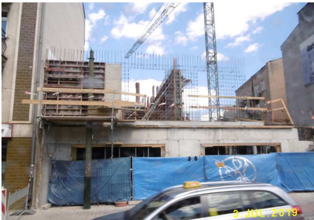
Fot. nr 183. W miejscu dawnej budki z artykułami spożywczymi Tomasza Jędrzejowskiego przy ulicy Limanowskiego 37 powstaje nowy blok.
