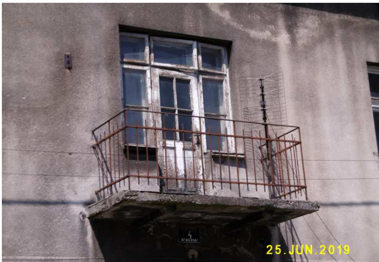
Fot. nr 130. Oryginalna stolarka drzwi i okna ganku I piętra.
