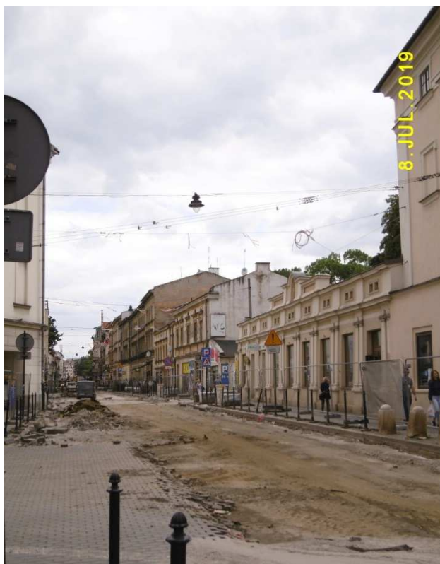
Fot. nr 101 (101-105). Kilka migawek z ulicy Karmelickiej, na której trwa remont.
