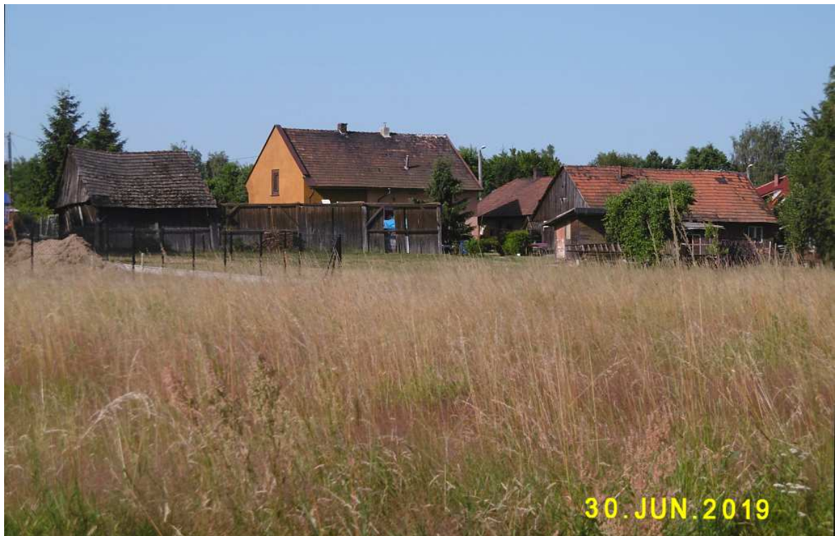
Fot. nr 228 (228-231). Spodziewane przeze mnie od dawna zawalenie się fragmentu rozległej stodoły w dawnej zagrodzie przy ulicy Przewiewnej 11.
