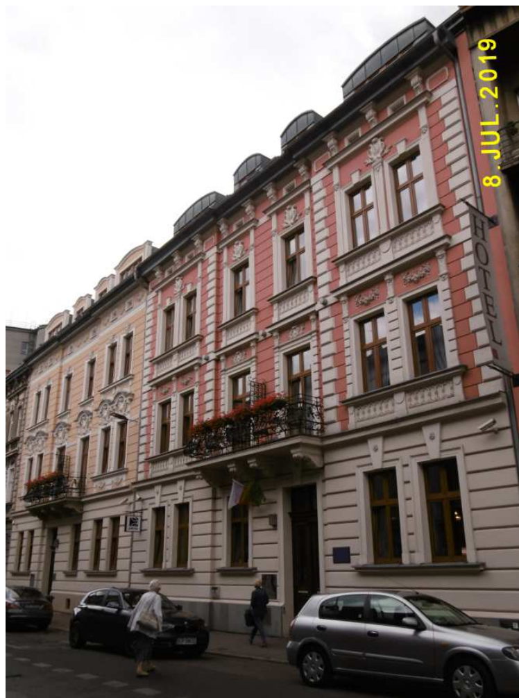
Fot. nr 116. Odnowione kamienice pod nr 6 i 8, zamienione na hotel.
