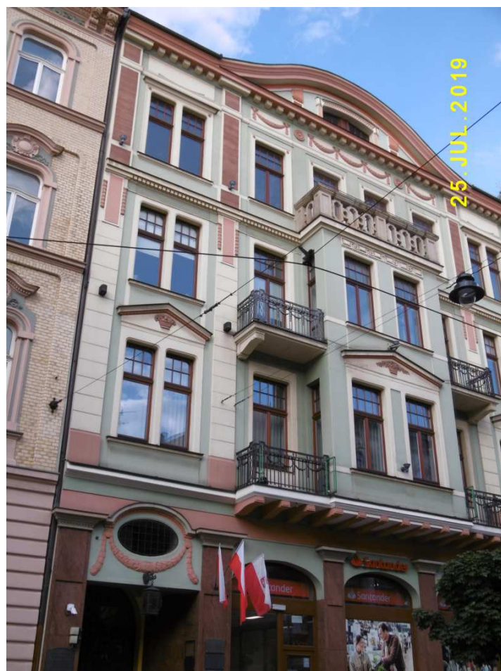
Fot. nr 104. Secesyjna kamienica spod nr 9 po udanej odnowie.
