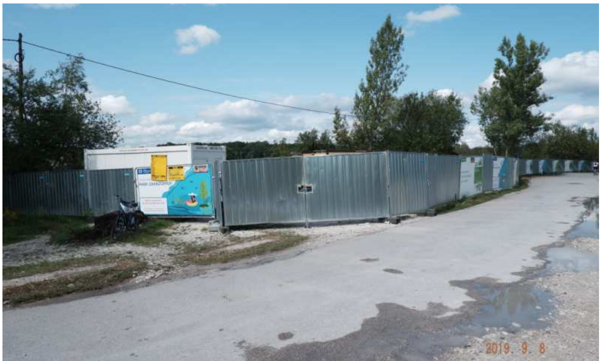
Fot. nr 171 (171-174). Przy zbiorniku na Zakrzówku zaczęły się jakieś prace rewitalizacyjne i obecnie jest on wyjątkowo szczelnie otoczony przez zasieki.
