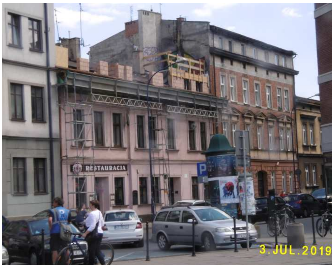
Fot. nr 182. Trwa nadbudowa domu przy ulicy Lwowskiej 4.
