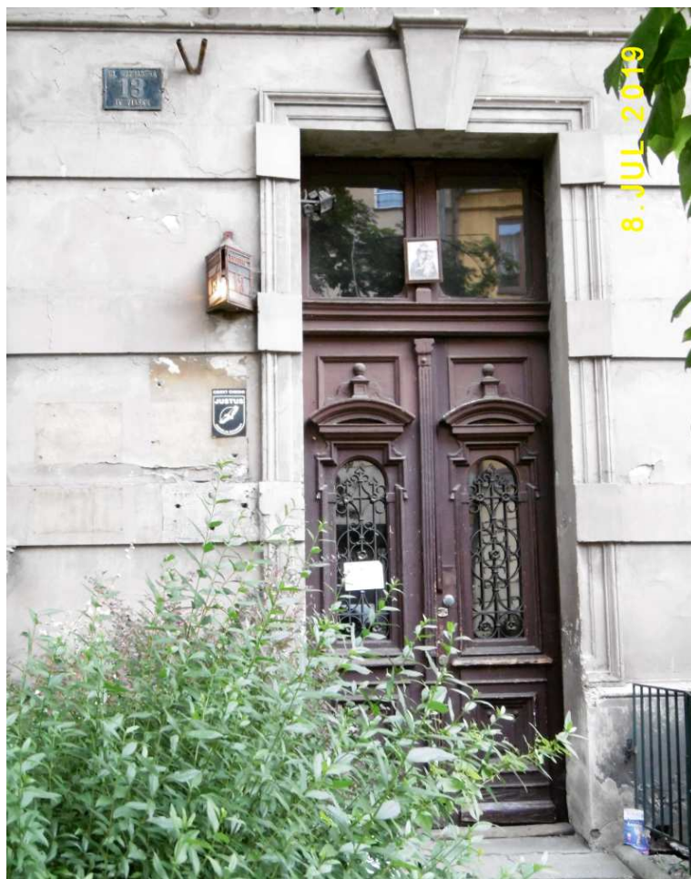
Fot. nr 111 (111-113). Detale kamienicy pod nr 13.
