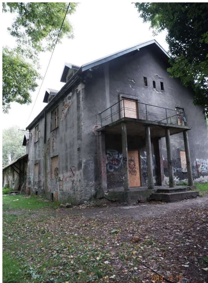
Fot. nr 200. Wejście do dworu od strony ulicy Estońskiej.
