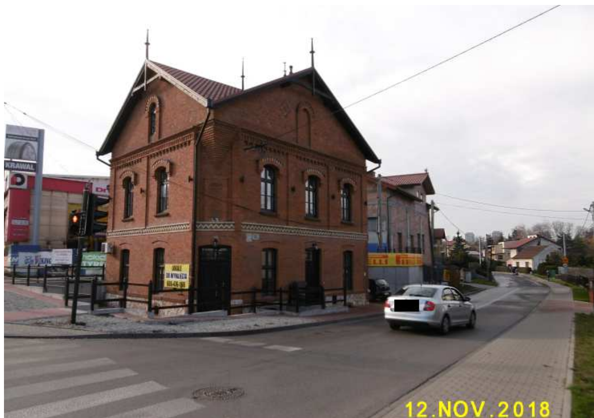
Fot. nr 178. Budynek Sokoła z ulicy Cienistej 1.
