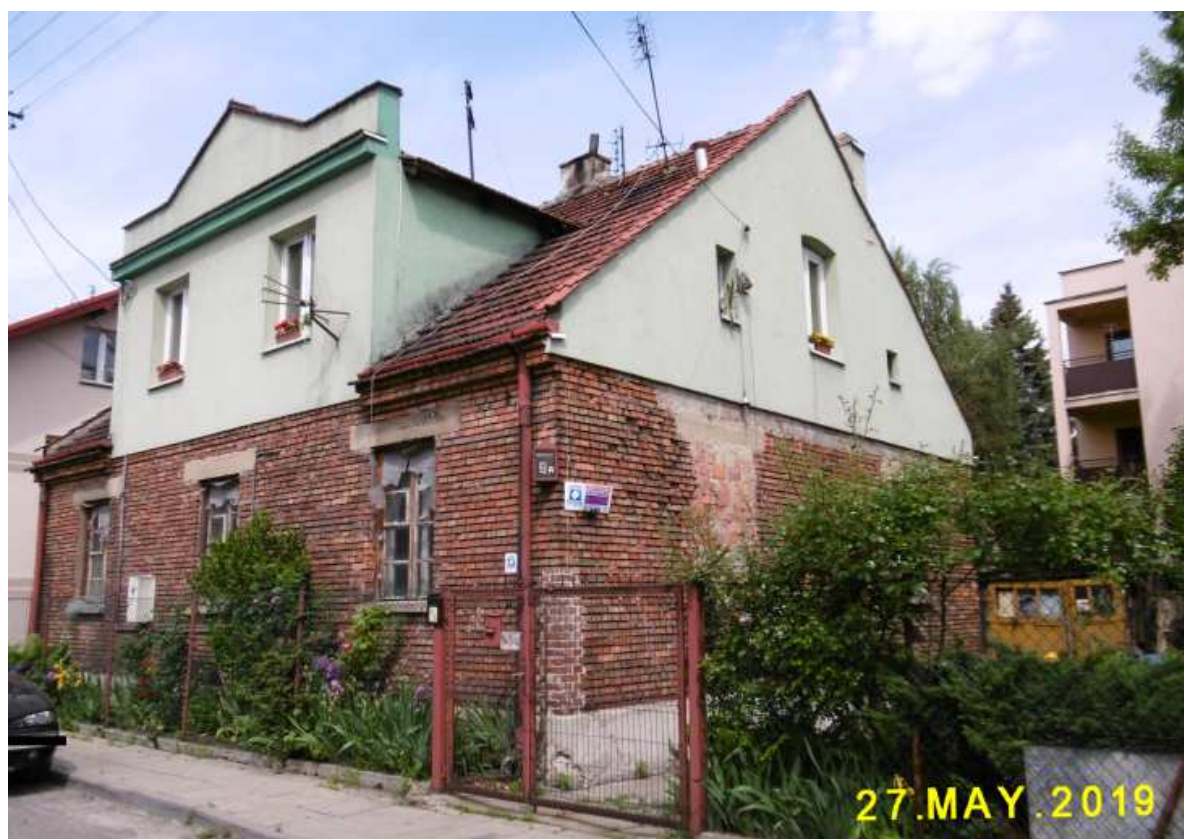
Fot. nr 55. Nieco już przekształcony fasada przedwojennego domu pod nr 8a.
