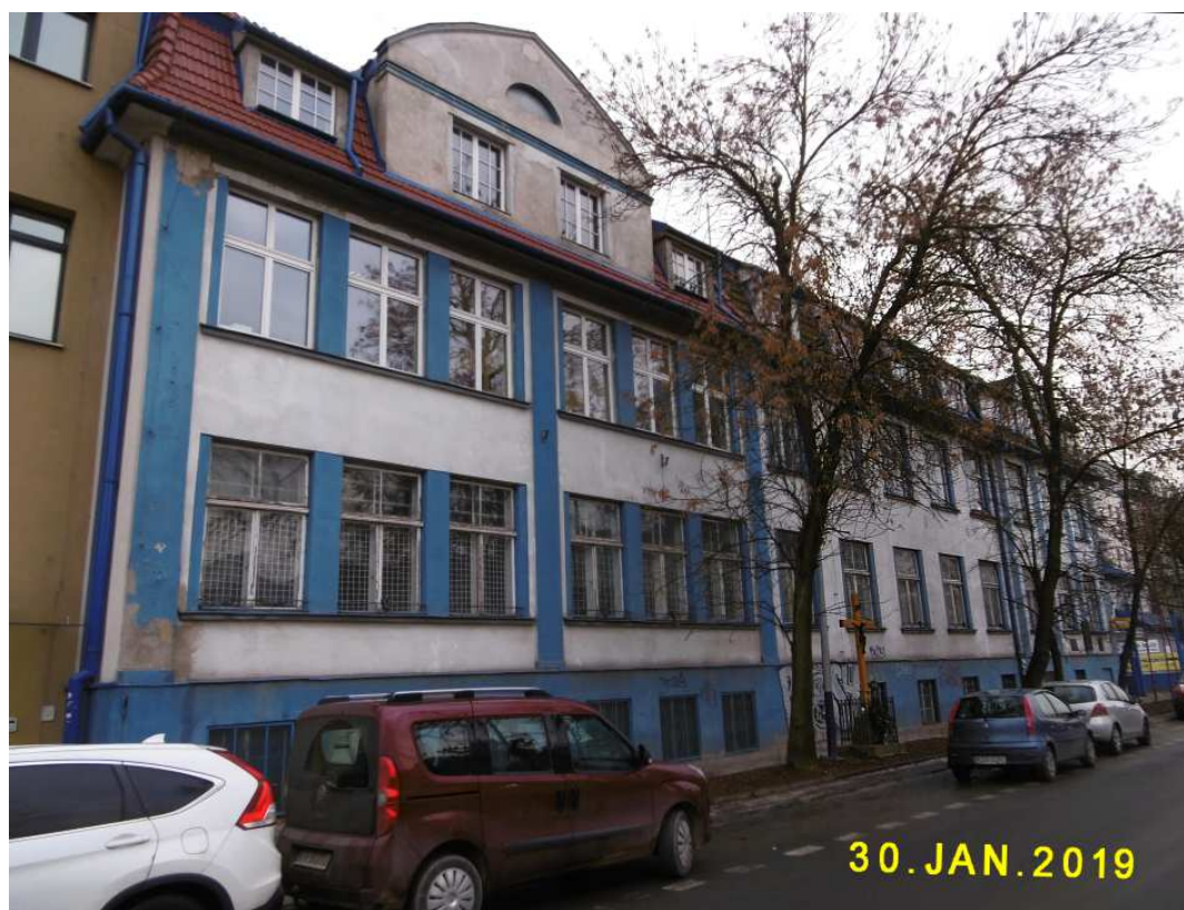
Fot. nr 161. Ponad stuletni budynek dykcji i administracji.
