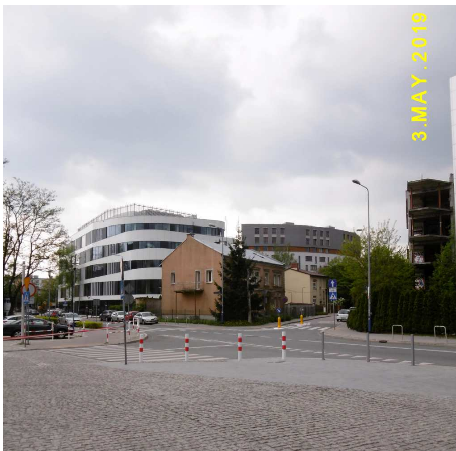
Fot. nr 321. Resztki niskiej zabudowy ulicy Twardowskiego u wylotu do ulicy Bułhaka.
