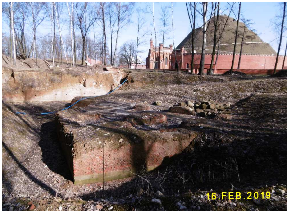
Fot. nr 264. Odkopana część przyziemna bastei pomiędzy bastionami I i II.
