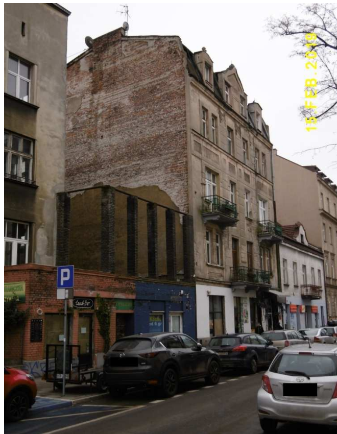
Fot. nr 217 (217-219). Pozostałości po wiszącym ogrodzie kamienicy z ulicy Rajskiej 20.
