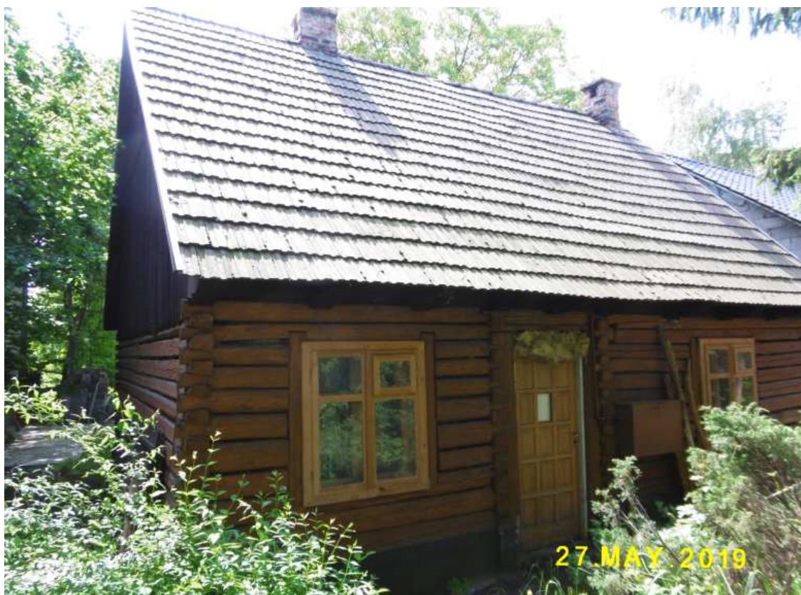
Fot. nr 72 (72-74). Dawna chałupa z ulicy Bularnia 1 na etapie remontu.
