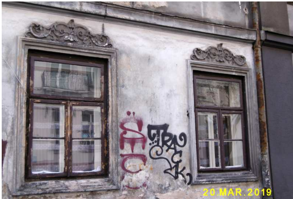
Fot. nr 239. Ostatnie oryginalne okna w prawej części parteru.
