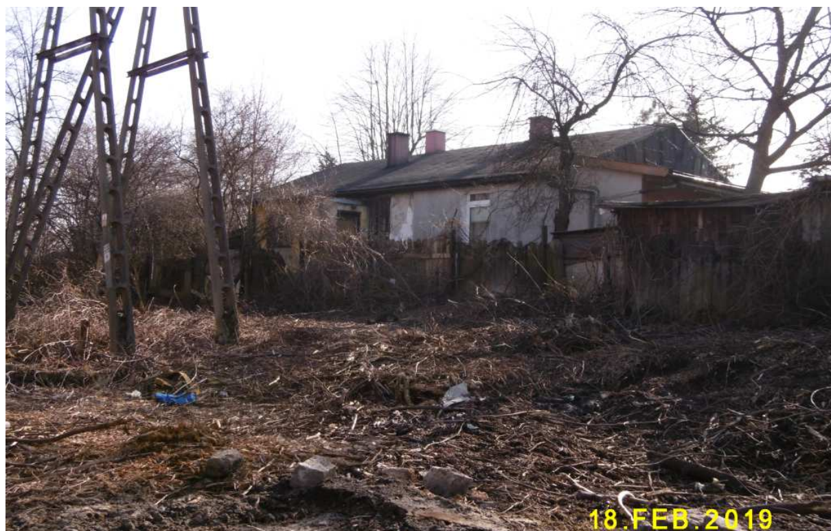
Fot. nr 458. Stara zagroda kolejowa przy ulicy Stacyjnej 30.
