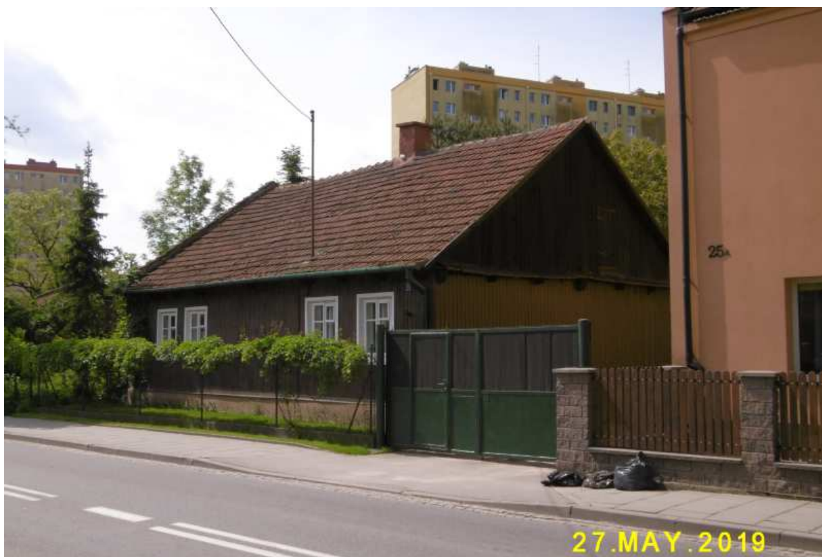
Fot. nr 66 (66-69). Chałupa pod 25, a obok (z lewej) pod nr 23 pustka po niedawno wyburzonym domu.
