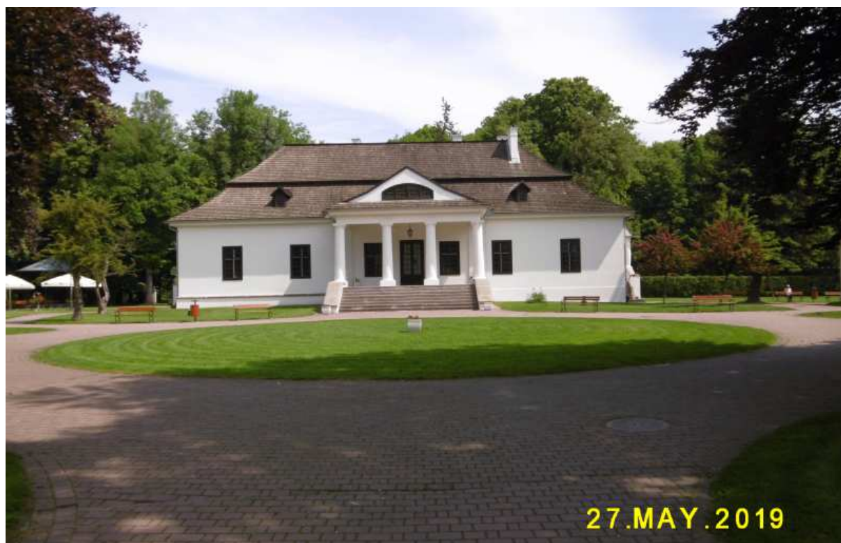
Fot. nr 106 (106-108). Fasada dworku, który pospołu z oficynami powstał w II połowie XVIII wieku.
