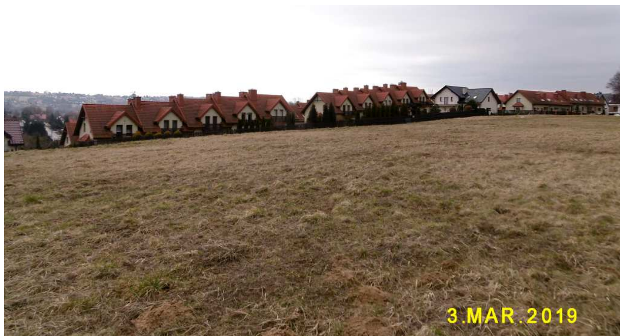
Fot. nr 512. Nowa zabudowa wzdłuż ulicy Chabrowej.
