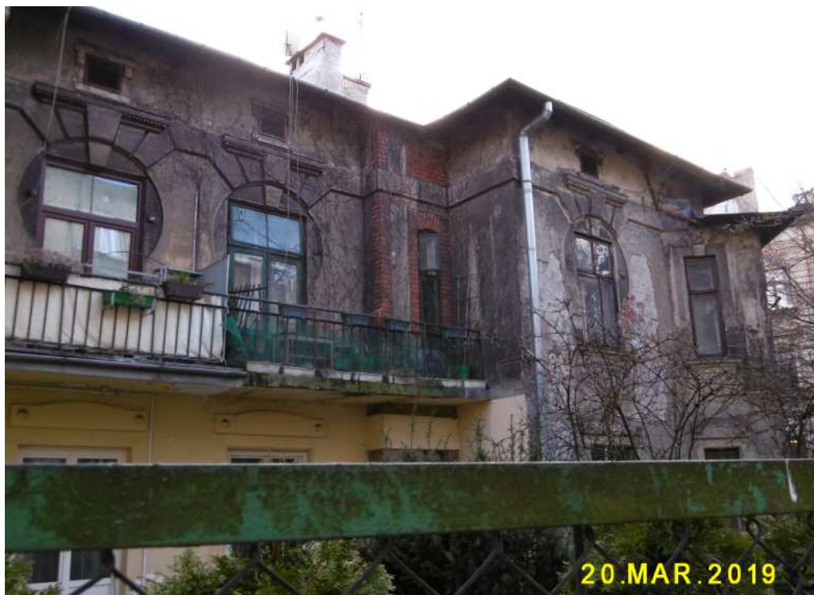
Fot. nr 234. Piętro fasady od strony ulicy Grabowskiego.
