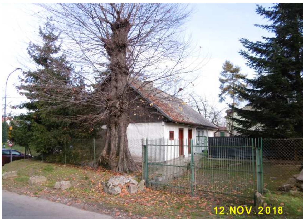
Fot. nr 181 (181-182). Widoki od strony podwórka z ulicy Szybkiej.
