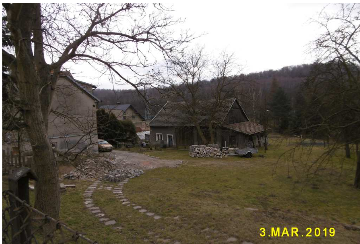
Fot. nr 486. Stara zagroda pod nr 43 na etapie rozbiórki.
