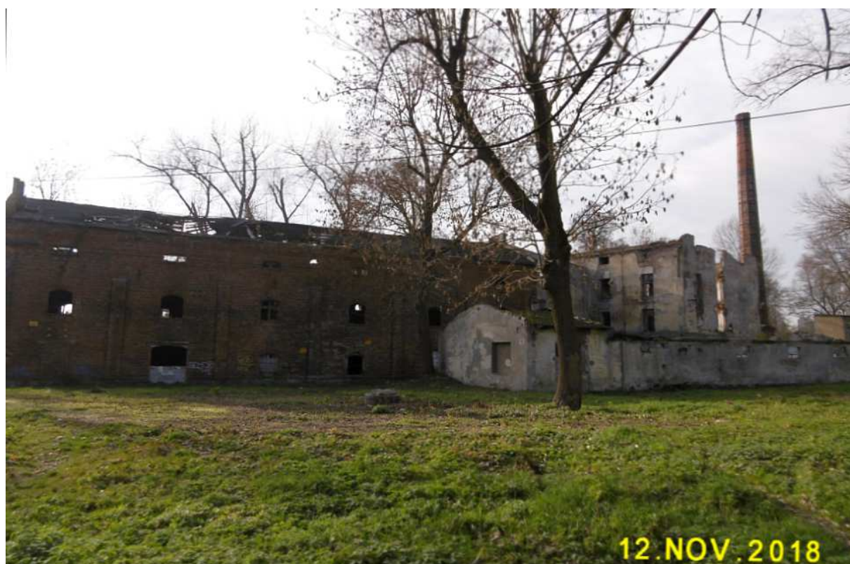
Fot. nr 176 (176-177). Pozostałości po bieńczyckim młynie przy ulicy Kocmyrzowskiej 3.
