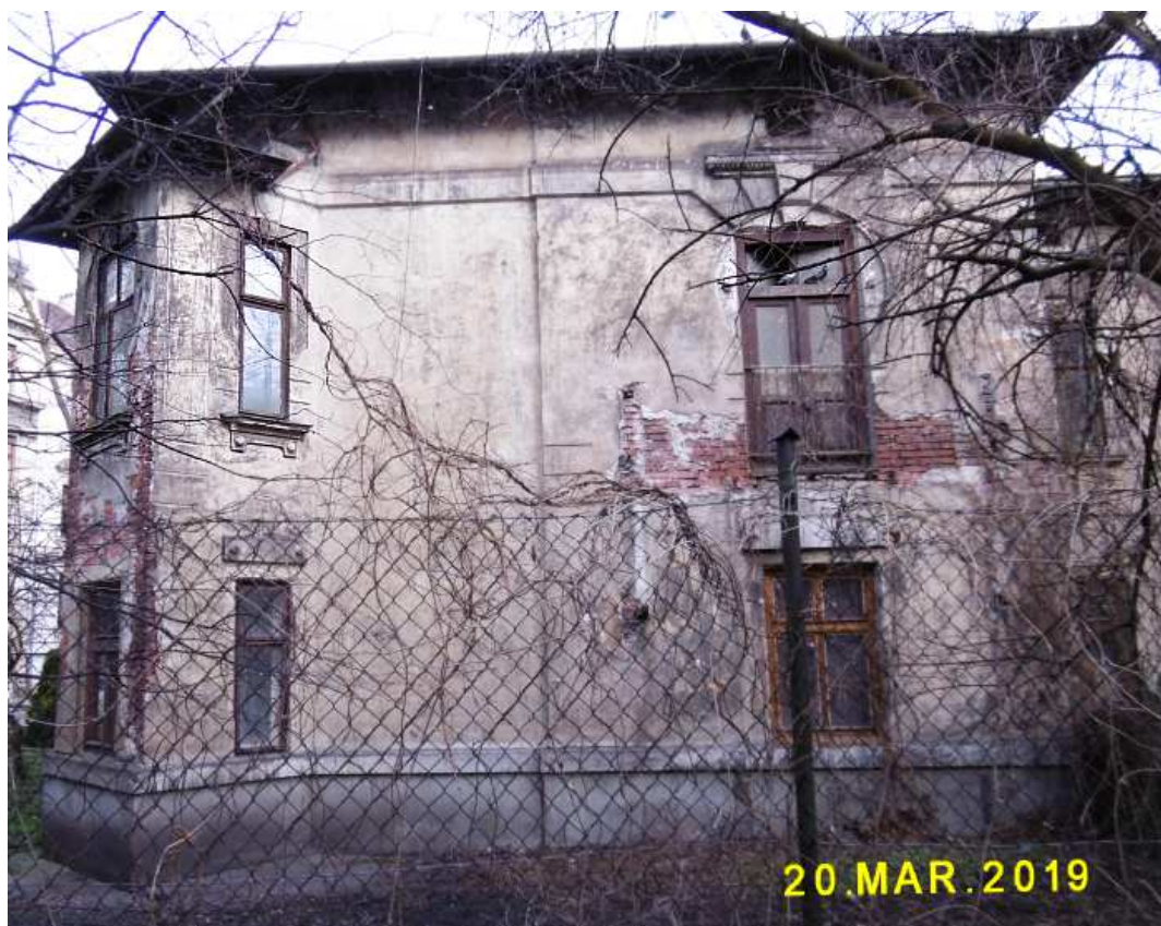
Fot. nr 232 (232-233). Wykusz w narożniku, a nim oryginalne okna I piętra.
