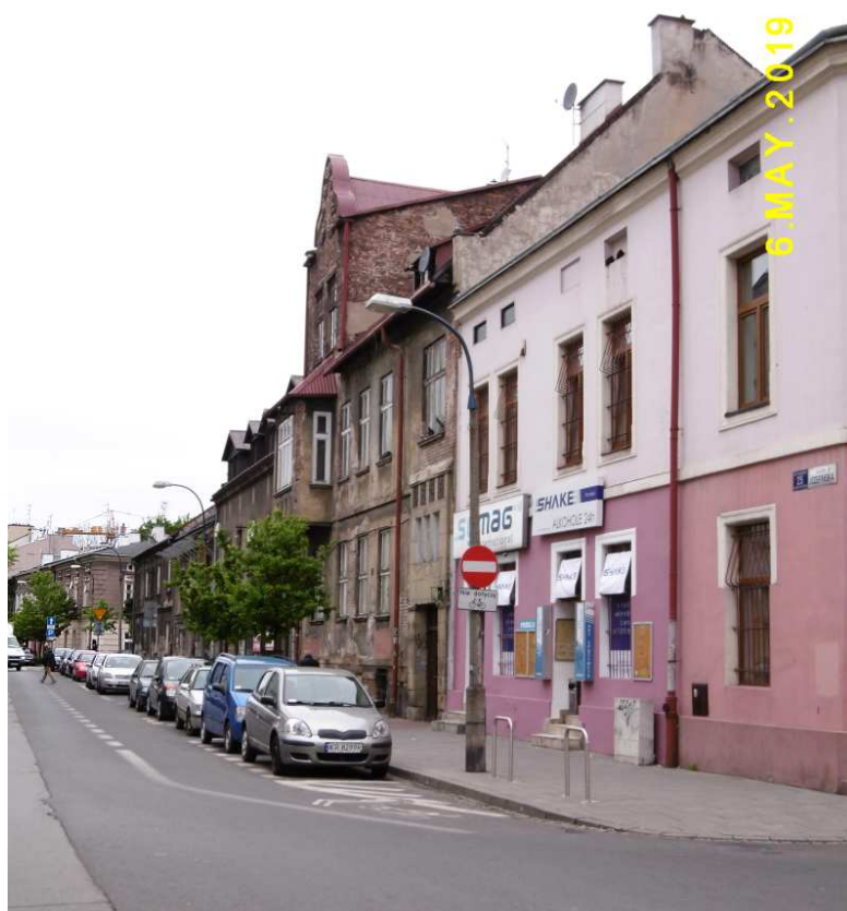
Fot. nr 369. Zabudowa Ulicy Józefińskiej poniżej nr 25 – widok z ulicy Targowej.
