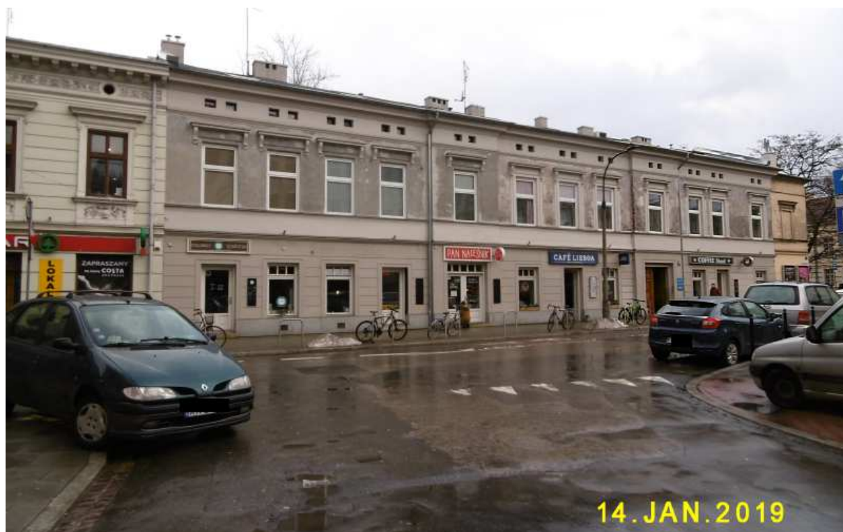
Fot. nr 213 (213 (213-216). Dom pod nr 3, istniejący od początku XIX wieku. Współczesne okna zniszczyły wygląd oryginalnej fasady, która trwała do końca XX wieku.
