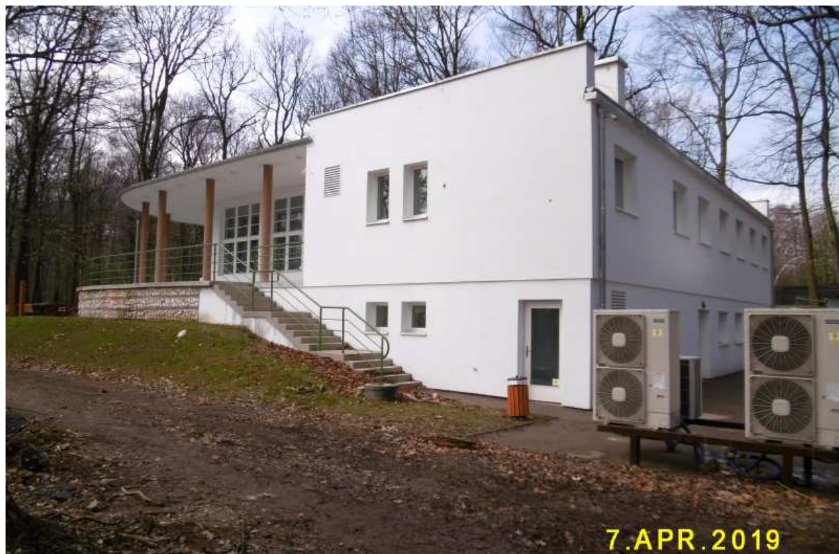
Fot. nr 316 (316-319). Po latach zaniedbań Pawilon Okocimski, znany przedwojenny obiekt gastronomiczno-rozrywkowy przy polanie Lea, znów błyszczy dawnym blaskiem.
