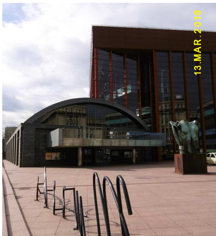
Fot. nr 45. Budynek Operetki przy ulicy Lubicz 48 po przebudowie z Domu Żołnierza i wylukrowaniu jego fasady.
