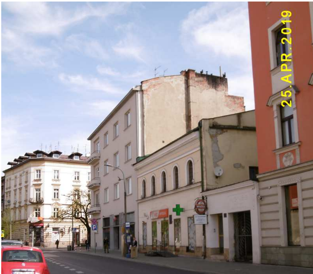
Fot. nr 2. Fragment zabudowy ulicy Krowoderskiej w sąsiedztwie placu Słowiańskiego. Na pierwszym planie budynek dawnego teatru letniego pod nr 31.
