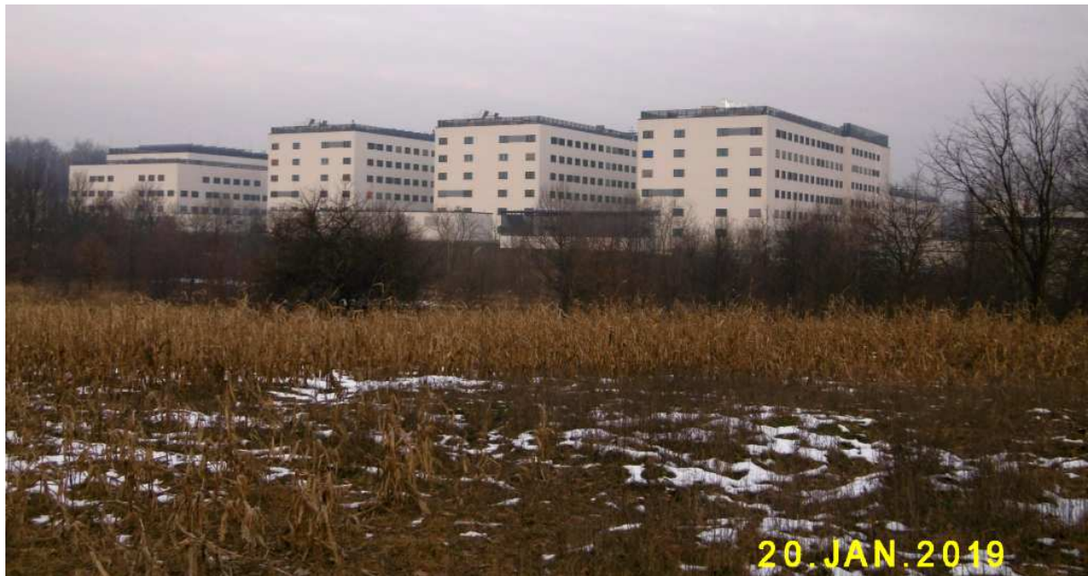
Fot. nr 482. Kompleks szpitalny UJ wzdłuż ulicy Jakubowskiego niemal gotowy.
