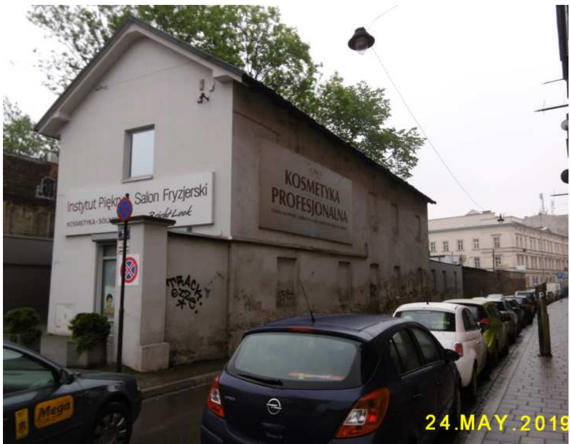
Fot. nr 29. Zabudowa końcowego odcinka ulicy Ząbki.
