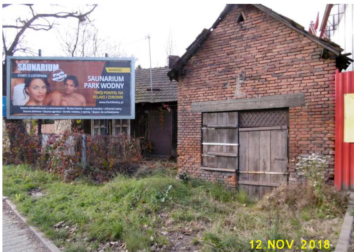
Fot. nr 179. Kompleks mieszkalno-handlowy z ulicy Kocmyrzowskiej 1 – widok z ulicy Kocmyrzowskiej.
