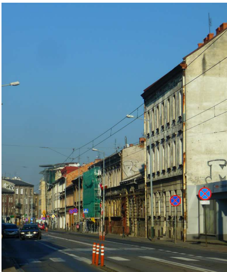
Fot. nr 341 (341-352). Wzdłuż ulicy Kalwaryjskiej. Fragment poniżej nr 57. (11.11.2018)
