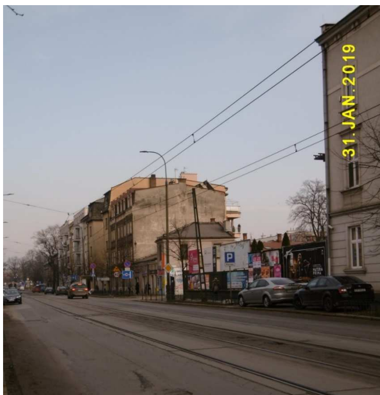
Fot. nr 255. Przy ulicy Kościuszki. Fragment zabudowy poniżej nr 36 i ślepej ulicy Jaskółczej.
