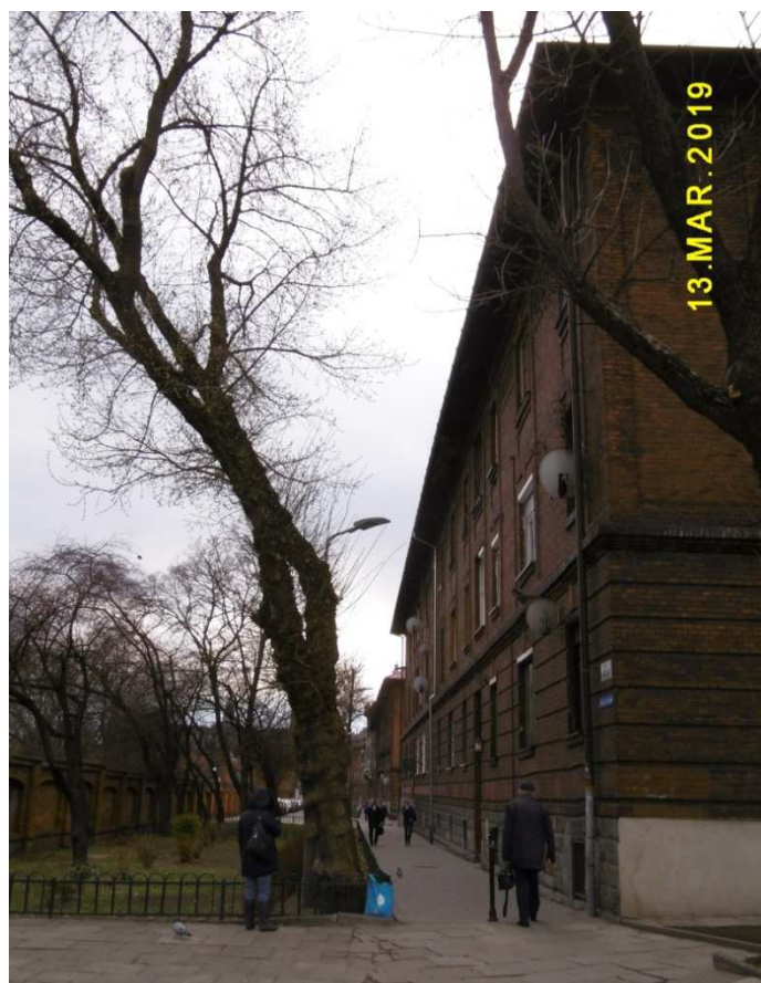
Fot. nr 41. Wzdłuż ulicy Bosackiej. Widok z ulicy Topolowej.
