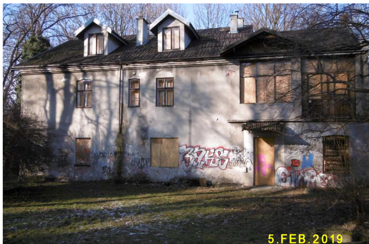
Fot. nr 407 (407-413). Kilka ujęć będącego już w stanie ruiny starego dworu Bemów z ulicy Estońskiej (formalnie Mochnackiego 71) Fot. nr. 407-407. Widoki fasady.
