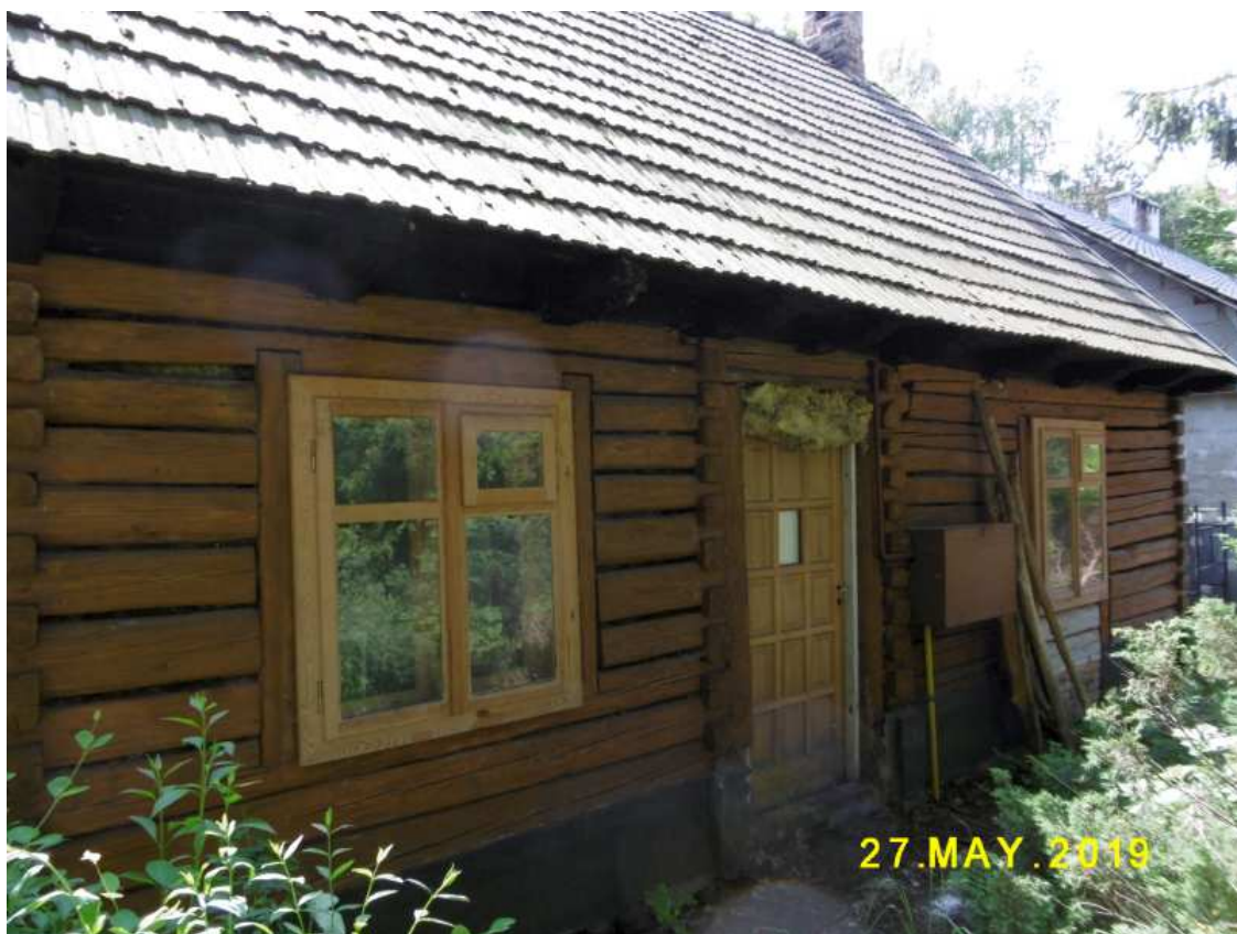
Fot. nr 73. Bliska oryginałowi fasada.
