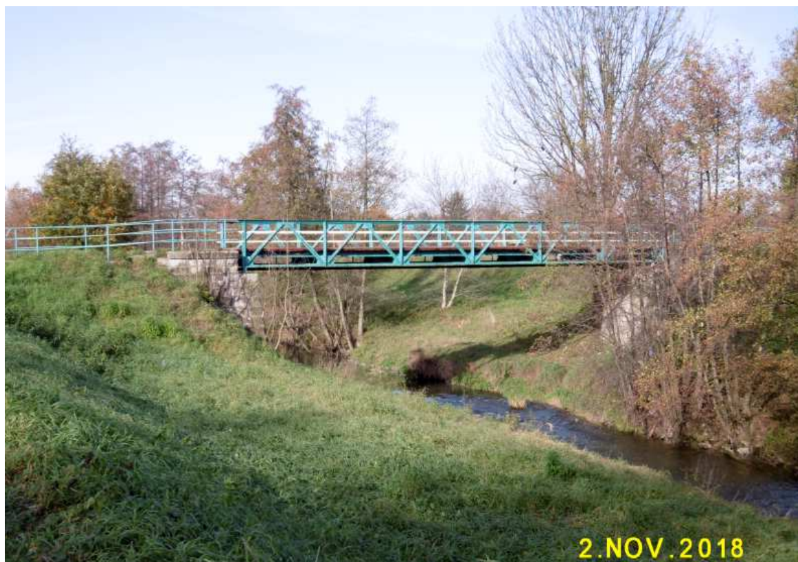
Fot. nr 290 (290-291). IV most na Rudawie.
