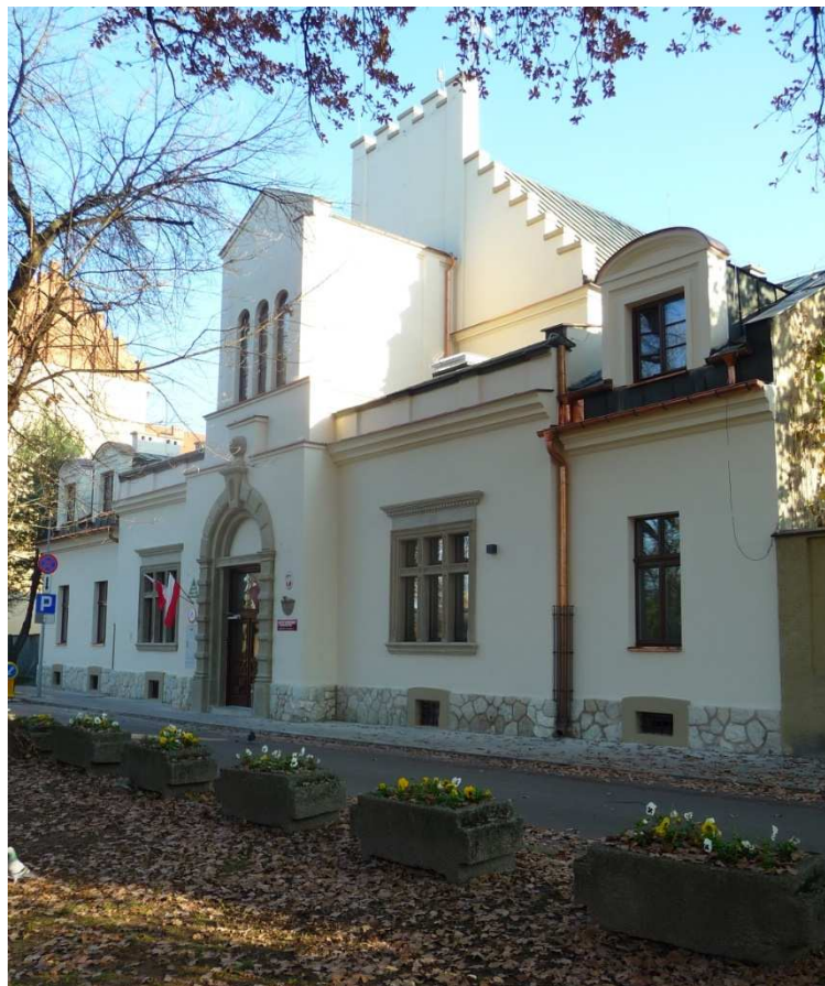
Fot. nr 357 (357-358). Podgórski Sokół z ulicy Sokolskiej 17 po odnowie. Niestety nie została mu przywrócona oryginalna fasada i wieżyczka. (11.11.2018)
