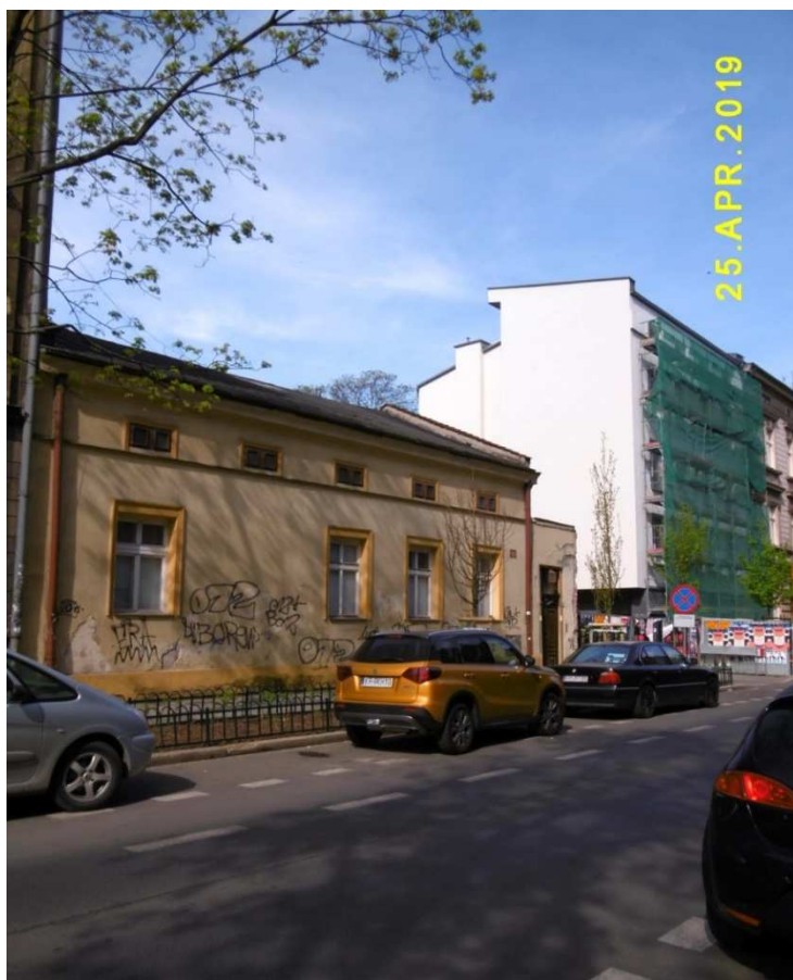
Fot. nr 245 (245-247). Parterowy dom zakonny dawnej ochronki z ulicy Krowoderskiej 38-40, do którego właśnie została dobudowana nowa kamienica.
