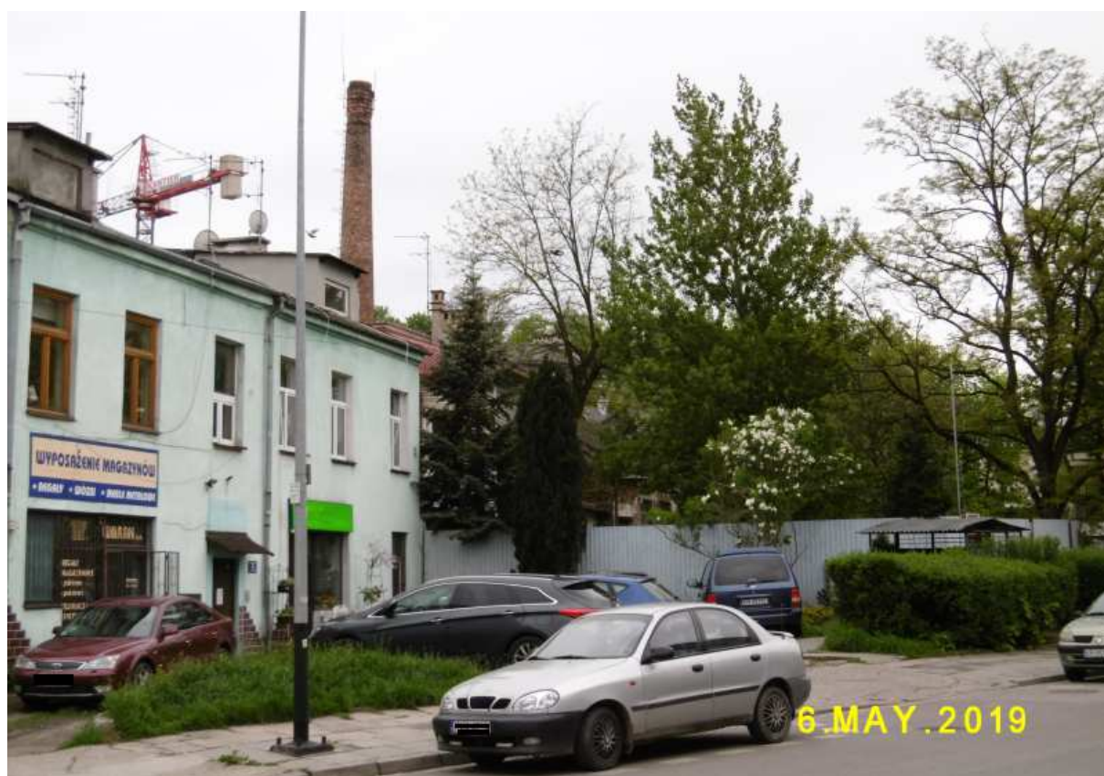
Fot. nr 383 (383-386). Fragment zabudowy ulicy Dąbrowskiego pod nr 5-9, zlokalizowanej na tyłach dawnej fabryki Kryształ.
