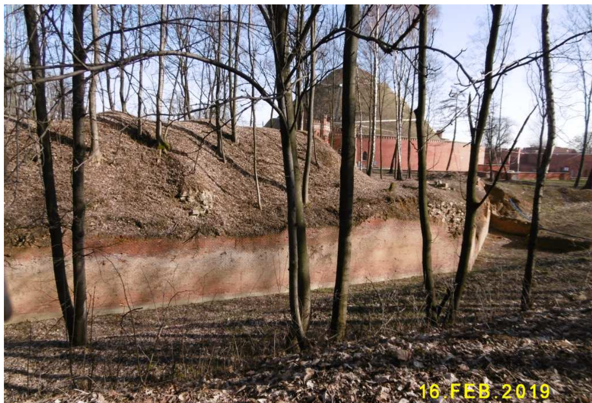
Fot. nr 265. Ściana boczna bastionu nr II.
