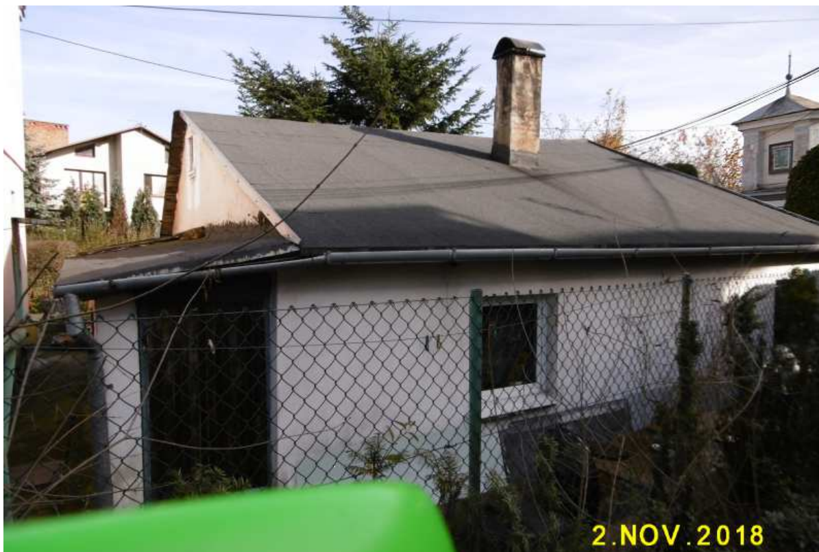
Fot. nr 274 (274-282). Oryginalna kiedyś chałupa z naroża ulic Lajkonika i Królowej Jadwigi 168b, dziś obudowana sidingiem i przylegająca do niej kapliczka słupowa.
