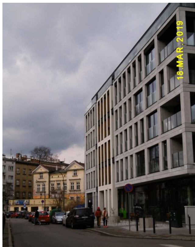
Fot. nr 221. Nowa zabudowa fragmentu ulicy Dolnych Młynów pod nr 11.
