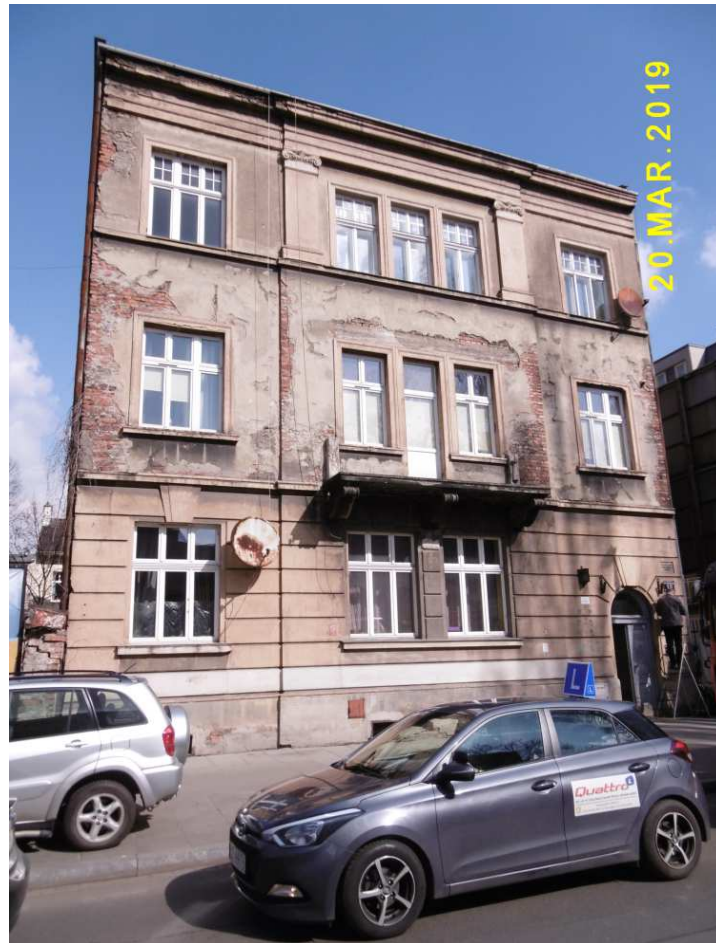
Fot. nr 226. Modernistyczna kamienica pod nr 15.
