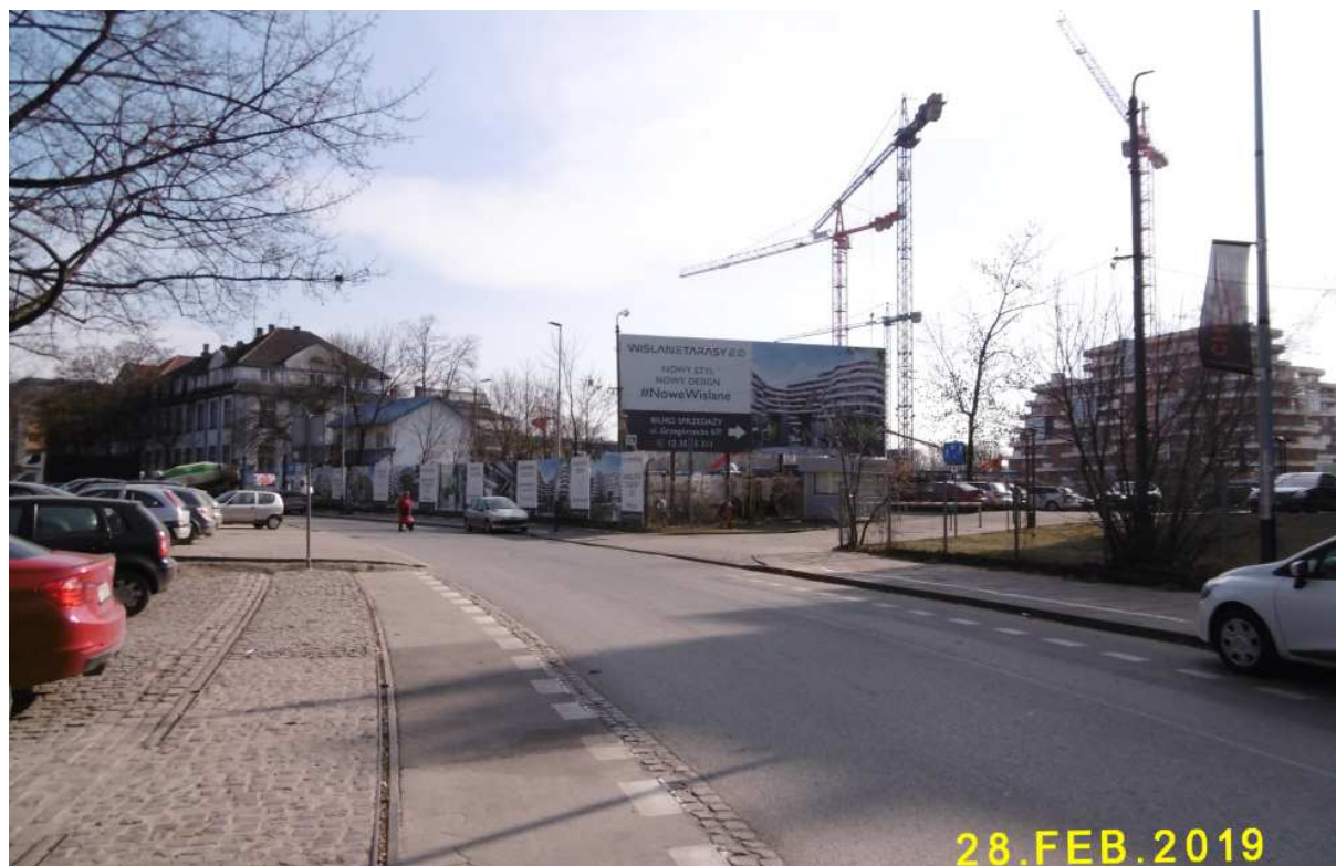
Fot. nr 157. Wzdłuż ulicy Grzegórzeckiej. W tle plac budowy na terenie dawnej fabryki maszyn Zieleniewskiego.
