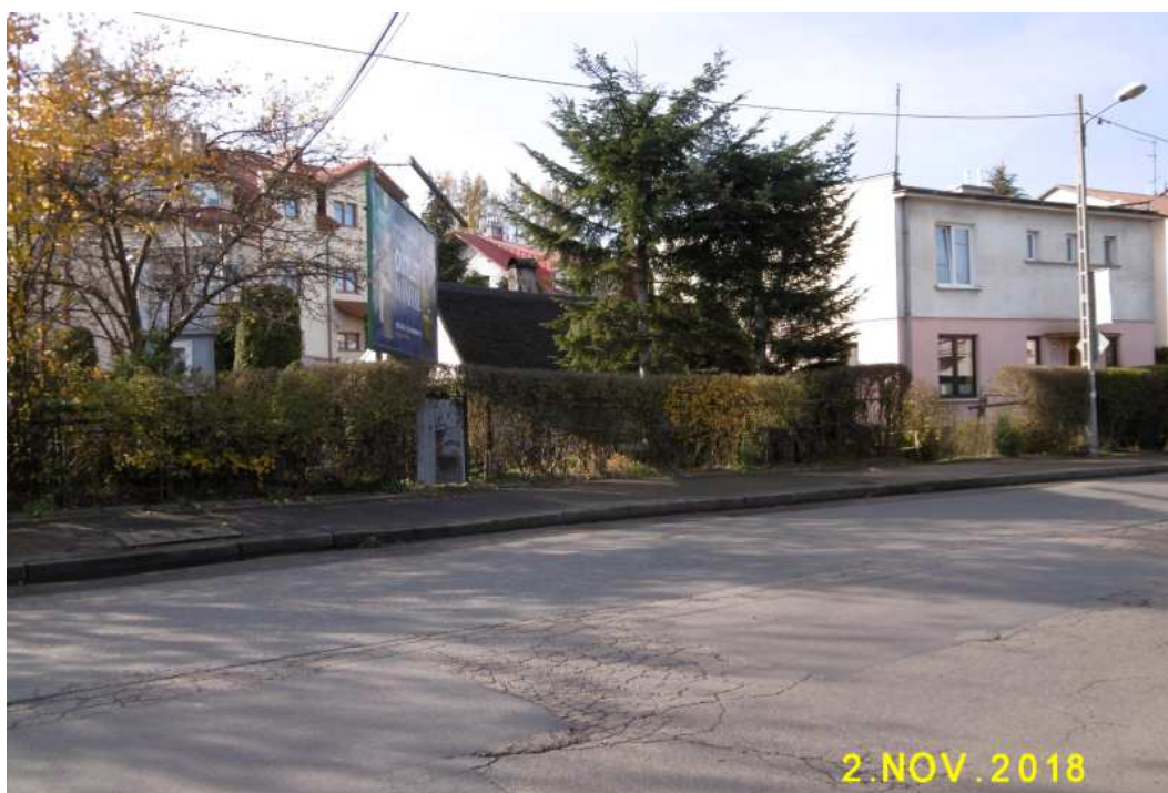
Fot. nr 279 (279-282). Widoki dawnej zagrody od strony ulicy Królowej Jadwigi.
