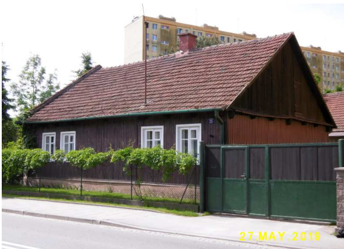
Fot. nr 67 (67-68). Bliska oryginałowi fasada.
