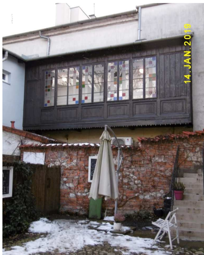
Fot. nr 214(214-216). Podwieszane ganki na dziedzińcu domów o nr: 1 i 3 i Krupniczej 21.
