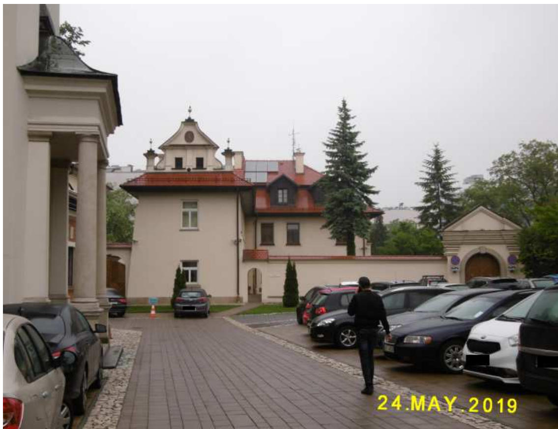
Fot. nr 26. Plebania kościoła św. Floriana – widok z ulicy Kurniki.
