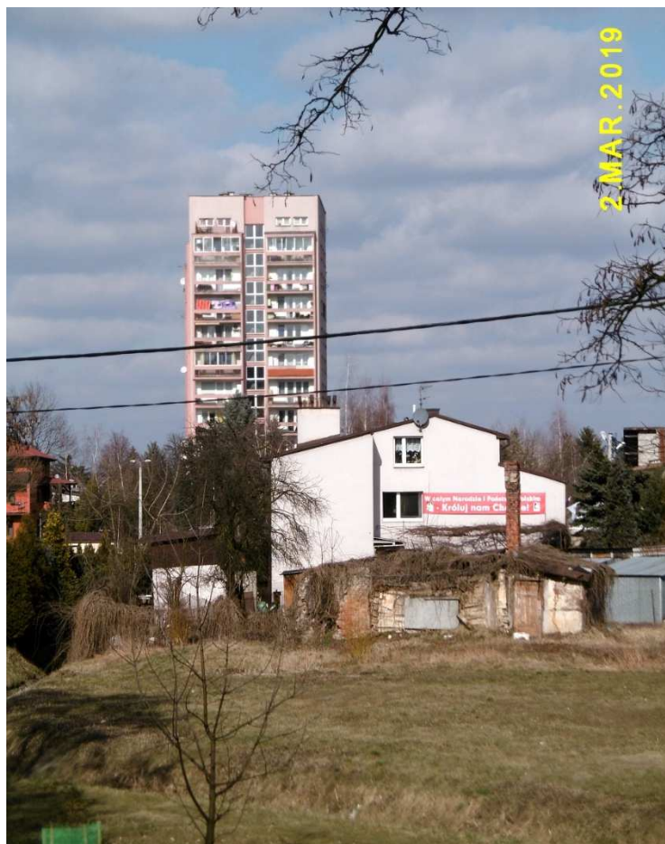
Fot. nr 444 (444-445). Ruina starej chałupy przy nieistniejącej już ulicy Jesiennej 5.
