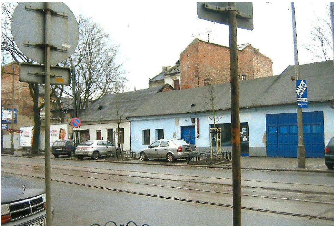
Fot. nr 254. Przełom lat 2009-2010. Fragment nieistniejącej już zabudowy ulicy Kościuszki o numerach: 24-28. Fot. St. Markowska.
