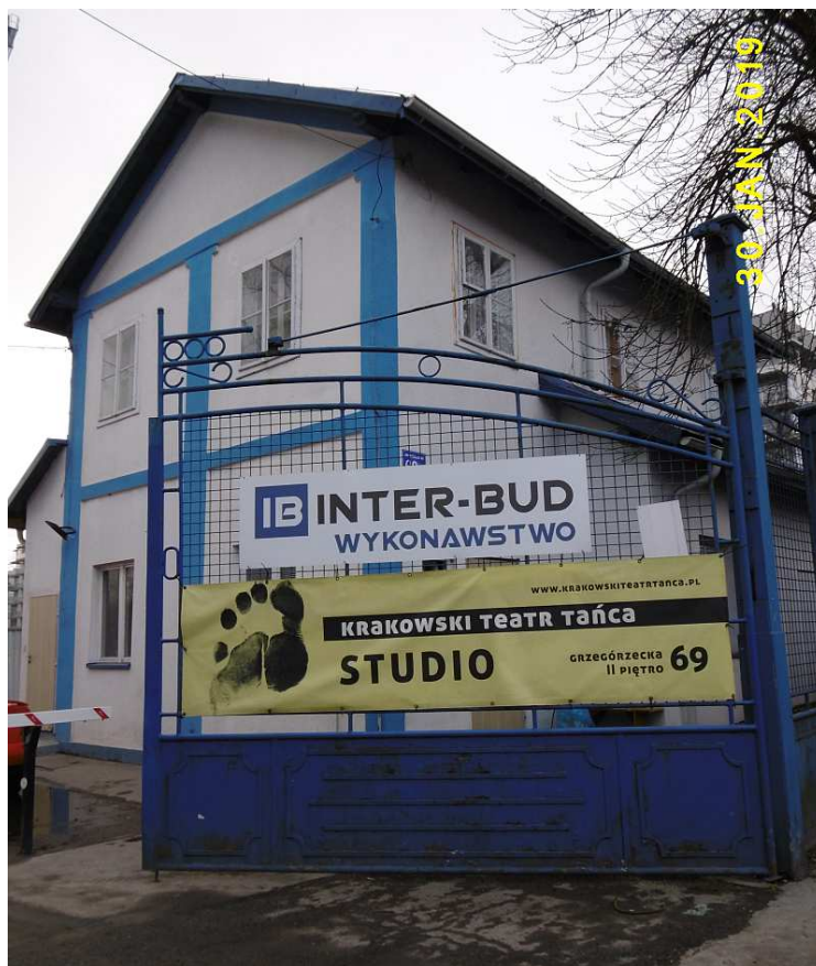
Fot. nr 160. Dawna wartownia.
