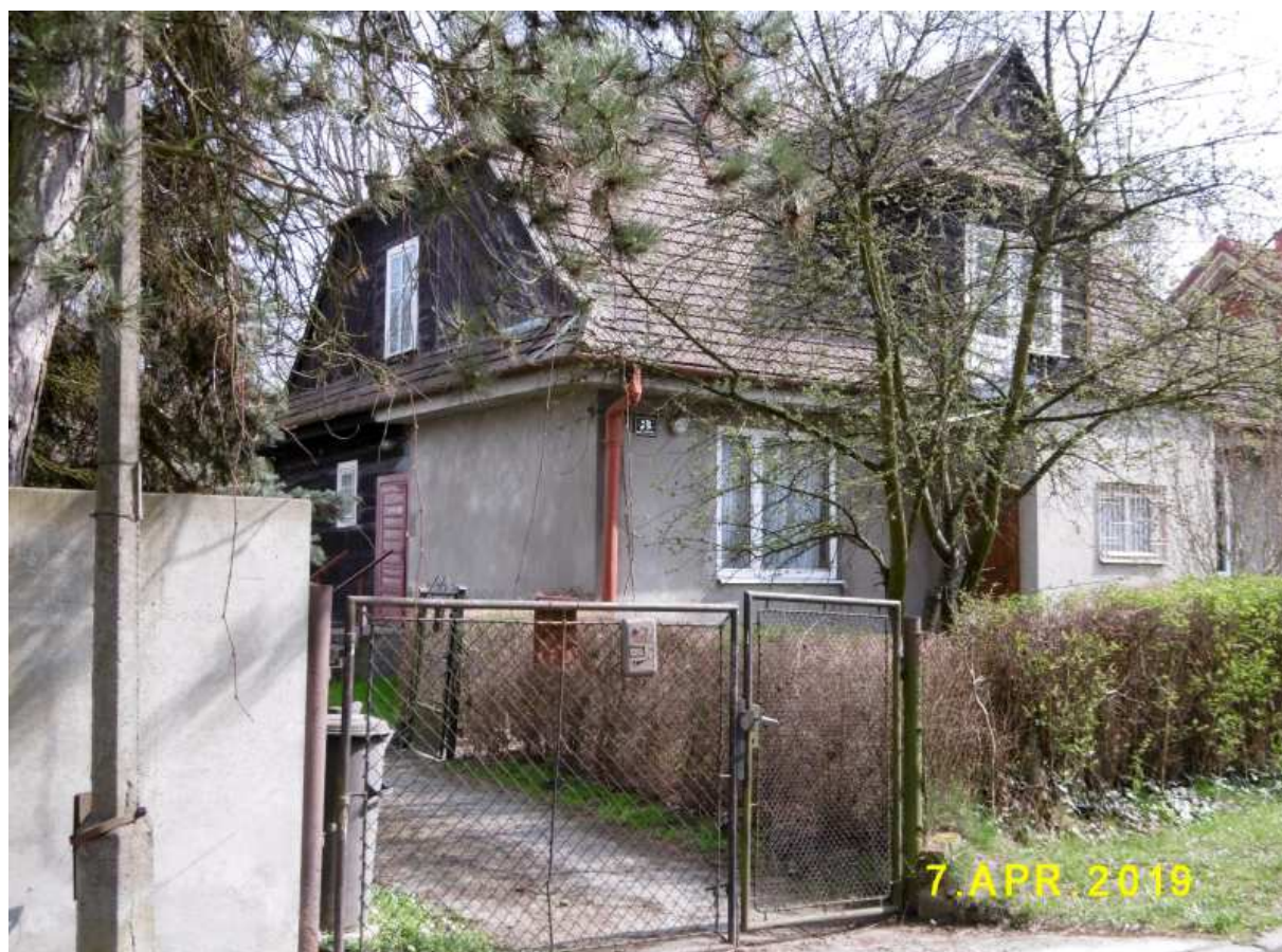
Fot. nr 315. Widok od strony ulicy, gdzie zostały dokonane późniejsze zniekształcenia.
