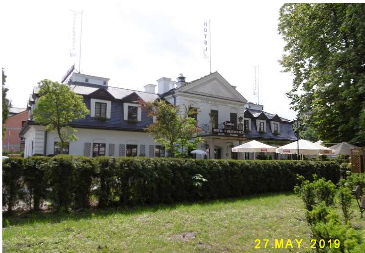
Fot. nr 100 (100-102). Hotel Dwór Kościuszko przy ulicy Papierniczej 3 w swym klasycystycznym kształcie
