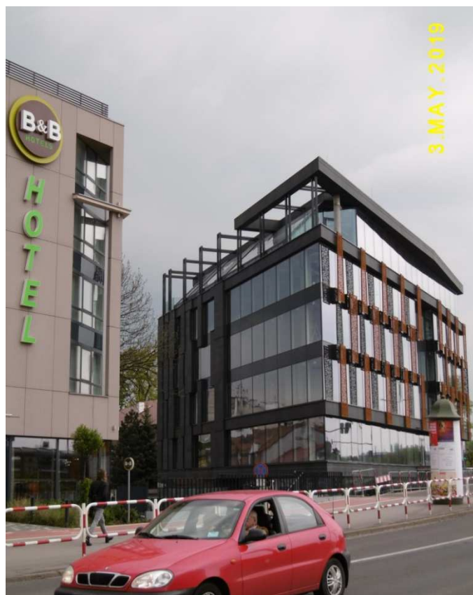
Fot. nr 331. Szklany dom na styku z rondem Grunwaldzkim.
