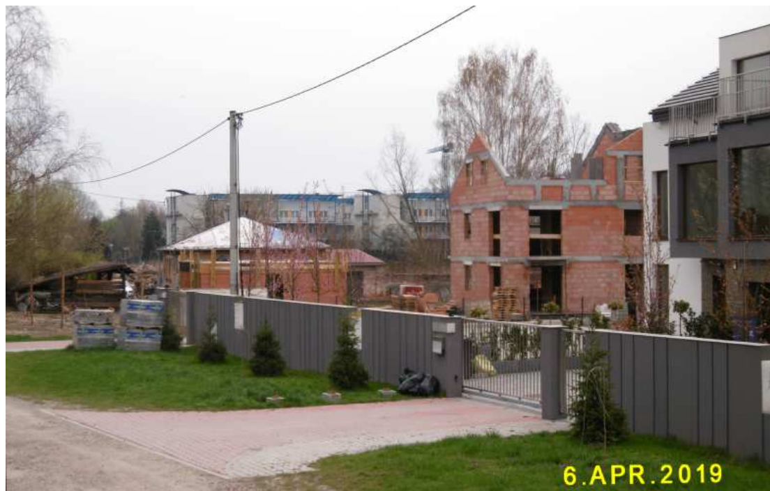
Fot. nr 283. Trwa zabudowa przybrzeżnych terenów Rudawy na odcinku od ulicy Korbutowej do Korzeniowskiego. Tu nowa zabudowa w miejscu domu przy ul. Emaus 53.
