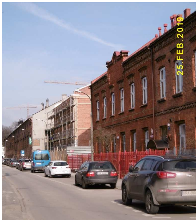
Fot. nr 154. Na pierwszym planie budynek szkolny pod nr 15, a dalej zabudowania fabryczne.
