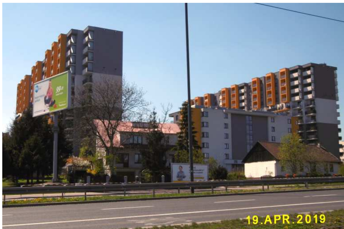
Fot. nr 431. Widok od strony pętli.
