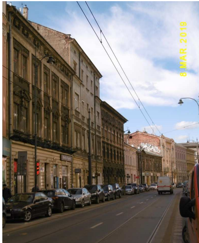
Fot. nr 10 (10-11). Kolejne fragmenty zabudowy ul. Długiej, tu powyżej kamienicy nr 46.
