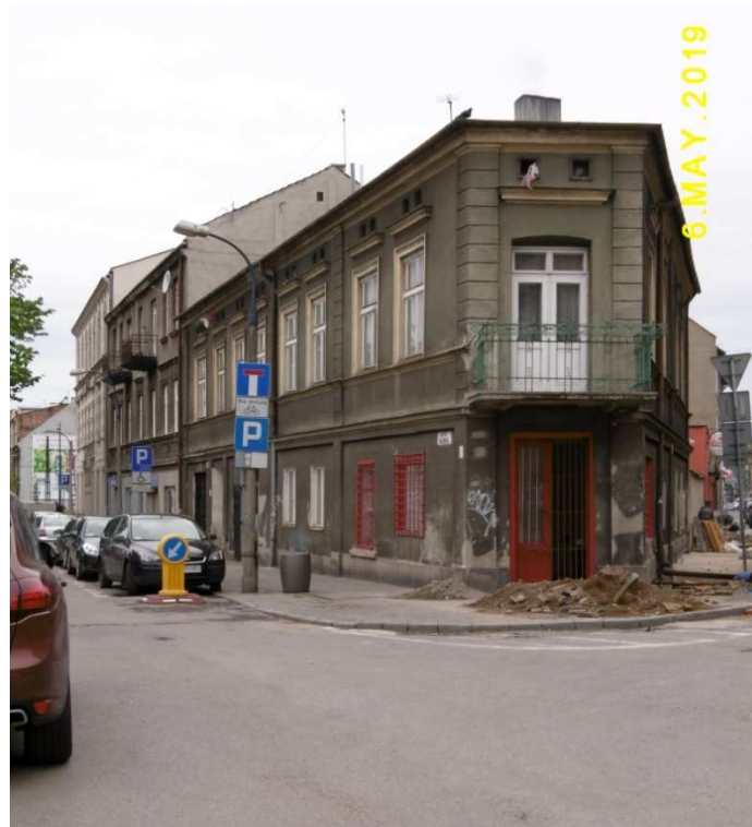
Fot. nr 390. Zabudowa ulicy Józefińskiej o numerach: 43-47 z zabudową z ostatniej ćwierci XIX wieku – widok z ulicy Lwowskiej.
