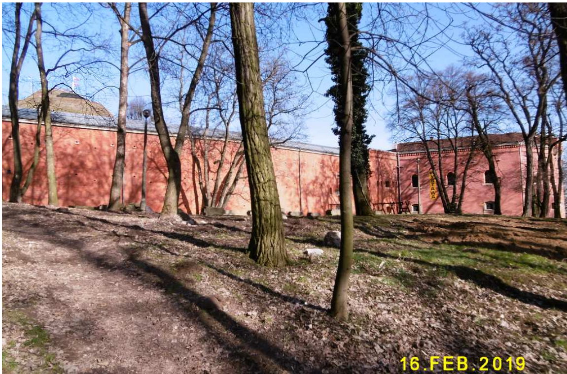
Fot. nr 260 (260-262). Wokół fortu Kościuszko. Tu Bastion nr V i kurtyna I-V.
