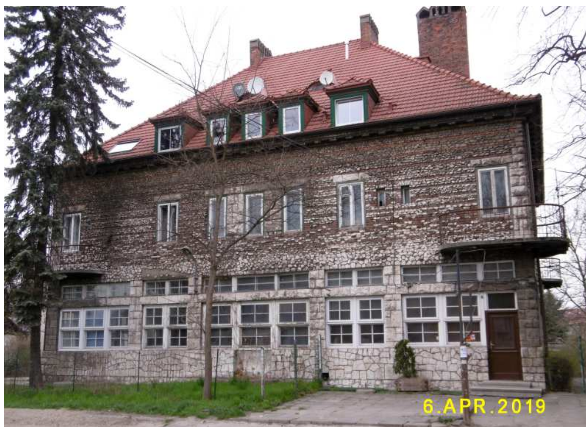
Fot. nr 307. Willa z ogrodem z ulicy Królowej Jadwigi 195, wybudowana w latach 30. zeszłego wieku wg projektu Adolfa Szyszko-Bohusza.
