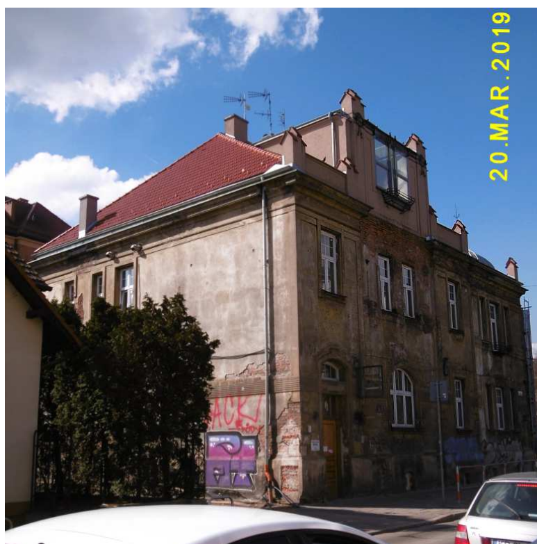
Fot. nr 223. Ciągłe zaniedbana secesyjna willa z ulicy Czarnowiejskiej 8.
