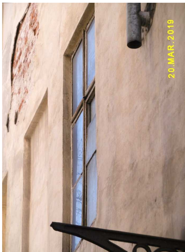
Fot. nr 230. Ponad stuletnie okno, które zachowało się w oryginale.
