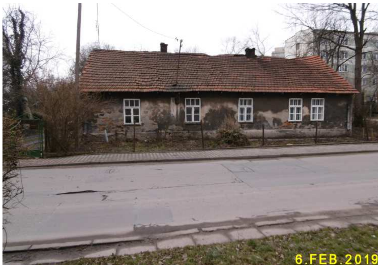
Fot. nr 187. Wielorodzinny dom murowany, który zachował się w oryginalnym stanie.
