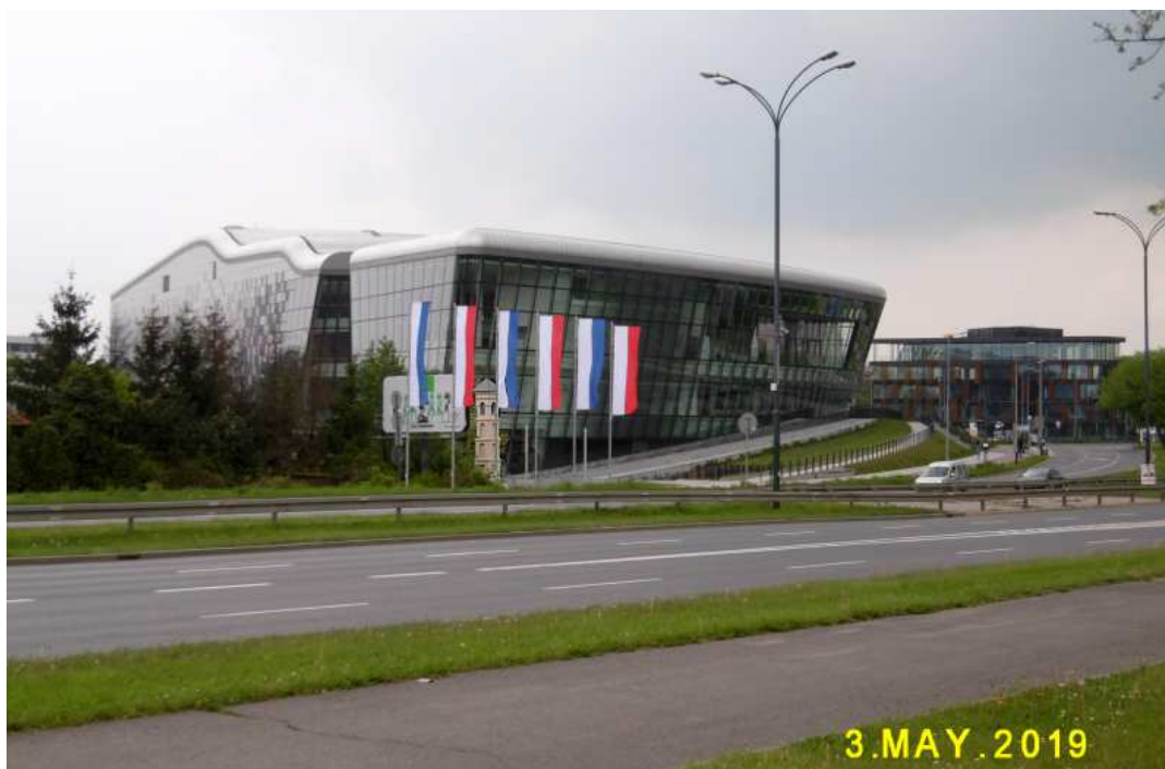
Fot. nr 320. Nowa „brama dębnicka”: Centrum Kongresowe i nowy „szklany dom” u wylotu ulicy Kilińskiego.
