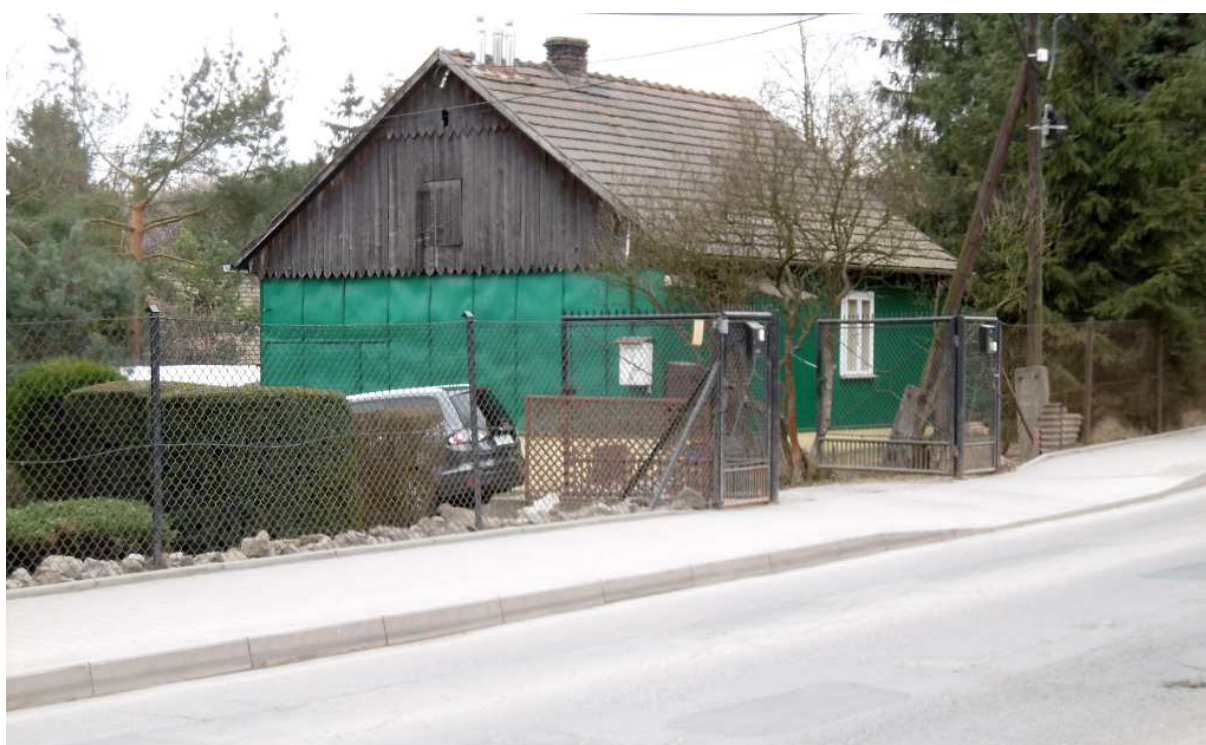
Fot. nr 485 (485-489). Dawna zabudowa ulicy Kosocickiej. Tu dom pod nr 51. (03.03.2019)
