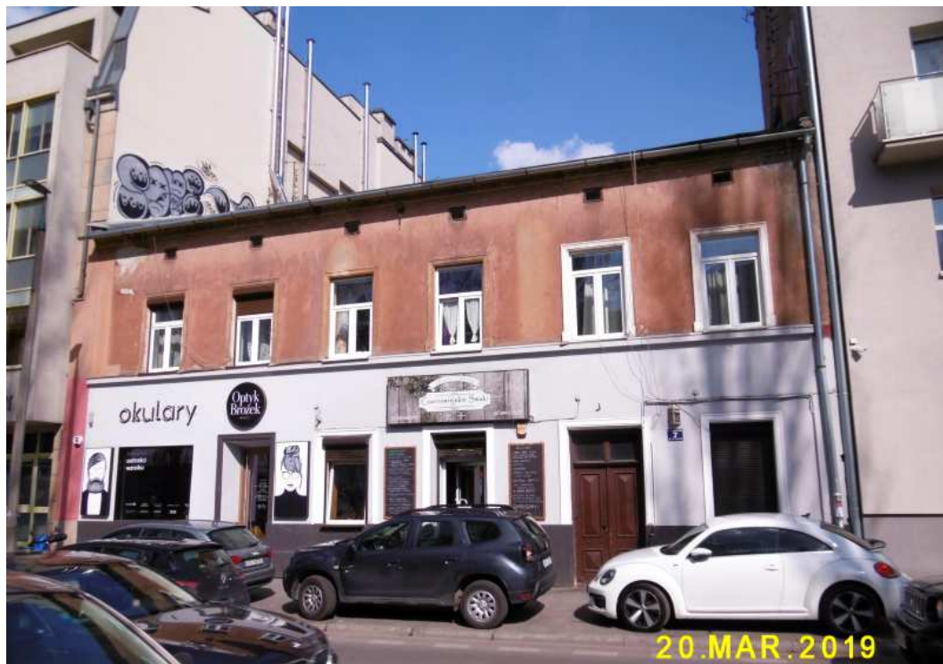
Fot. nr 227. Kolejny przykład niskiej zabudowy ulicy Czarnowiejskiej - dom pod nr 7.
