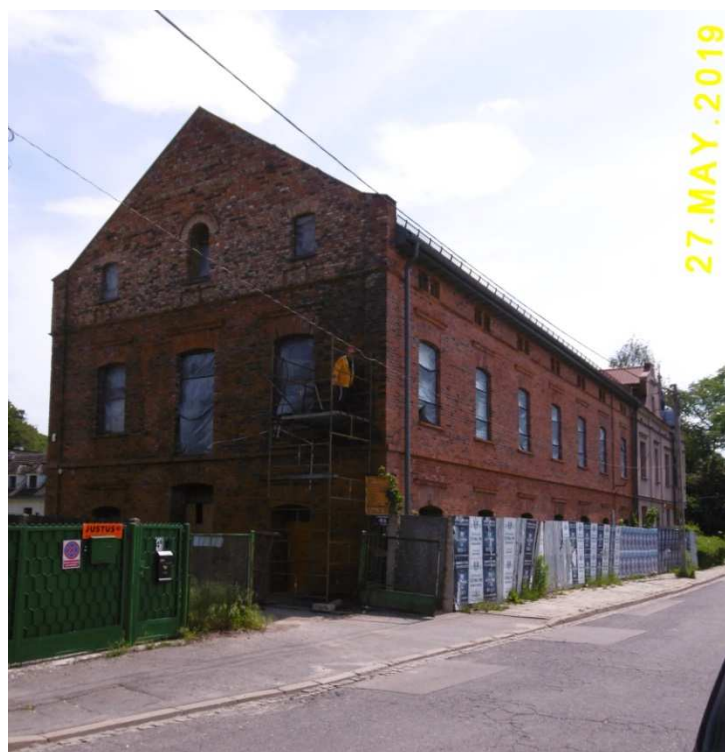
Fot. nr 87 (87-90). Budynek dawnego młyna przy ulicy Białoprądnickiej 4a na etapie remontu i adaptacji na cele gastronomiczno-rozrywkowe.
