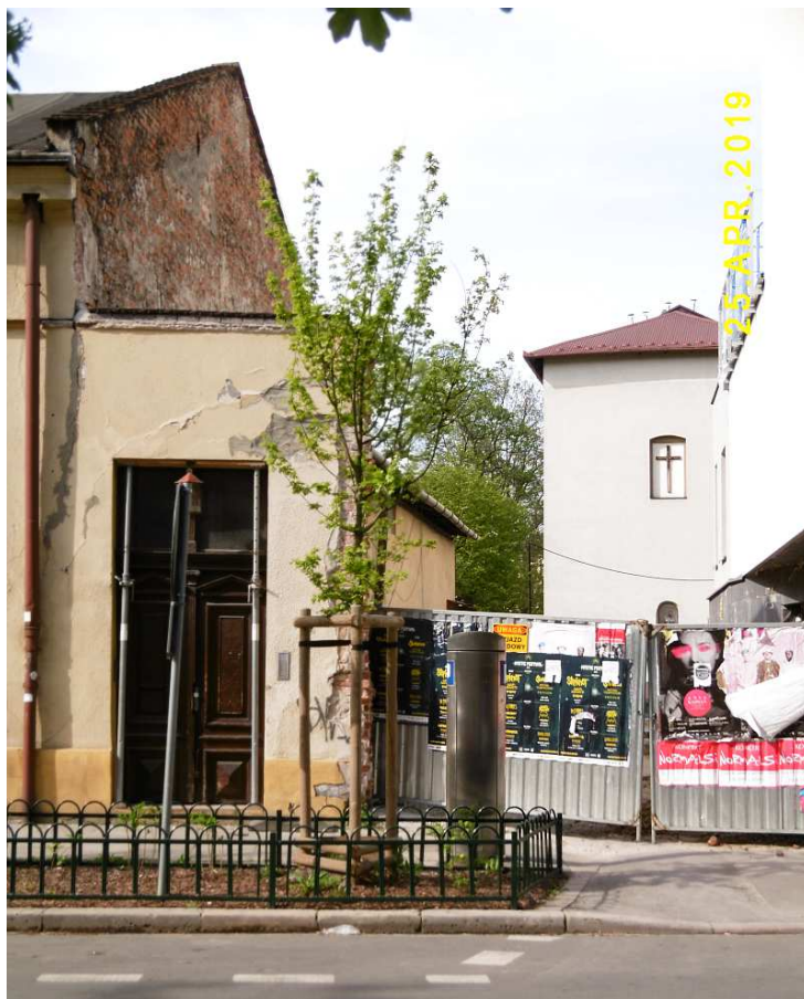
Fot. nr 246. Widoki na dziedziniec z kaplicą w tle.
