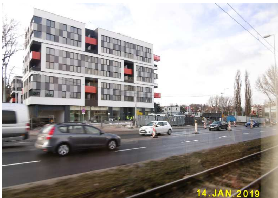
Fot. nr 402 (402-405). Wspomnienie po wyburzonej, niskiej zabudowie ulicy Wielickiej o numerach: 105-111.
