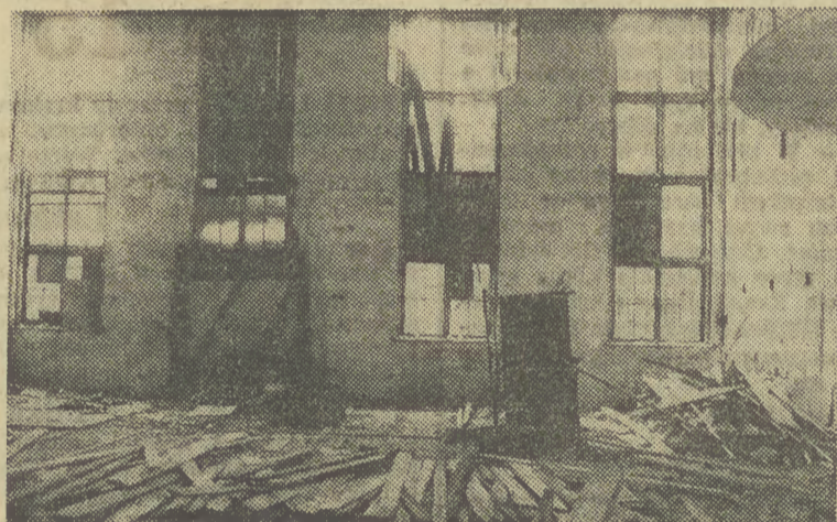
W pomieszczeniach „Makabi” trwa remont.
