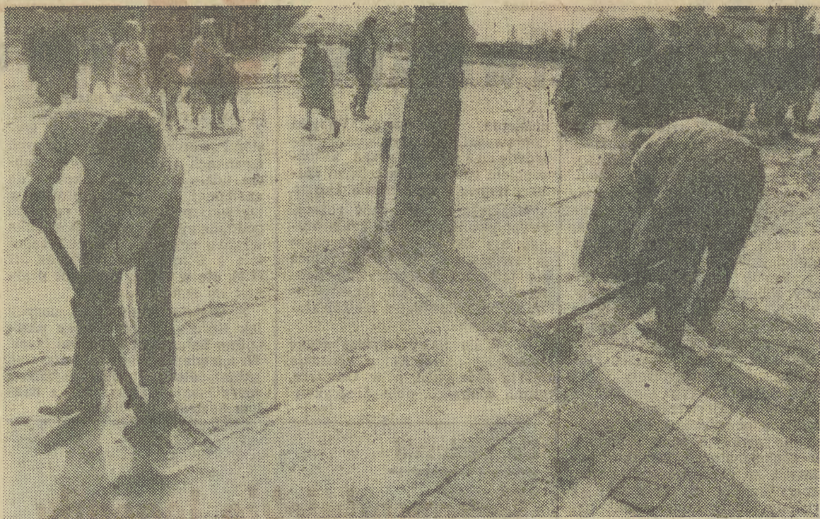
Pracownicy Dzielnicowego Zarządu Dróg w Nowej Hucie łatają na placu Centralnym dziurę w asfalcie powstałą w wyniku prac ziemnych. Jeśli zdażą przed jesennymi deszczami nie będziemy tonąć w błocie. Fot. STANISŁAW MAKAREWICZ
