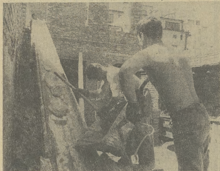
JESZCZE trochę zaprawy wapienno-cementowej, kilkaset cegieł i STANISŁAWA BASTĘ oraz JANA KURZEJE zastąpią ciele, którzy na oficynie przy ul. Grodzkiej 5 postawią najprawdopodobniej drewnianą więźbę dachową. Wszystko w dobrym, starym stylu. Fot. St. Makarewicz
