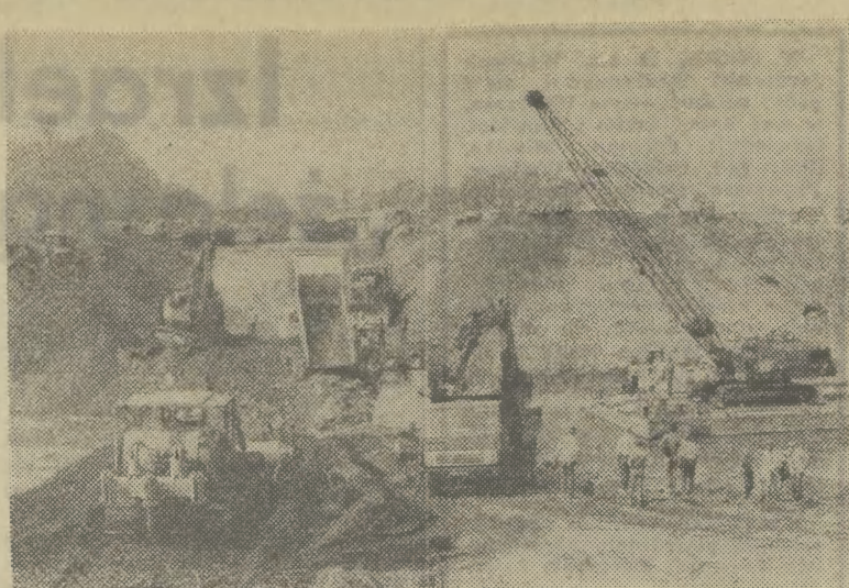
20 CIEŻARÓWEK, 6 spychaczy, 3 koparki w ciągu kilku godzin wyspały do Wisły 3 tys. ton kamieni oraz 10 tys. m sześć. ziemi. Fot. Stanisław Makarewicz
