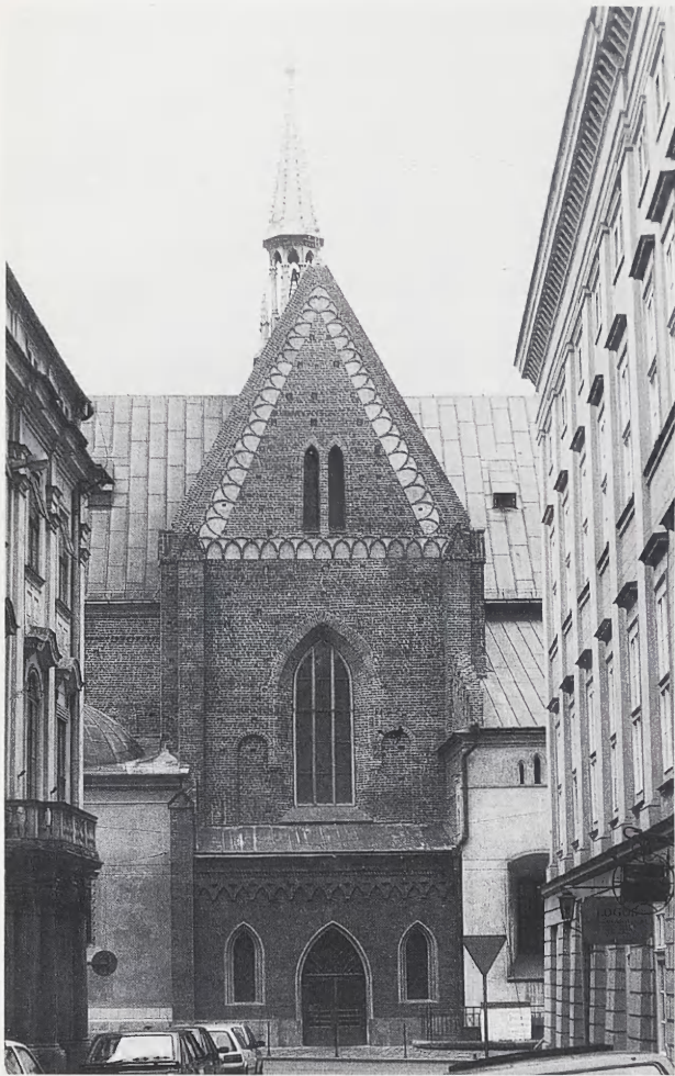
1. Elewacja szczytowej ściany północnego ramienia transeptu kościoła franciszkanów w Krakowie. Fot. Jerzy Sieczkowski
