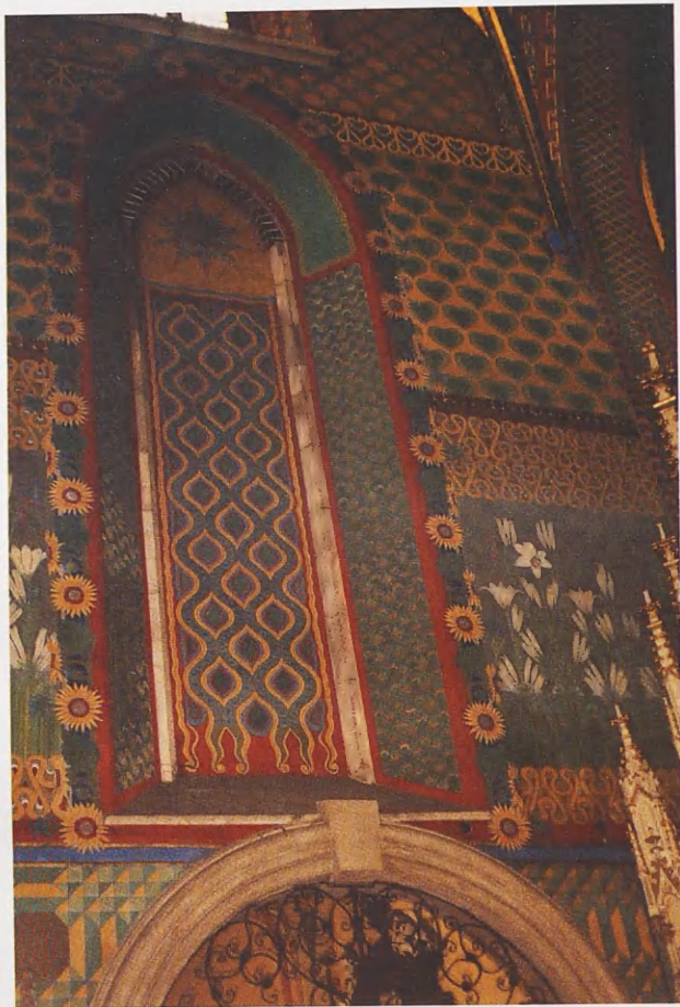
4. Zaślepione okno we wschodniej ścianie północnego ramienia transeptu kościoła franciszkanów w Krakowie. Fot. Stanisław Pasiciel
