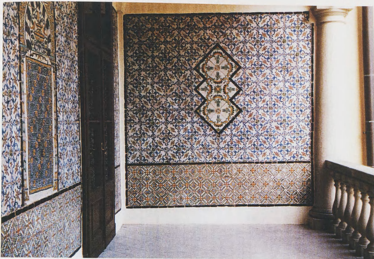
2. Dekoracja ceramiczna loggii pierwszego piętra: narożnik ścian frontowej i bocznej północnej
