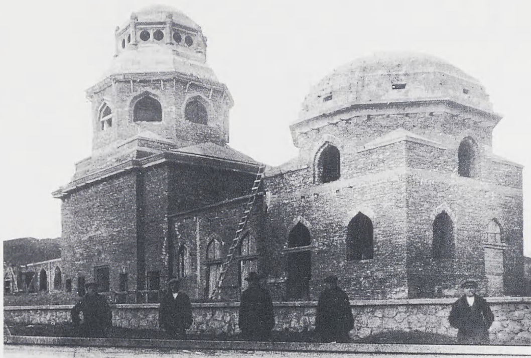
5. Budowa hali przedpogrzebowej, stan z 15 listopada 1927 r., fot. ze zbiorów Żydowskiego Instytutu Historycznego (dalej cyt. ŻIH), sygn. III-2522
