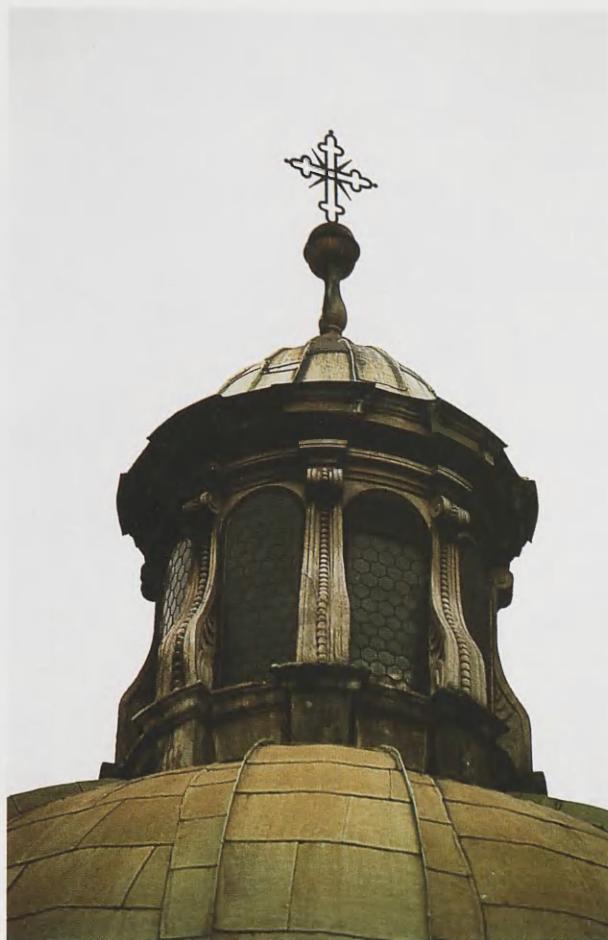
8. Latarnia kaplicy Zwiastowania NMP, fot. J. Walczewski
