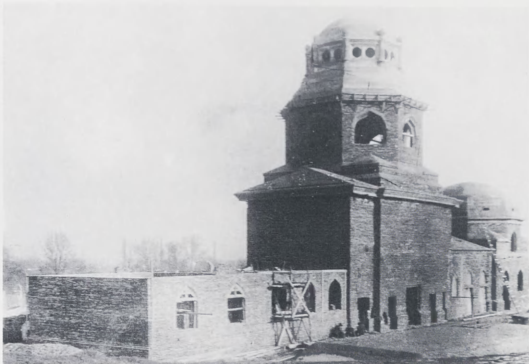
6. Budowa hali przedpogrzebowej, stan z 15 listopada 1927 r., fot. ze zbiorów ŻIH, brak sygn.
