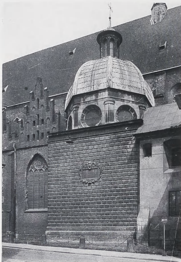
4. Kościół dominikanów. Kaplica Myszkowskich (1603—1614), widok od południowego wschodu, fot. W. Gumuła
