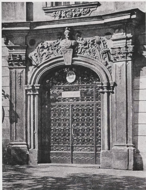
13. Kamienica Margrabska. Portal w fasadzie, fotografia w publikacji M. Kretschmerowej, Portale domów krakowskich XVII i XVIII wieku , Kraków 1957, il. 39
