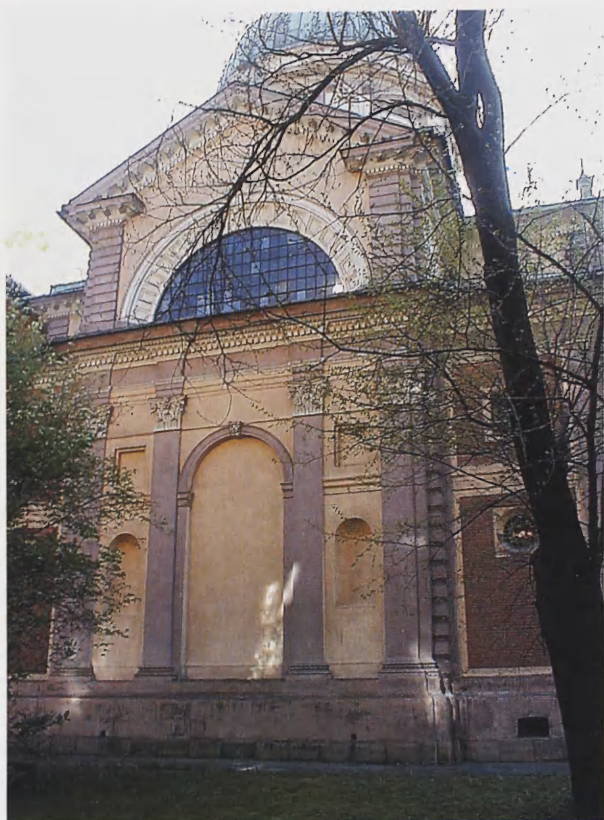
4. Zakład Helclów. Kaplica. Widok elewacji bocznej. Fot. J. Gawrylczyk-Malesa
