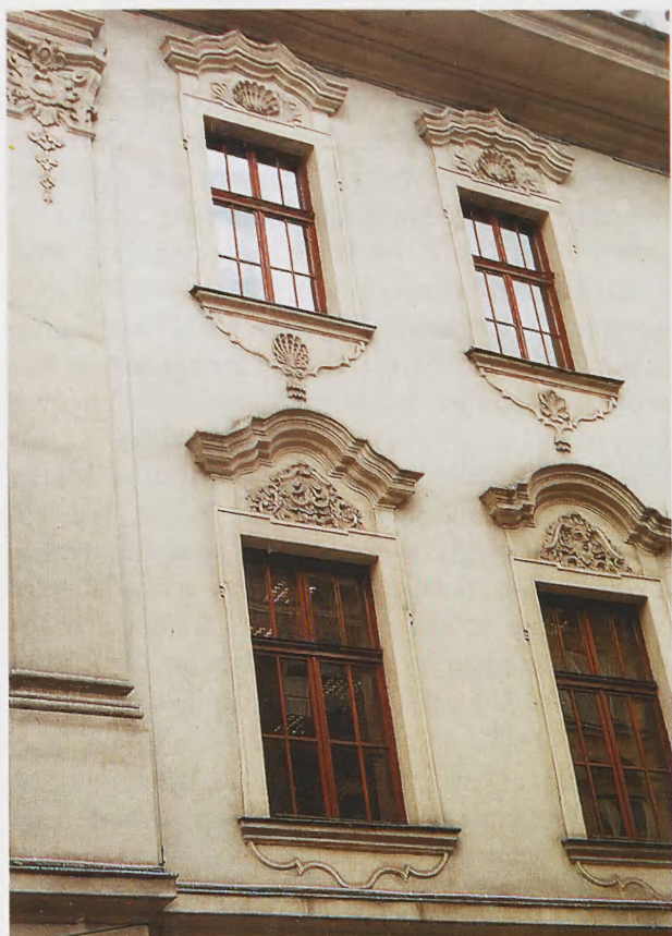
12. Kamienica Margrabska. Dekoracja obramień okiennych w elewacji od ul. Floriańskiej, stan obecny
