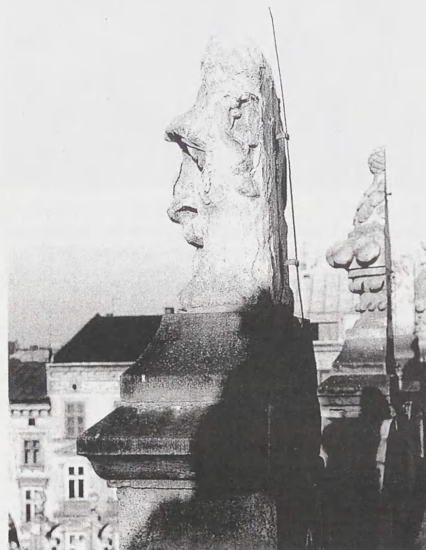
12. Maszkaron „z wąsami”. Widok boczny. Stan z roku 1972. Widoczne ubytki, pęknięcia i złuszczone kity. Fot. J. Doraczek, Archiwum PKZ, neg. 8305/A
