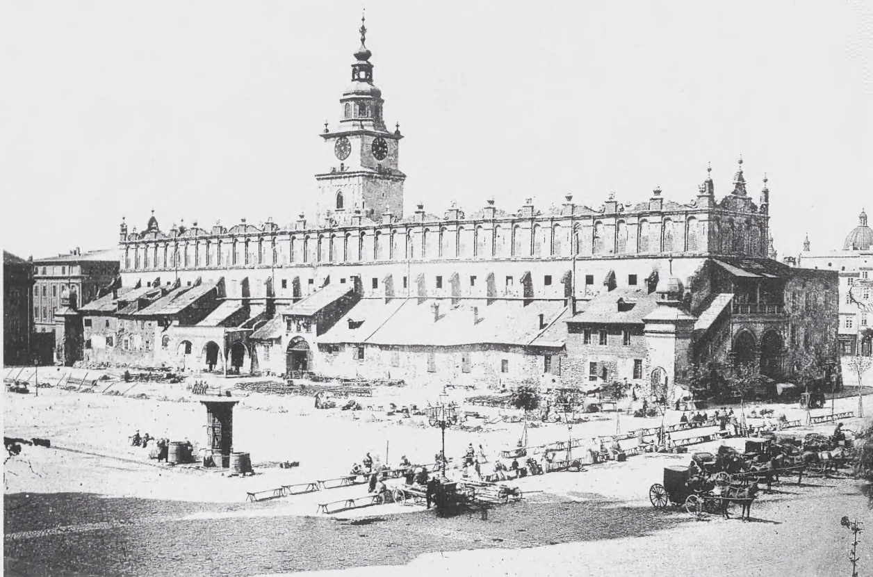
5. Widok całości elewacji wschodniej budynku Sukiennic z północnego wschodu. Stan około roku 1875. Fot. I. Krieger, MHMK, inw. 3610/K, PIK neg. 6932
