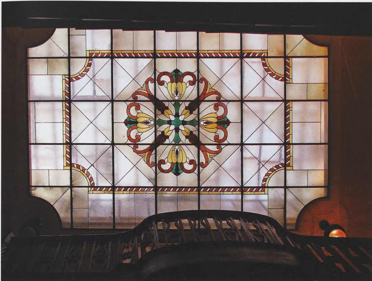
9. Światlik nad główną klatką schodową „Szarej Kamienicy” przy Rynku Głównym 6, wmontowany w czasie remontu w latach 1909–1912, prowadzonego przez L. Wojtyczkę (fot. A. Laskowski, 2007)
