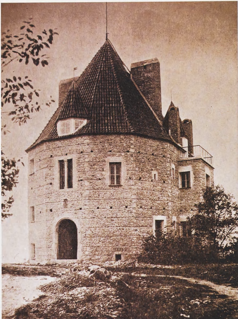
14. Willa własna Adolfa Szyszko-Bohusza w Przegorzalach – widok od frontu, stan tuż po wybudowaniu (wg: „Architekt”, 22: 1929, s. 26)
