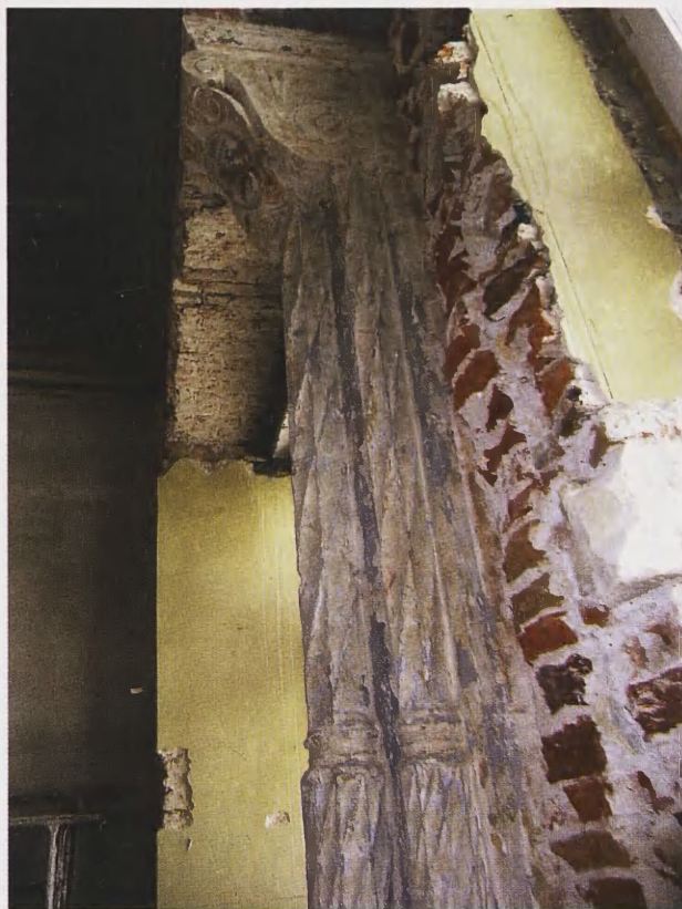
9. Filar międzyokienny w sali pierwszego piętra domu Bonerowskiego, stan po odsłonięciu, 2006 (fot. Ł. Holcer)
