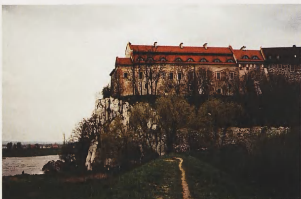
4. Skałka pod klasztorem w Tyńcu, u podnóża na brzegu Wisły – gładz wapienny, efekt trzęsienia ziemi w Krakowie (fot. Zofia Alexandrowicz)
