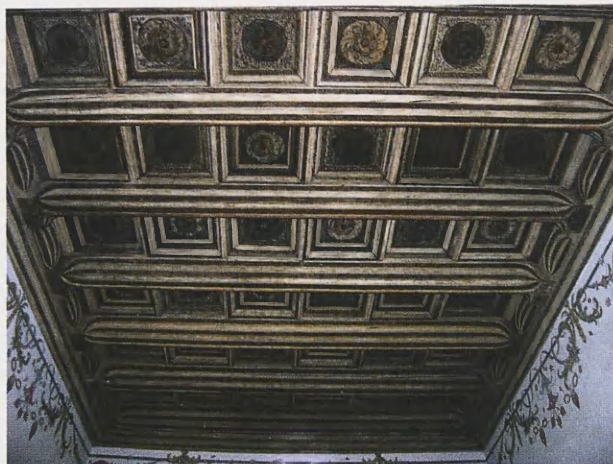
8. Strop sali pierwszego piętra domu Bonerowskiego, stan po konserwacji (fot. Łukasz Holcer)
