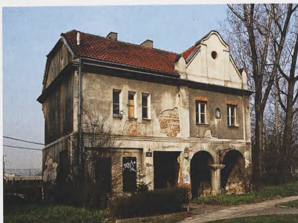
25. Dawna rogatka przy ul. Prądnickiej 34; stan z 2009 (fot. P. Dettloff)
