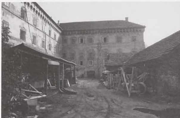
13. Gmachy św. Michała podczas remontu. Widok z ogrodu, od strony Plant. Lata 1954–1967. Fot. ze zbiorów Muzeum Archeologicznego w Krakowie
