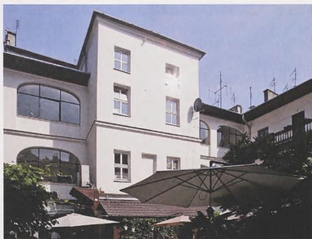
16. Widok domu większego od strony podwórca (czerwiec 2013 r.). Fot. Zdzisław Gajecki
