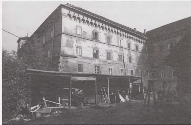
14. Gmachy św. Michała podczas remontu. Widok z ogrodu, od strony Plant. Lata 1954–1967. Fot. ze zbiorów Muzeum Archeologicznego w Krakowie
