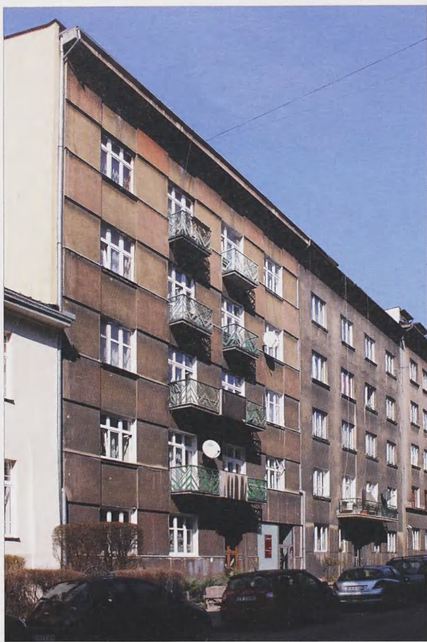
14. Kamienica przy ul. F. Chopina 5. Fot. autorka
