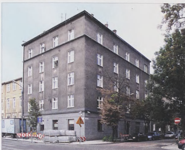
11. Kamienica przy ul. Filareckiej 2a. Fot. autorka
