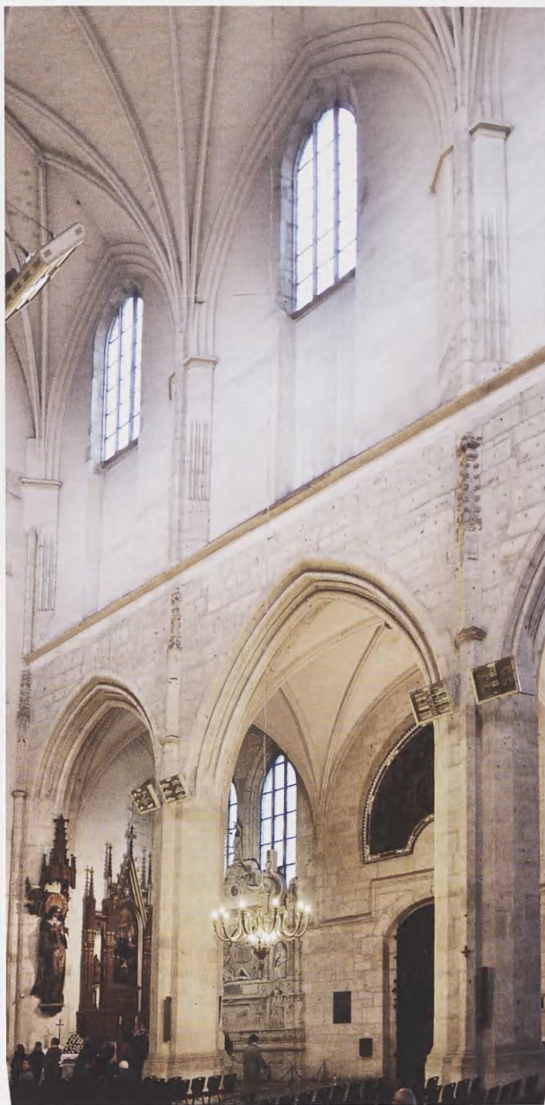
2. Kościół Św. Katarzyny, południowa elewacja nawy głównej, widok ku wschodowi. Fot. autor
