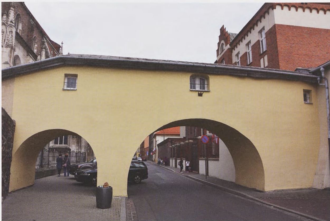
14. Łącznik między klasztorem ss. Augustianek a kaplicą węgierską (św. Moniki) przy kościele Św. Katarzyny w Krakowie, 2015. Fot. Roman Tekieli
