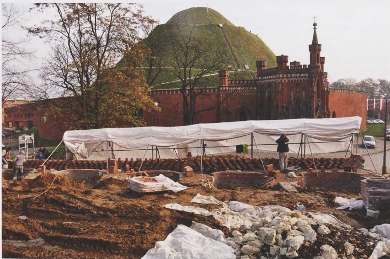
18. Twierdza Krakowska, fort nr 2 „Kościuszkowski”, prace zabezpieczające mur kurtynowy bastionów. Fot. Adam Dymek
