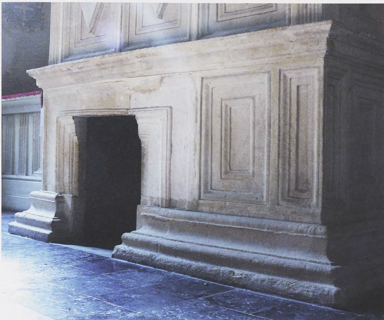
5. Dolna część elewacji frontowej „Grobu Bożego” (przerobiony portal i piedestał). Fot. P. Pencakowski
