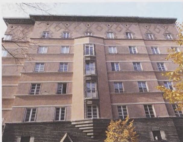
15. Dom pracowników Iwowskiego Zakładu Ubezpieczeń, pl. Inwalidów 6, stan po konserwacji. Fot. Adam Dymek
