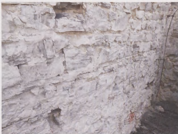
12. Kościół pw. Św. Benedykta, fragment muru wczesnośredniowiecznego kościoła. Fot. Maciej Wilamowski
