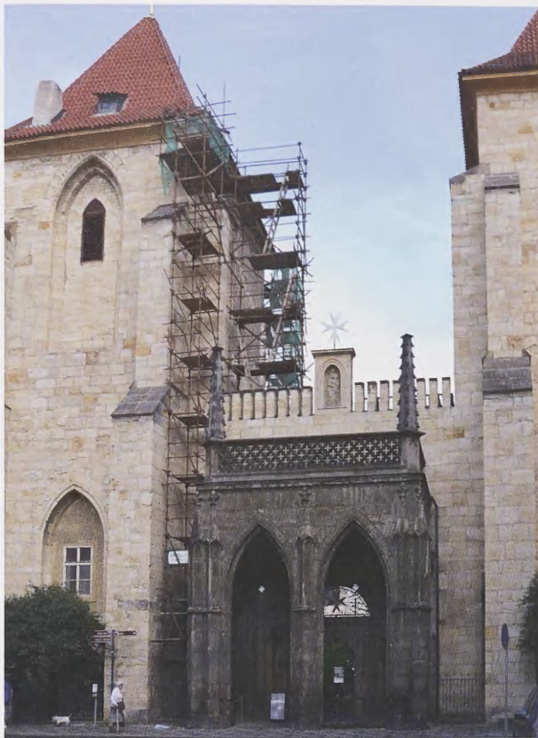
10. Praga, portyk zachodni kościoła Panny Marii pod Łańcuchem. Fot. Štefan Valášek
