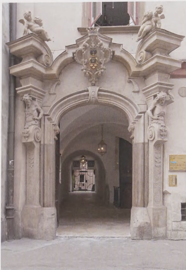
2. Kraków, portal dawnej rezydencji opatów jędrzejowskich przy ul. Św. Jana 20. Stan obecny. Fot. R. Nestorow
