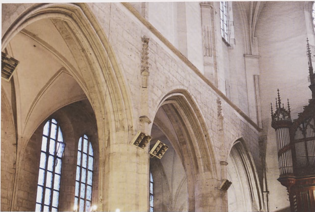
1. Kościół Św. Katarzyny, dolna kondygnacja południowej elewacji nawy głównej, widok ku zachodowi. Fot. autor
