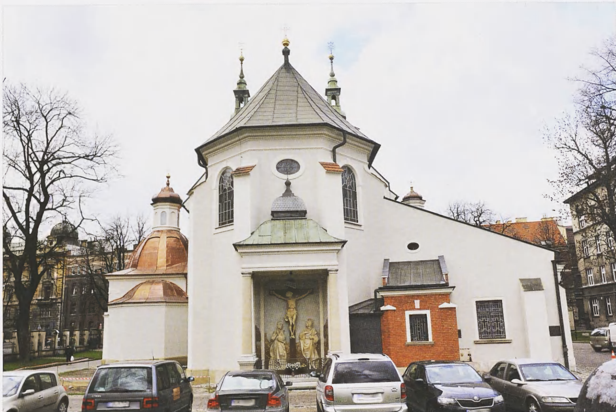
9. Kościół pw. Św. Floriana na Kleparzu, widok od wsch., stan po konserwacji. Fot. J. Śliwa, 2015
