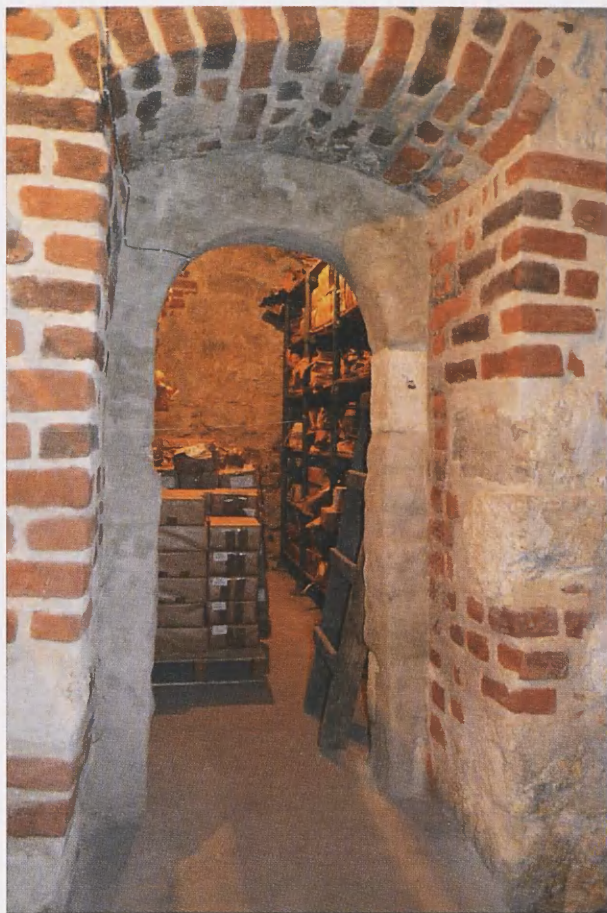
15. Wątki kamienno-ceglane w piwnicach pod oficyną kamienicy przy ul. Św. Jana 12. Stan po konserwacji 2003. Fot. A. Kałużny 2003
