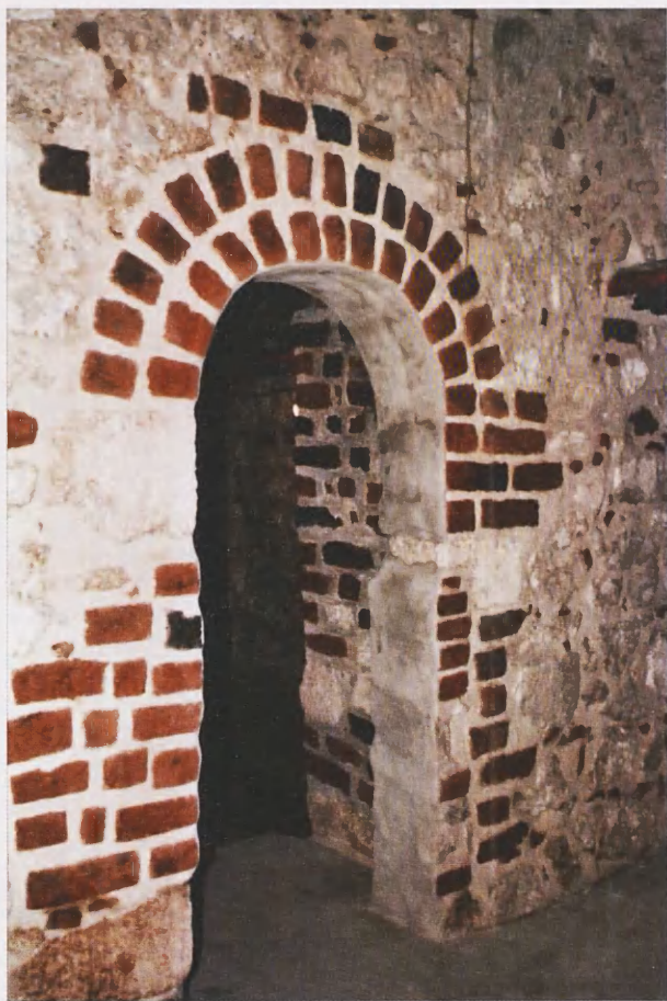
16. Komora piwniczna południowo-zachodnia pod kamienicą Św. Jana 12. Stan po konserwacji w 2003 r. i usunięciu barwnej wyprawy na sklepieniu i ścianach z 1994 r. Fot. A. Kałużny 2003
