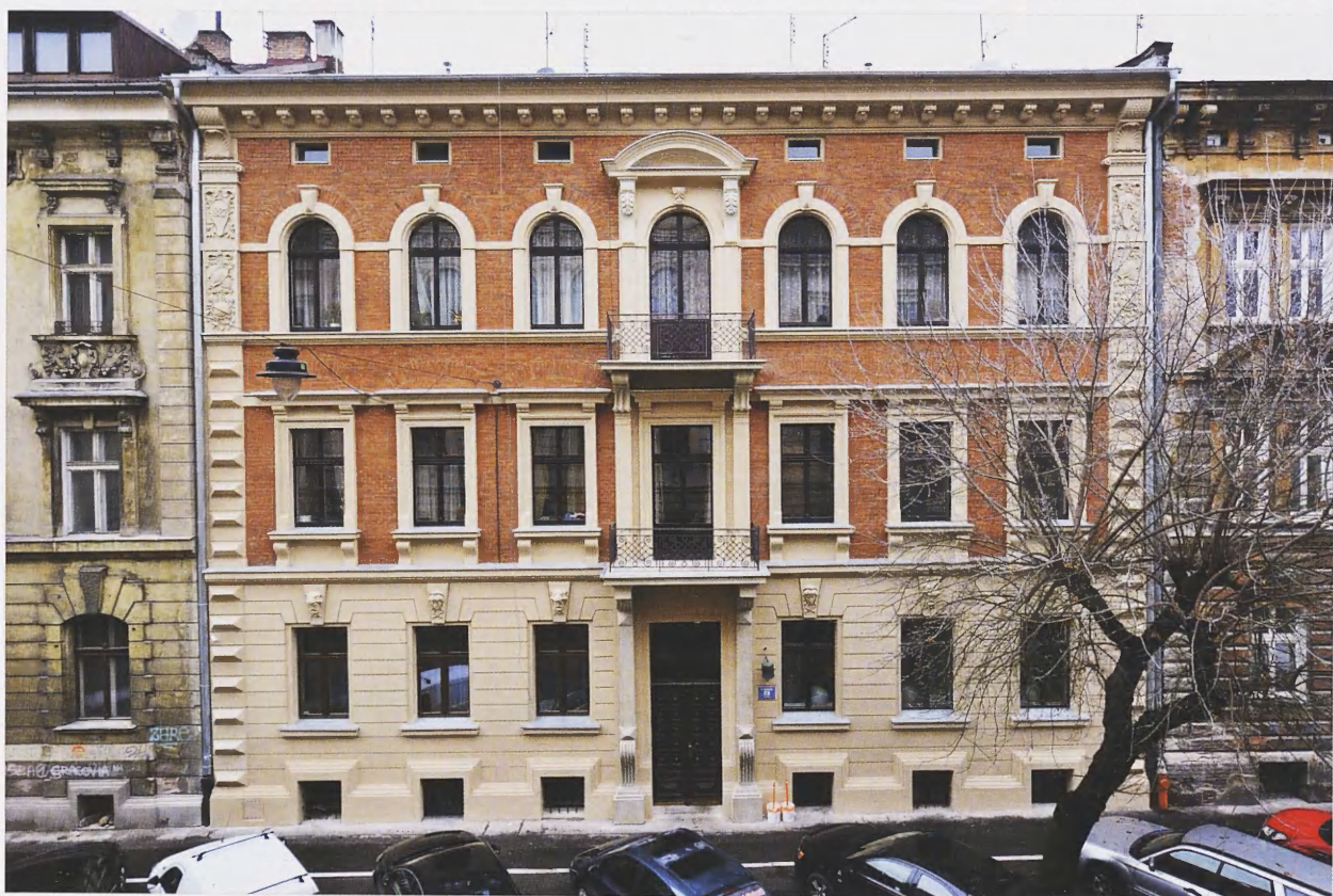
11. Kamienica, ul. Studencka 23, fasada, stan przed i po konserwacji. Fot. M. Okoń, J. Śliwa, 2015
