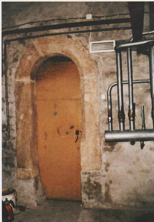
10. Portal w piwnicy pod kamienicą Św. Jana 12. Komora północno-zachodnia, stan po obniżeniu poziomu podłogi w 1991 r. Fot. M. Cempla 1991
