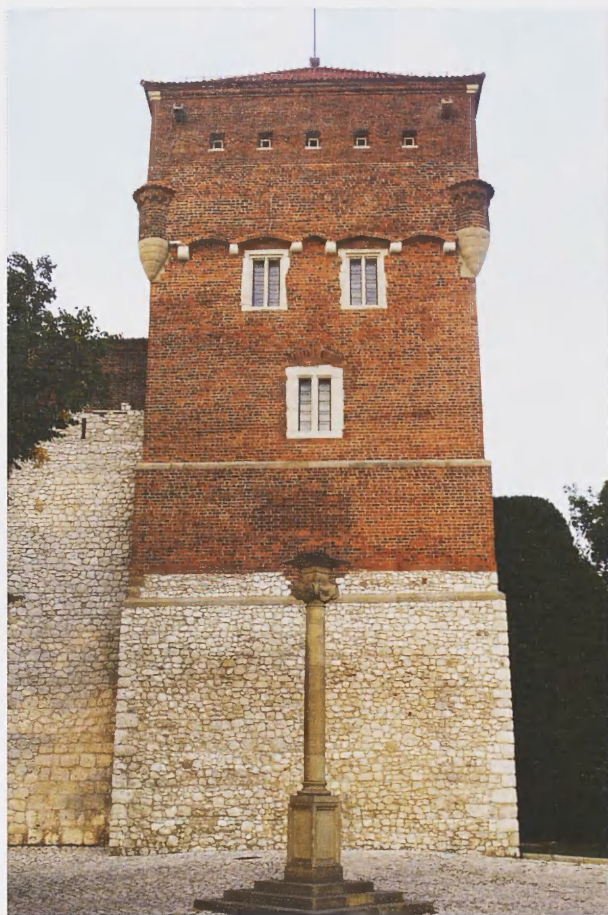
2. Baszta Złotdziejska po konserwacji. Fot. M. Sawicki
