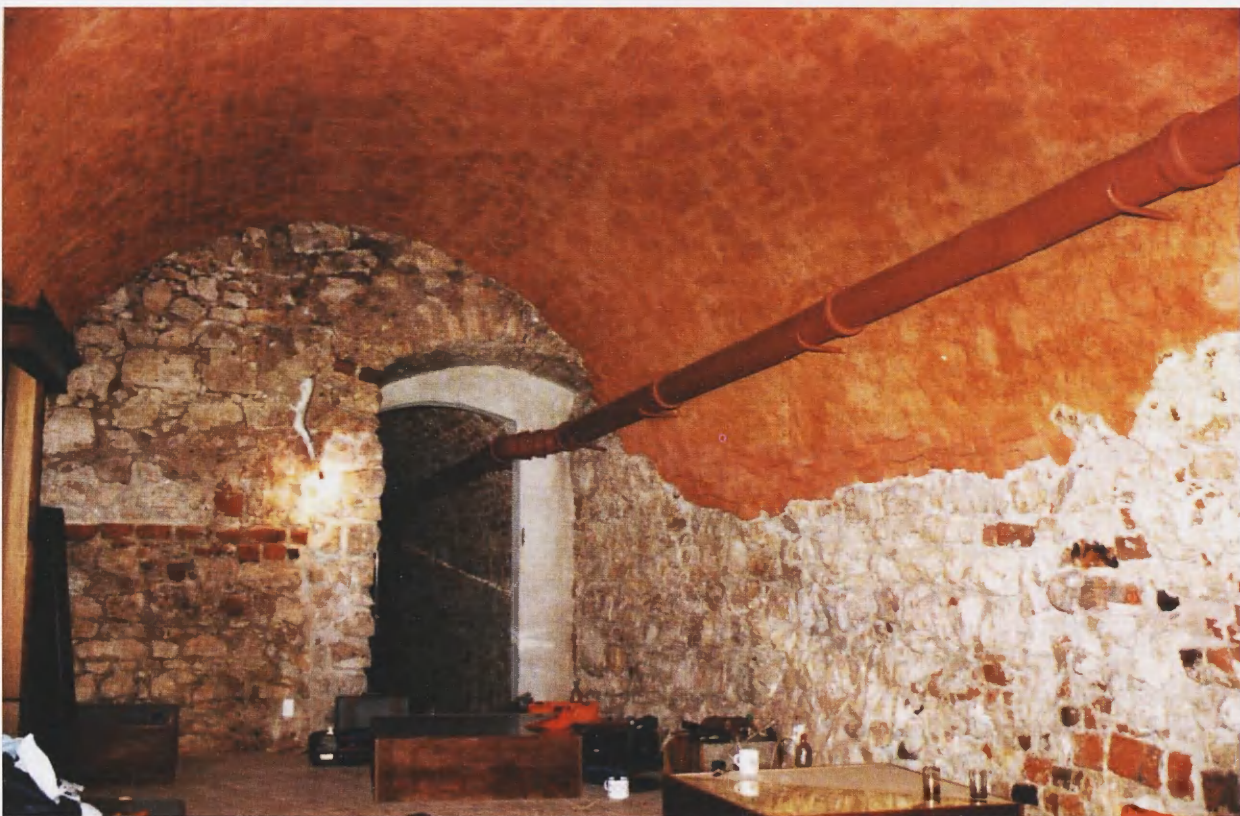
12. Komora piwniczna południowo-zachodnia pod kamienicą przy ul. Św. Jana 12. Stan po konserwacji dla firmy Pierre Cardin i wprowadzeniu barwnej wyprawy na wążkach ceglano-kamiennych. Fot. P. Stępień 1994
