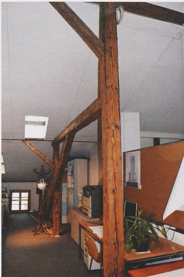
13. Adaptacja poddasza w kamienicy przy ul. Św. Jana 12 na potrzeby Pracowni Architektonicznej DDJM w 2000 r. Stan obecny. Fot. J. Kołodziejczyk 2014
