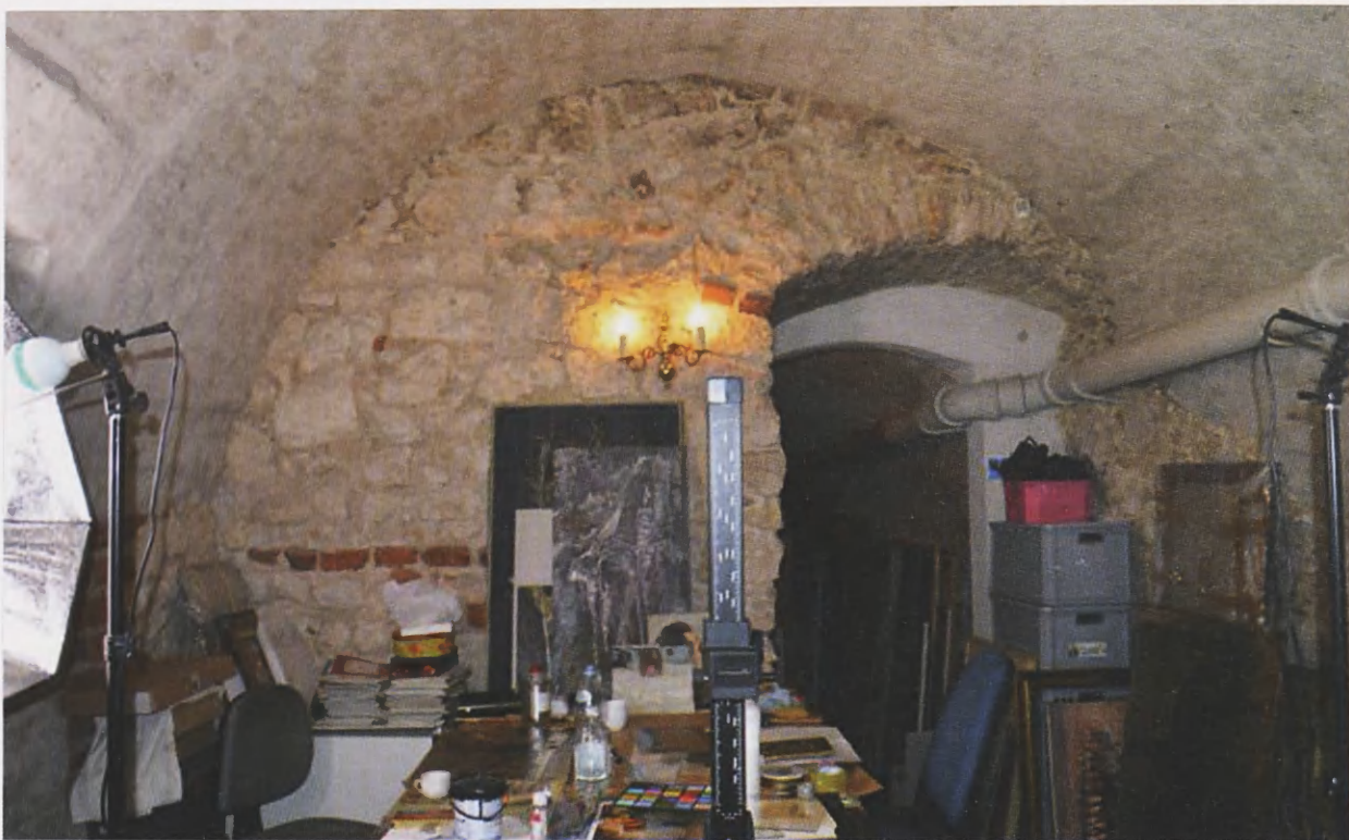
14. Portal i wątki murów w piwnicy pod oficyną kamienicy przy ul. Św. Jana 12. Stan po konserwacji w 2003. Fot. A. Kałużny 2003
