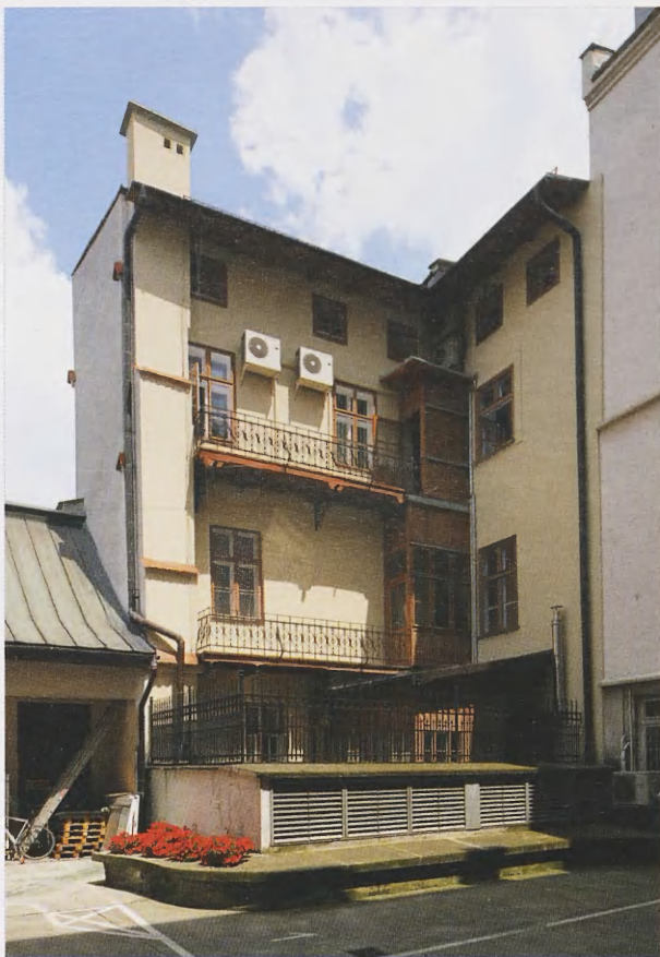
9. Elewacja tylna kamienicy przy ul. Św. Jana 12. Stan obecny. Widoczny komin kotłowni gazowej oraz drewniana altana nad zejściem piwnicznym w podwórzu, zrealizowane w 1991 r. Fot. T. Kalarus 2013
