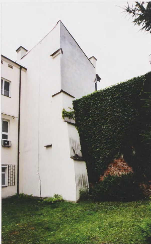
3. Szkarpa wspierająca narożnik północno-zachodni oficyny w kamienicy przy ul. Św. Jana 12 zbudowana jako zabezpieczenie budynku w 1990 r. Stan obecny. Fot. Z. Beiersdorf 2015
