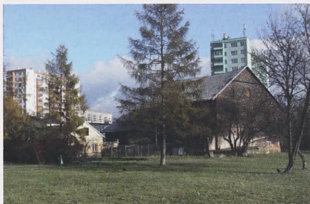
15. Zespół dawnego młyna dominikańskiego i park. Stan z 2006. Fot. Paweł Dettloff
