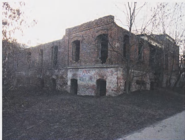
22. Budynek dawnego młyna „Bularnia” na Prądniku Białym. Widok od strony wschodniej. Stan z 2006. Fot. Paweł Dettloff
