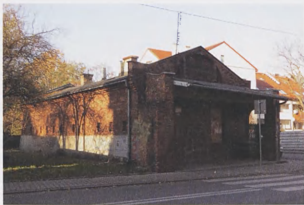
16. Rogatka zakrzowiecka widoczna w centrum il. 15 – stan obecny, 2016. Fot. Andrzej Laskowski
