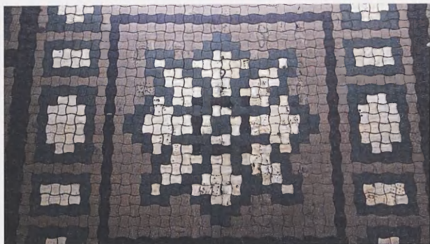
23. Fragment ceramicznej okładziny wykonanej przez zakład Jana Godzickiego w 1913, kamienica Ohrensteina, ul. Stradomska 27. Fot. Agnieszka Partridge, 2015
