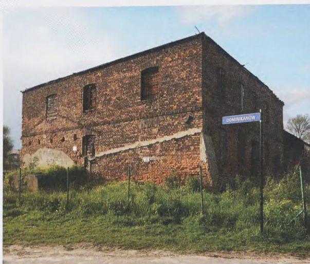
18. Budynek dawnego młyna dominikańskiego na Prądniku Czerwonym (przy ul. Olszeckiej 18). Widok od strony południowo-wschodniej. Stan z 2017. Fot. Paweł Dettloff
