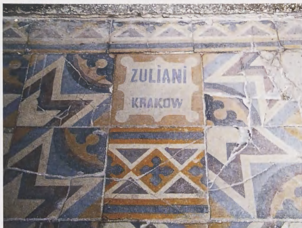
20. Kraków, ul. Stroma 6, posadzka z 1912 pochodząca z firmy Franciszka Zulianiego z winietą fabryki
