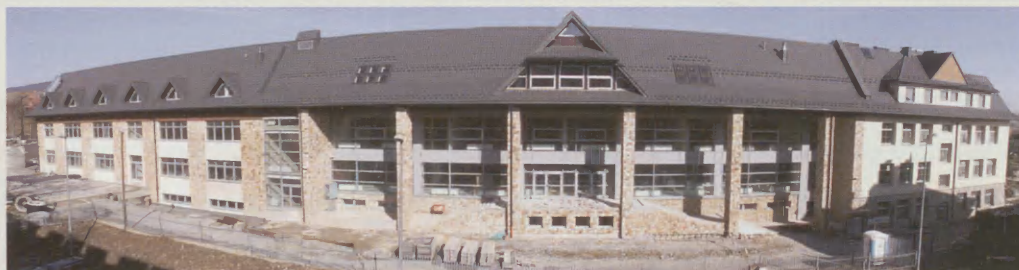
Etap budowy Centrum Biblioteczno-Dydaktycznego
