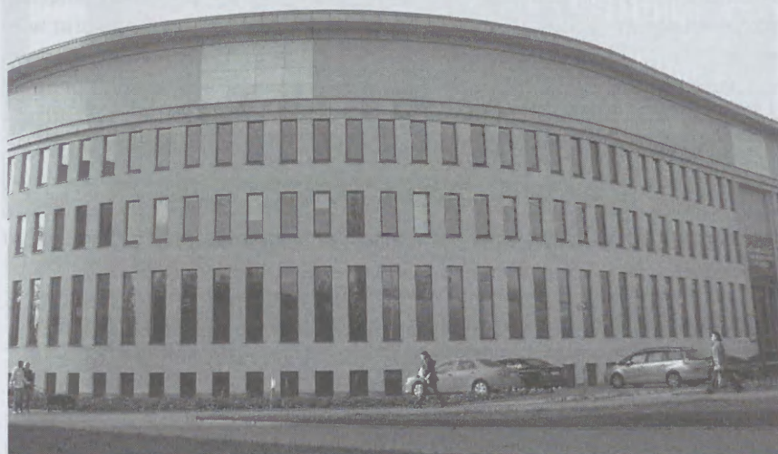
Fot. 3. Rozbudowa budynku Sądu Apelacyjnego i Okręgowego, proj. Wojciech Obtulowicz, 2010 Łódź (źródło: fot. aut.)
