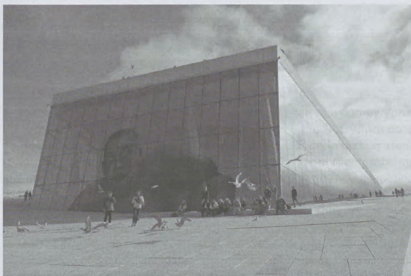
Fot. 6. Plac na dachu opery w Oslo (źródło: fot. Piotr Celewicz)
