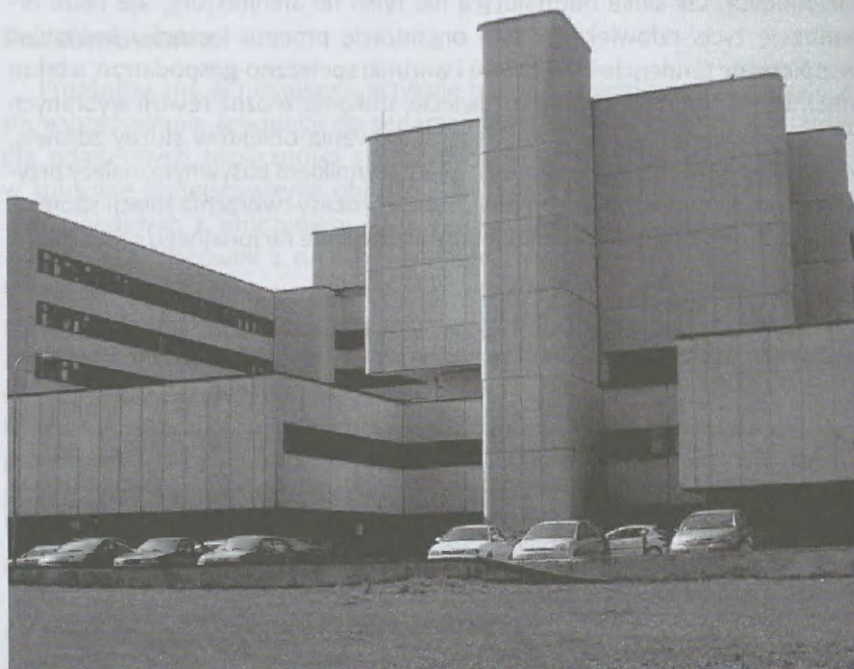
Fot. 1. Instytut Centrum Zdrowia Matki Polki w Łodzi; lata budowy: 1982-87 (88); projekt architektoniczny: Janusz Wyżnikiewicz – Miastoprojekt Łódź (źródło: fot. aut.)
