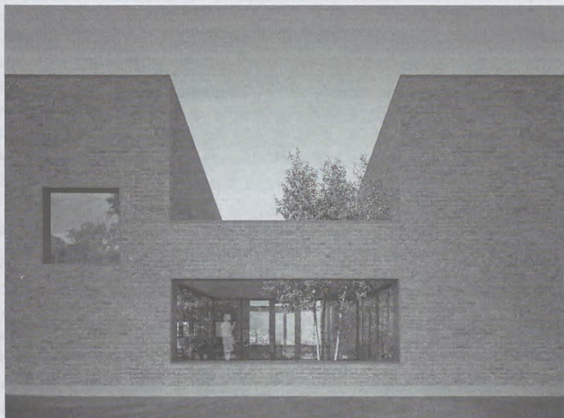
Il. 5. Elewacja tylna z widocznym patio (źródło: 9780 Architekci)
