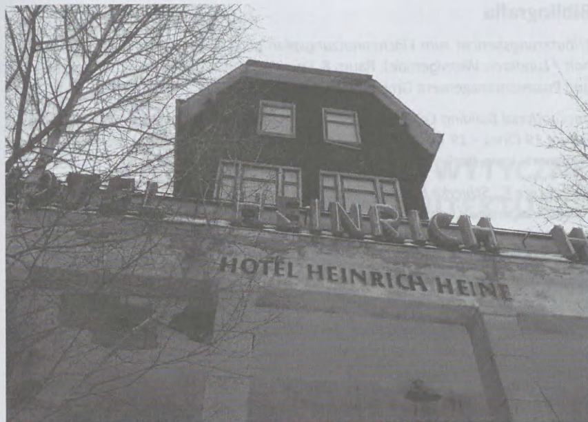
Fot. 1. Schierke – Hotel Heinrich-Heine dawniej symbol rozkwitu miasta, dziś przykład jego upadku (źródło: fot. P. Kowalski)
