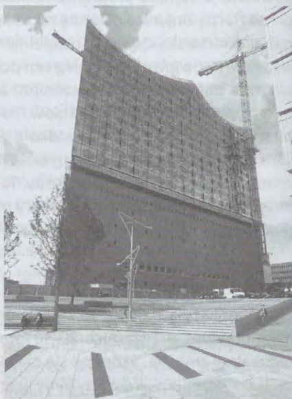
Fot. 2. Plac przy Elbphilharmonie (źródło: fot. Wacław Seruga)
