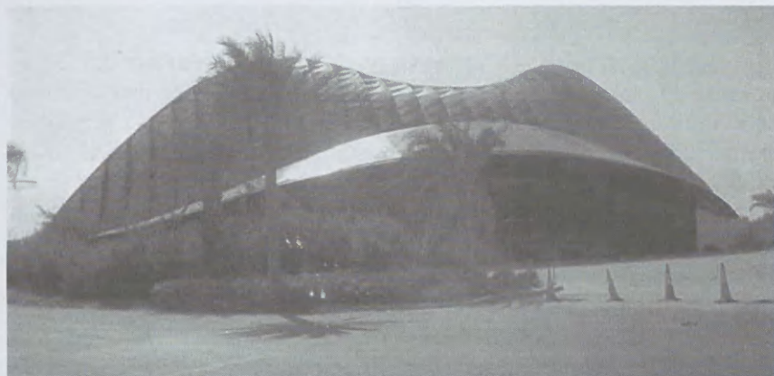
Fot. 4. Nowoczesny obiekt na Wyspie Saadiyat (Wyspa Szczęścia) w dzielnicy kreatywnej Abu Dhabi (źródło: fot. aut.)
