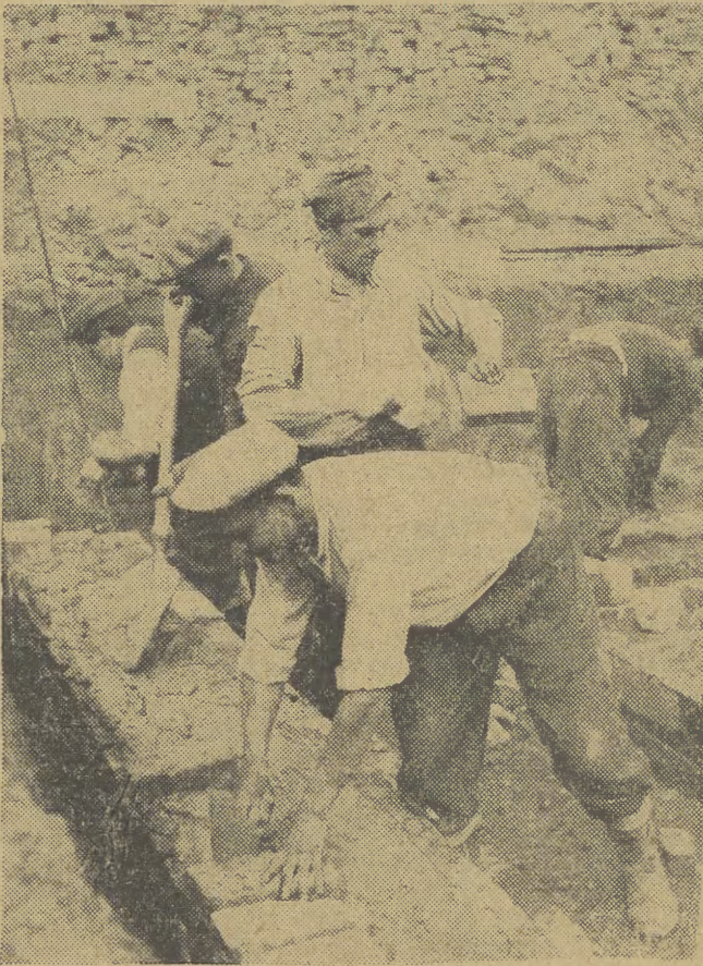
Na budowie osiedla mieszkaniowego na Mokotowie w Warszawie, dnia 1 kwietnia rozpoczęły budowę młodzieżowe ZMP. Po raz pierwszy w Polsce blok mieszkaniowy zostanie wykonany wyłącznie przez młodzież. Na zdjęciu młodzi murarze przy pracy — Kazimierz Błados, B. Pietras, H. Gajewski i P. Uznański.
