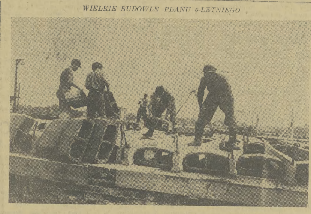
Wielkie budowle planu 6-letniego
