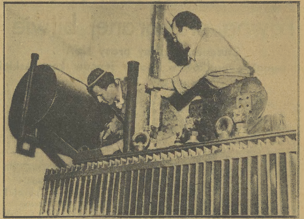
W 1953 roku rozpocznie pracę, jedna z największych kopalń węgla w Polsce — kopalnia „Gigant”, z której otrzymywać będziemy wysoko-gatunkowy węgiel koksujący. Na zdjęciu: monterzy R. Haka i J. Grygorczyk montują transformator.
