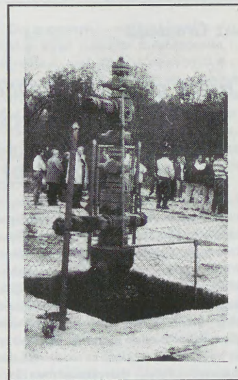
Jedna z głowic eksploatacyjnych na odwiercie wód geotermalnych (Fot. T. Pudysz)
