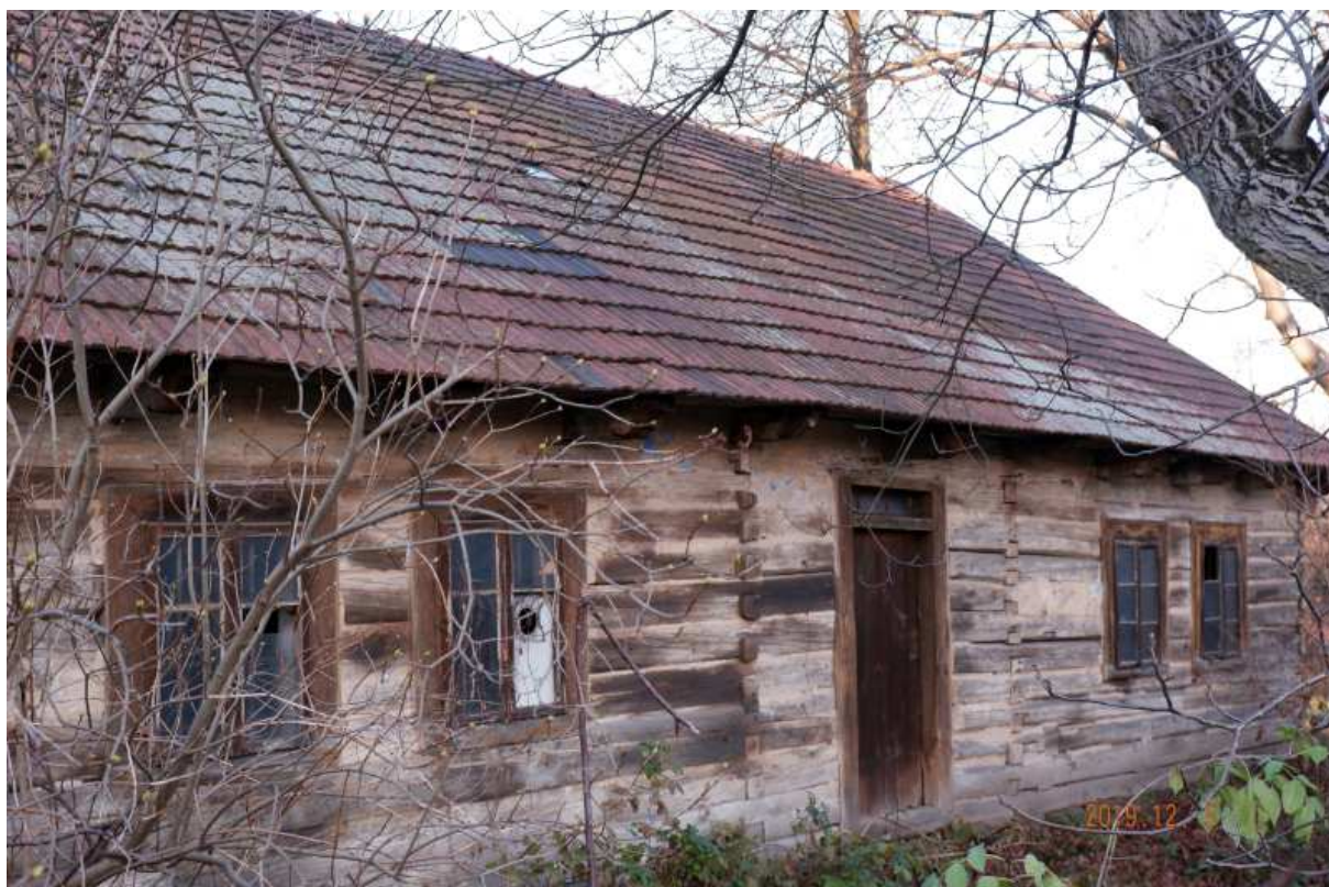
Fot. nr 234. Widok od strony ogrodu.
