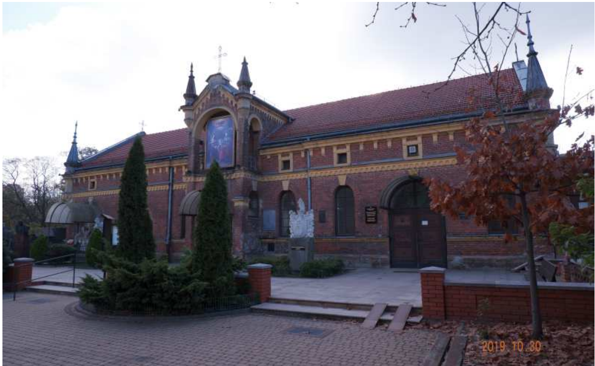
Fot. nr 544. Kaplica Augustianów przerobiona z wozowni w roku 1911.
