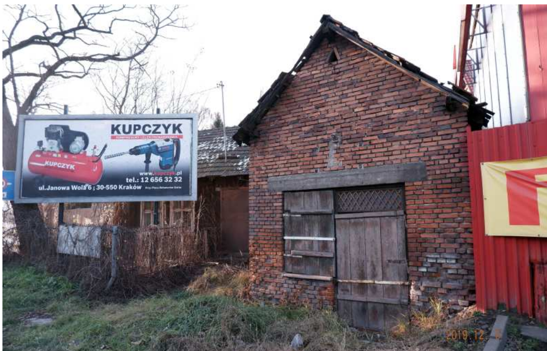
Fot. nr 188 (188-190). Zabudowania mieszkalno-gospodarcze przy ulicy Kocmyrzowskiej 1.
