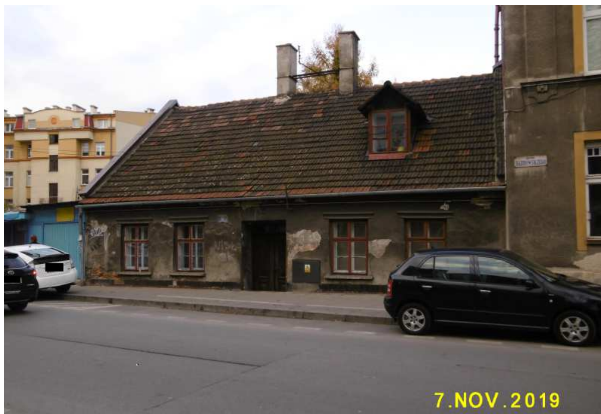
Fot. nr 434(434-437). Relikt niskiej zabudowy Podgórze z ulicy Dąbrówki 12.
