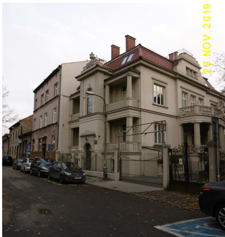
Fot. nr 355 (355-359). Wzdłuż ulicy Zduńskiej ku ulicy Konopnickiej.
