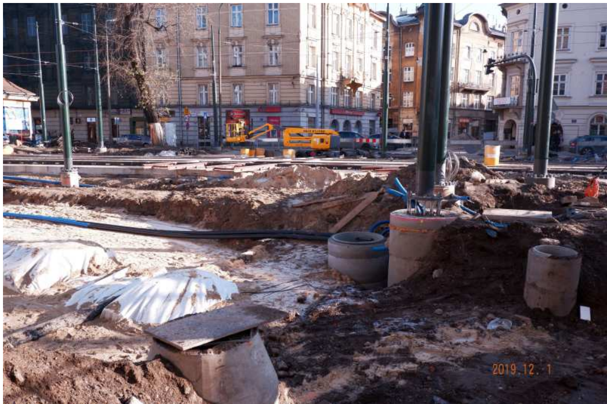
Fot. nr 376 (376-377). Porządkowanie terenu po wykopaliskach związanych z odkryciem pozostałości Mostu Królewskiego u wylotu ulicy Stradomskiej.
