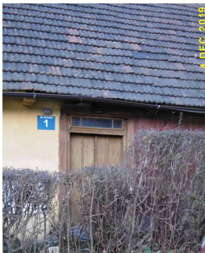
Fot. nr 180. Oryginalne drzwi, które pozwalają datować obiekt nawet na koniec XIX wieku.
