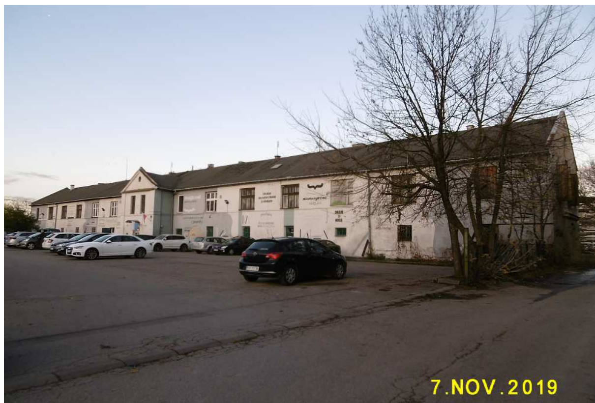
Fot. nr 425. Pozostałości po dawnym składzie solnym przy ulicy Na Zjeździe 8, z którego pozostał tylko budynek dawnych stajni.
