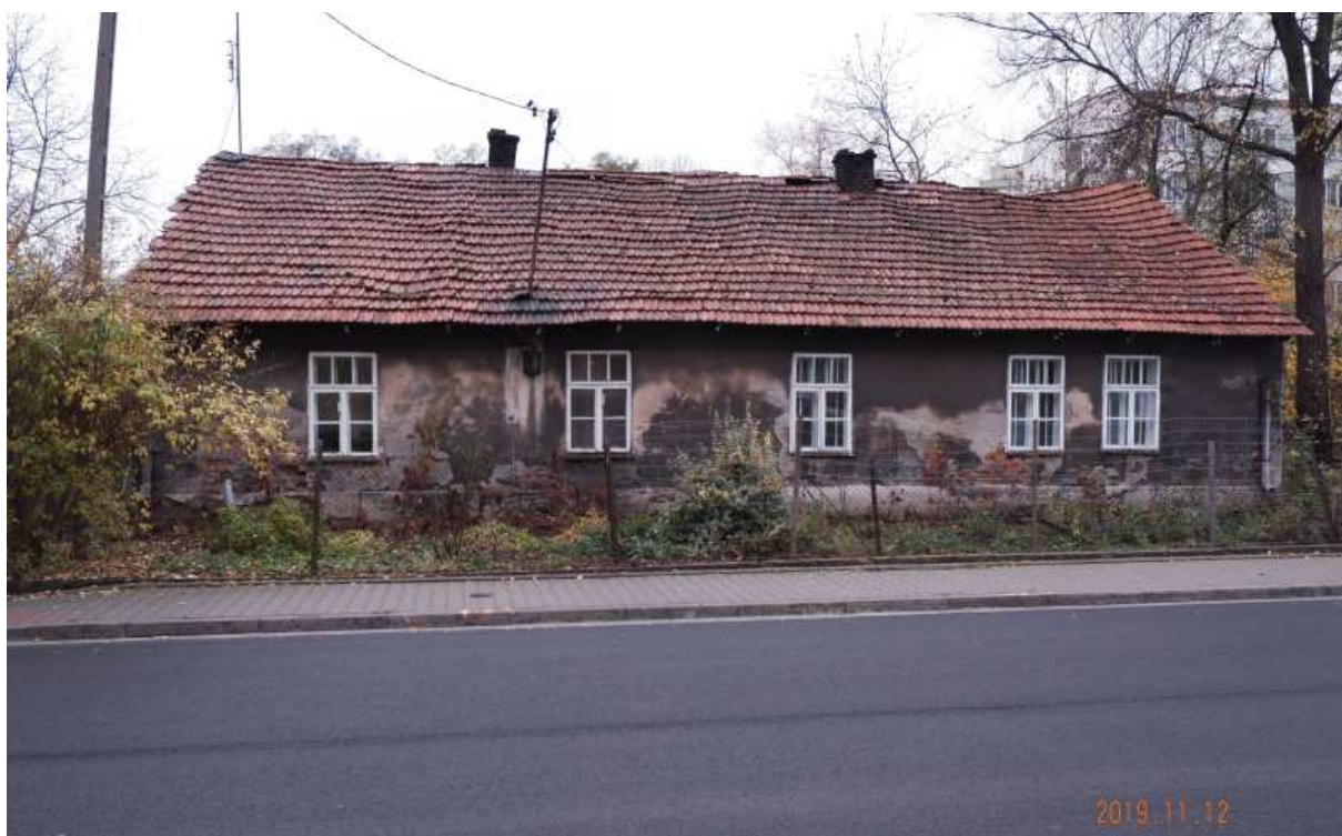
Fot. nr 208. Fasada międzywojennego domu od strony ulicy.
