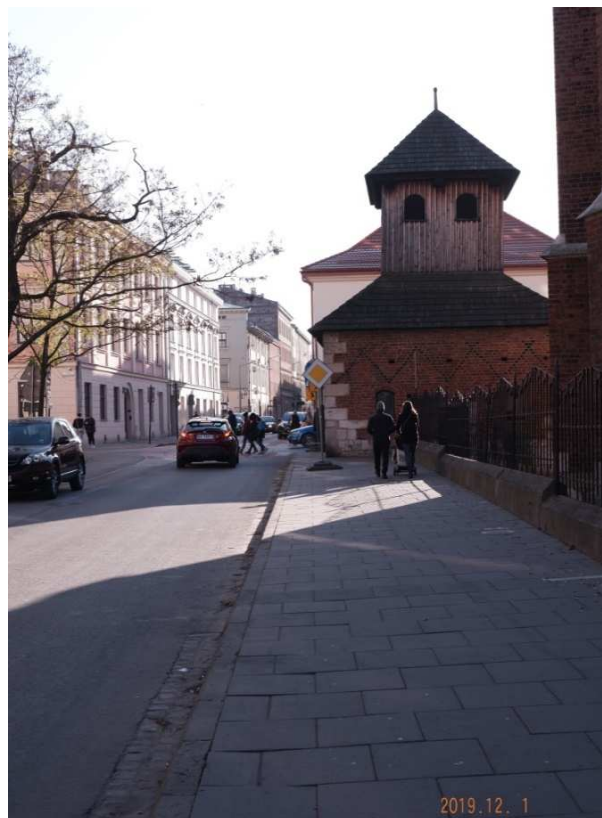
Fot. nr 421. Dzwonnica przy kościele św. Katarzyny.
