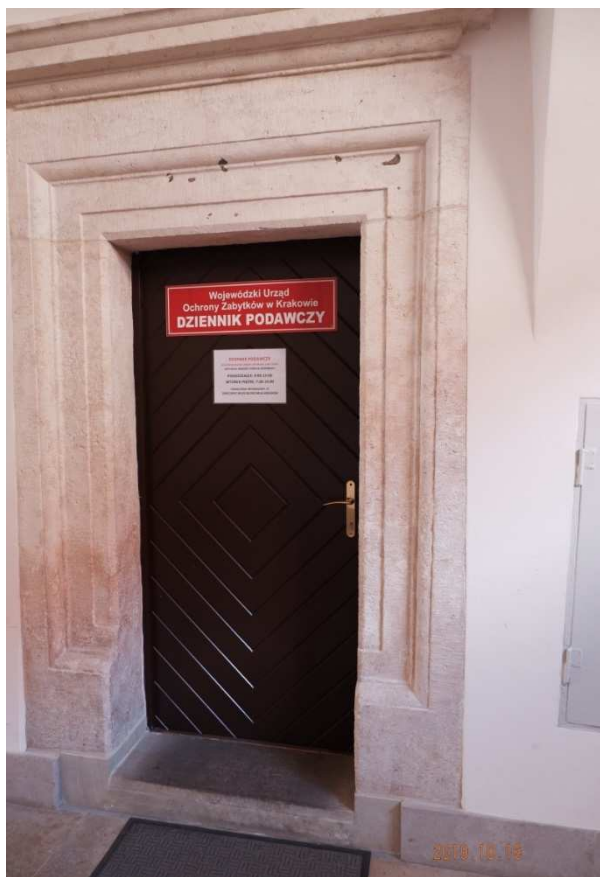
Fot. nr 75 (75-76). Portale w sieni.
