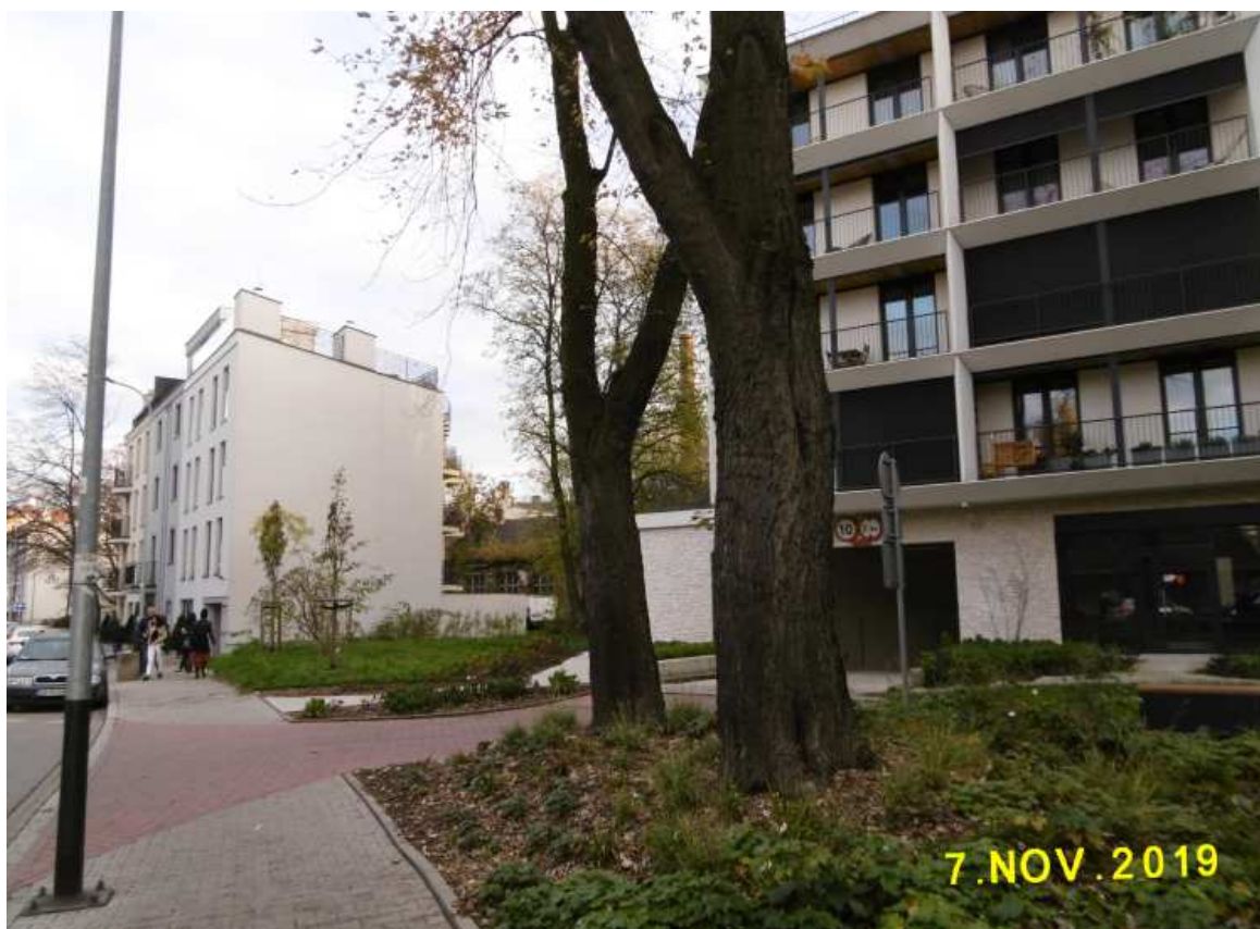
Fot. nr 438 (438-439). Zabudowa ulicy Dąbrowskiego o numerach: 5-9, usytuowana na przedpolu dawnej fabryki czekolady Kryształ.
