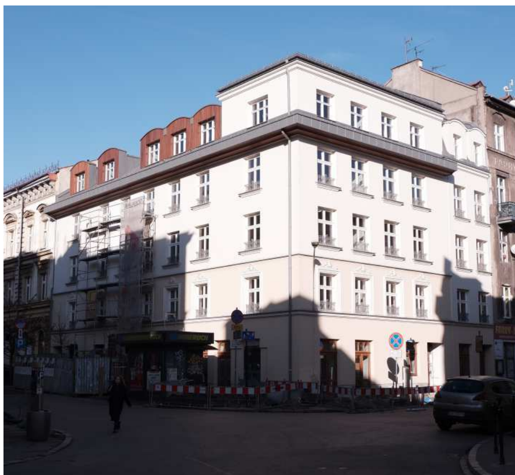
Fot. nr 391. Pretekstem do przesadnie wysokiej nadbudowy stał się pożar. (01.12.2019)
