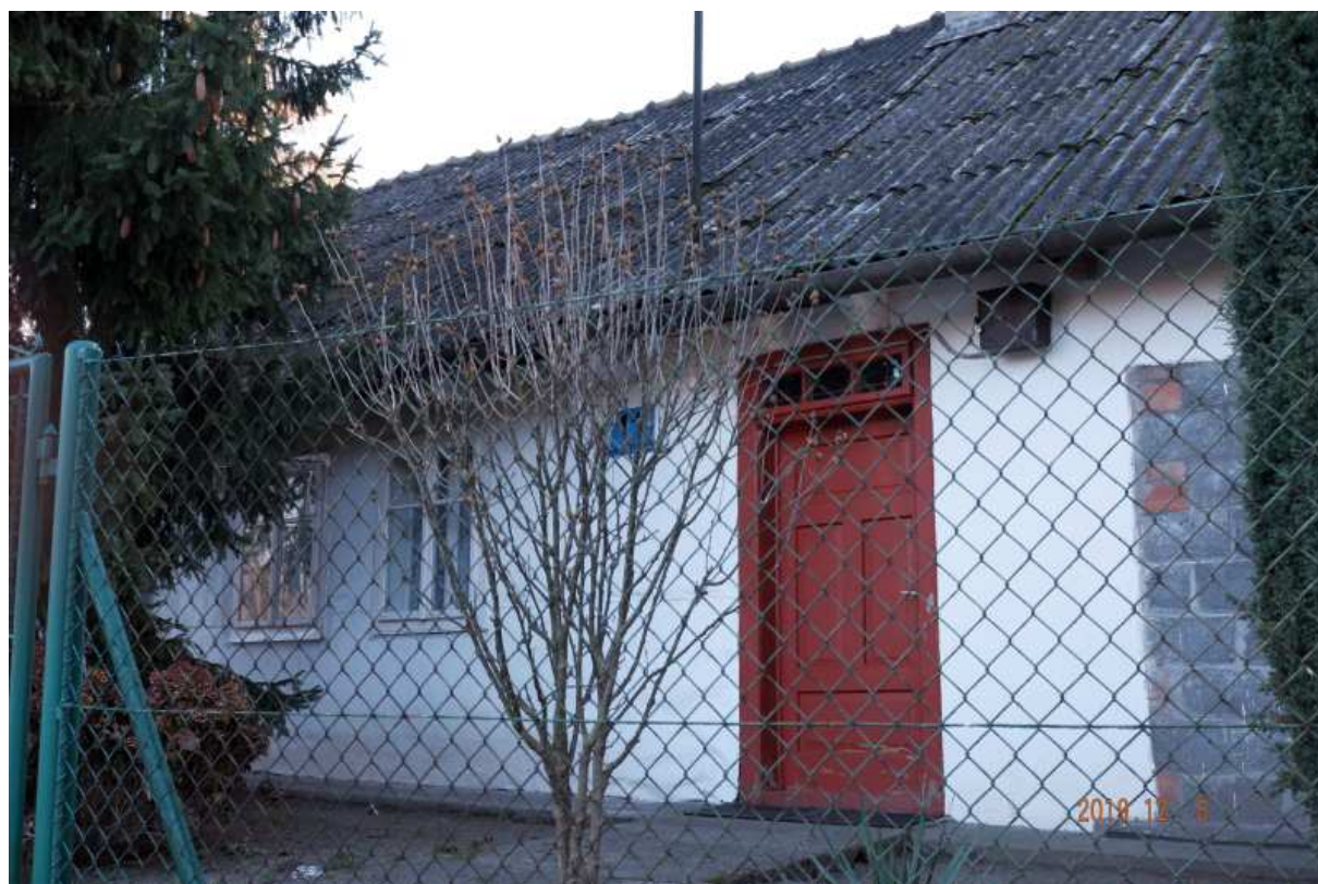
Fot. nr 200. Fasada od strony ulicy.
