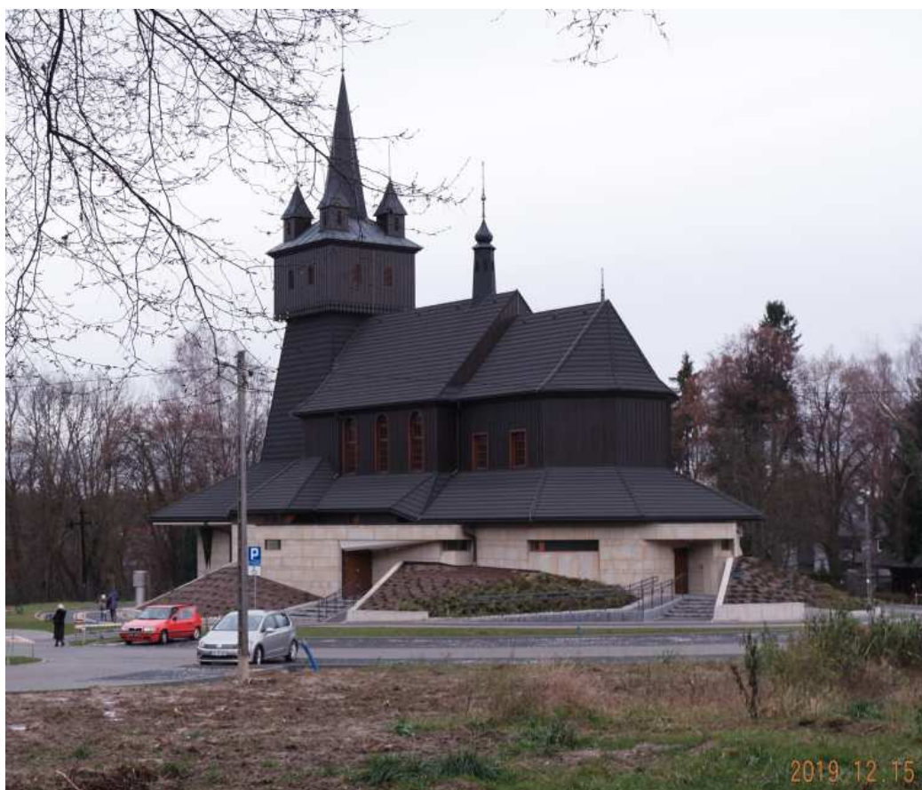
Fot. nr 264. Nowy kościół to obiekt do parteru betonowy, który powyżej ma przypominać dawny, drewniany poprzednik.
