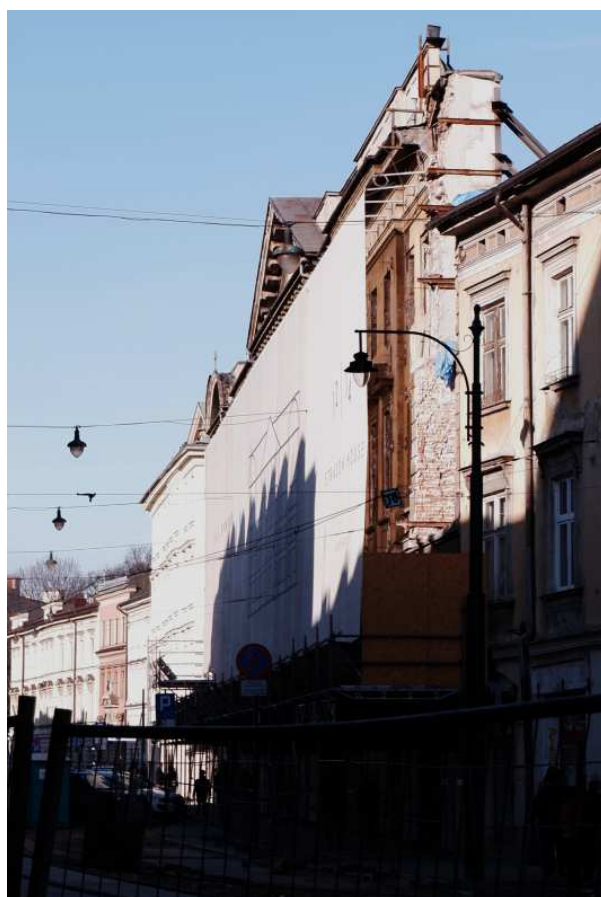
Fot. nr 379. Bezprzykładny sposób niszczenia zabytkowej zabudowy.
