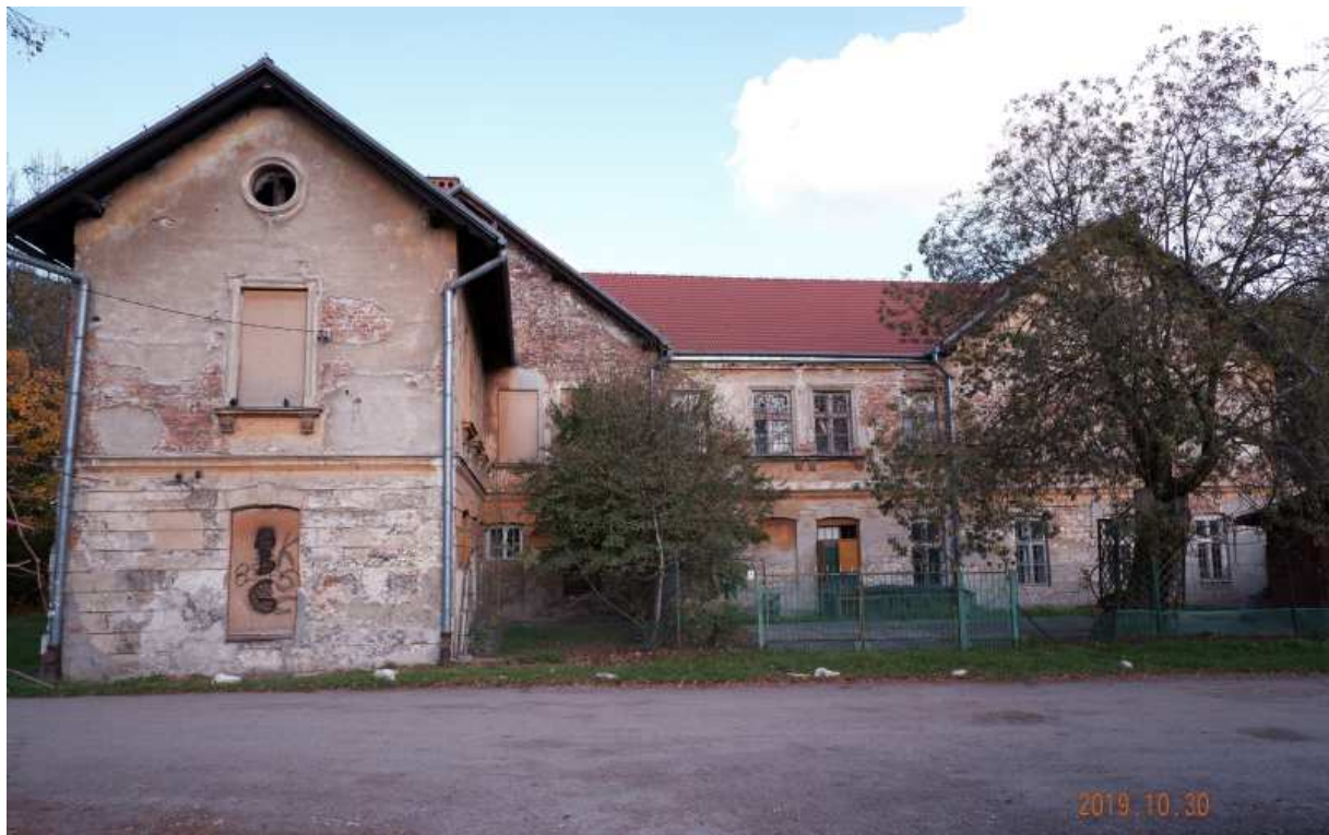
Fot. nr 543. Obiekt powstał pod koniec XIX wieku z połączenia z dwóch luźnostojących budynków gospodarczych.
