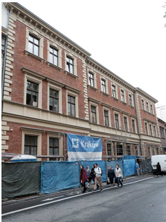
Fot. nr 258. Kamienica Izby Lekarskiej z ul. Krupniczej 11A na końcowym etapie remontu.
