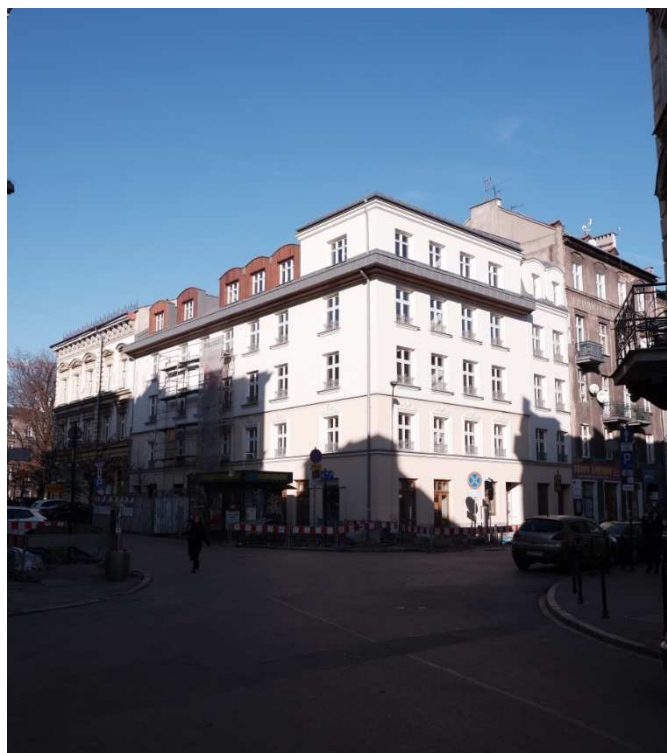
Fot. nr 390 (390-391). Nadbudowany o dwa piętra dom pod nr 10. (01.12.2019)
