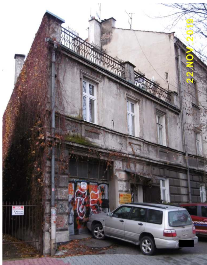
Fot. nr 352. Piętrowy dom z ulicy Barskiej 41.
