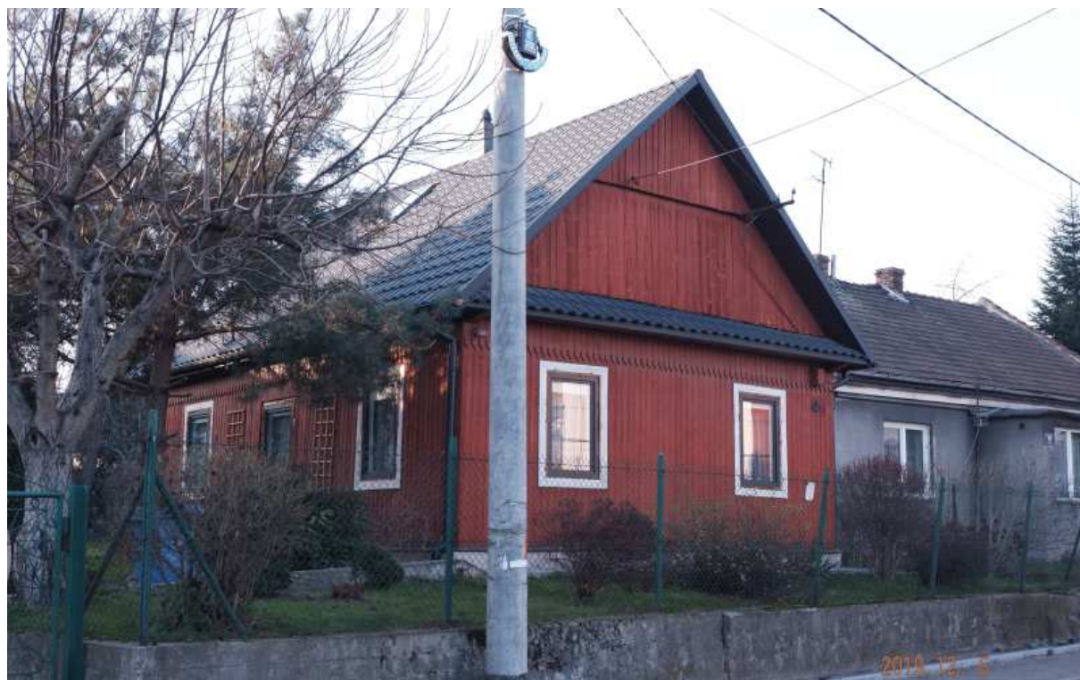
Fot. nr 232. Dom z ulicy Fatimskiej 45. I tu nie ma już oryginalnych okien, które co dopiero zastąpiły dawne oryginały.
