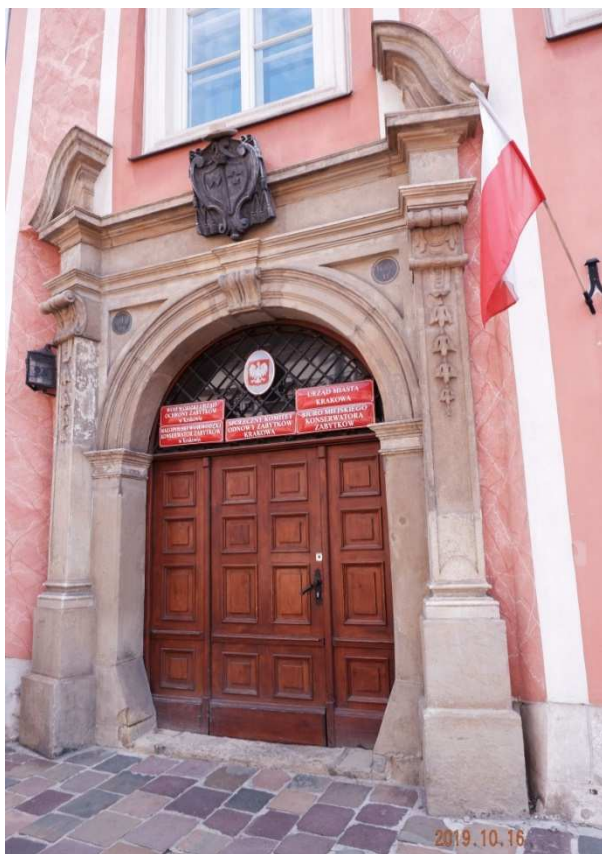
Fot. nr 74. Portal wejściowy.
