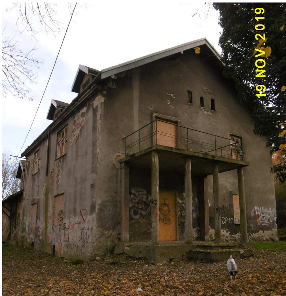
Fot. nr 471. Boczna ściana i wejście od strony ulicy Estońskiej.
