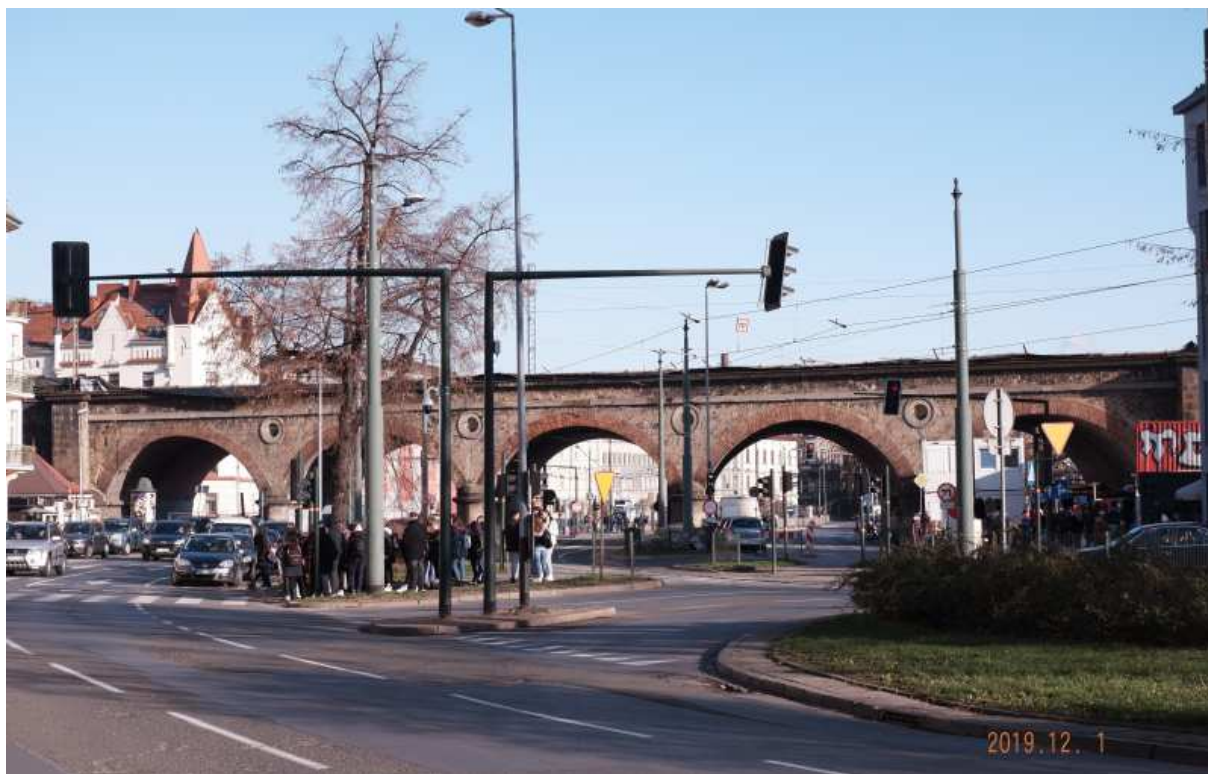
Fot. nr 171 (171-172). Jaki los czeka wiadukt kolejowy przy ulicy Grzegórzeckiej. Choć to zabytek z roku 1863, wybudowany na kształt rzymskiego akweduktu, grozi mu rozbiórka.
