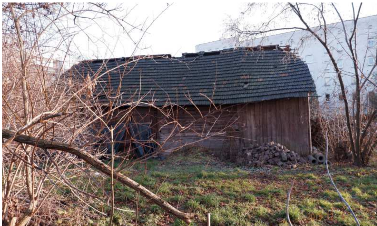
Fot. nr 209. Ponad 100-letnia stodoła w zagrodzie pod nr 21. Widok z ulicy Łyszkiewicza.
