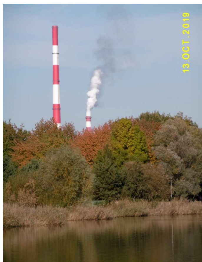
Fot. nr 517. Kominy elektrociepłowni w Łęgu
