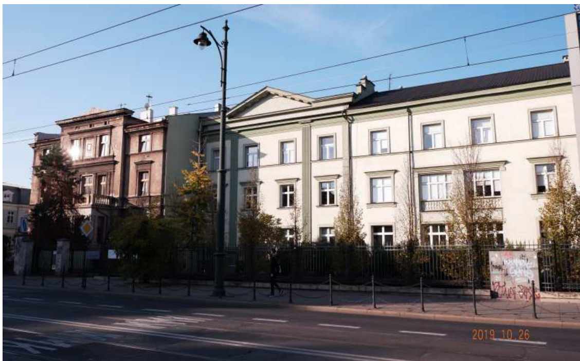
Fot. nr 123. Fragment zabudowy ulicy Lubicz w bliskości ulicy Ariańskiej. Z prawej kamienica pod nr 46.
