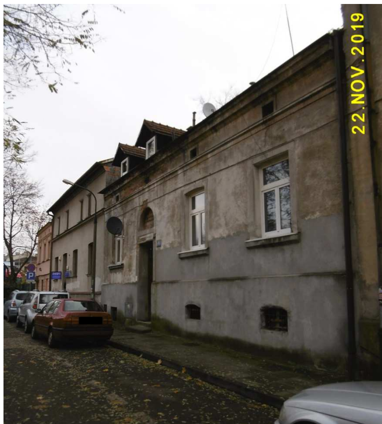
Fot. nr 357. Fragment zabudowy poniżej domu spod nr 10.
