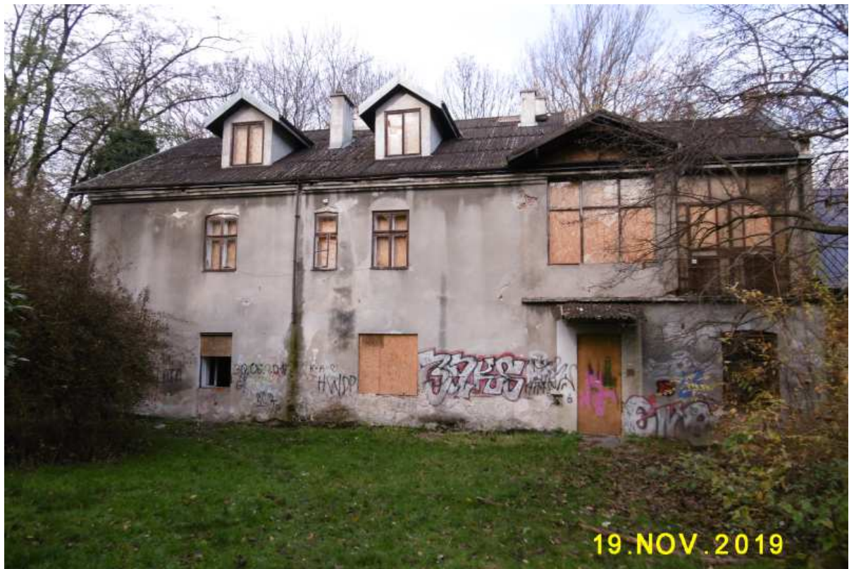
Fot. nr 472. Fasada dworu.
