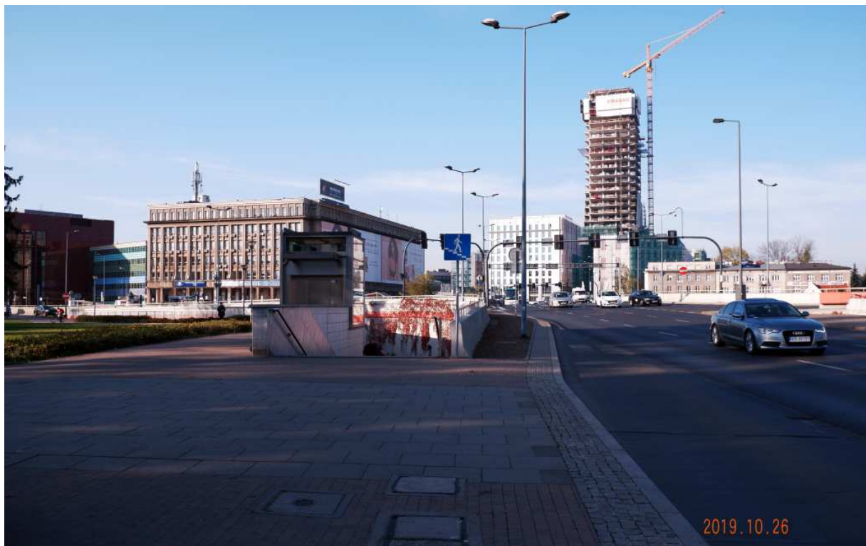
Fot. nr 137 (137-140). „Szkieletor” na końcowym etapie przebudowy. Widoki z ronda Mogilskiego.
