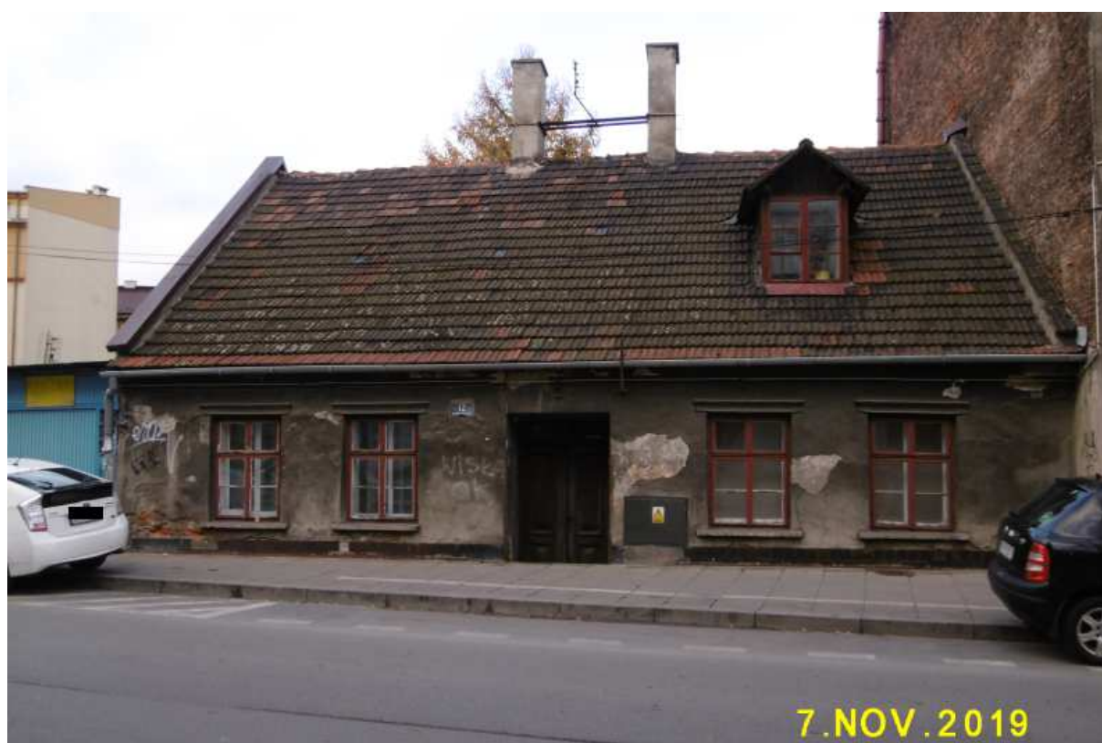
Fot. nr 435. Fasada z facjatką w dachu.
