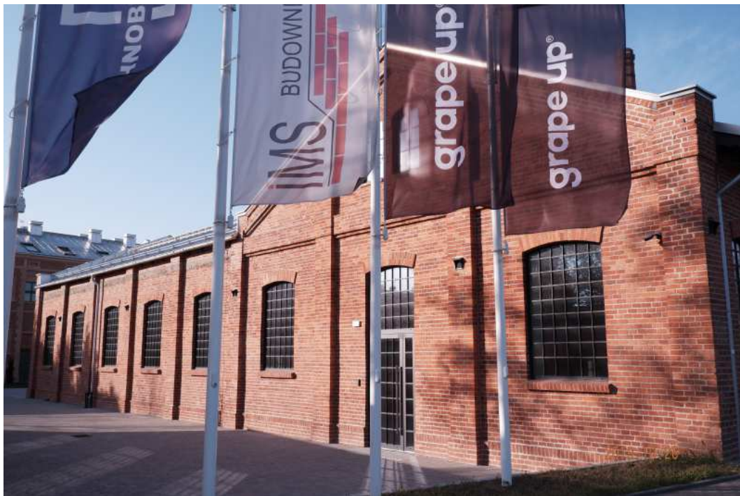
Fot. nr 167 (167-170). Już niedługo dawne zabudowania fabryki Erdal przy ulicy Żółkiewskiego 17 posłużą jako galerie handlowe. Godne to pochwały rozwiązanie.
