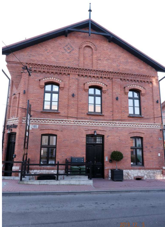
Fot. nr 185 (185-186). Budynek Bieńczyckiego Sokoła z ulicy Cienistej 1.
