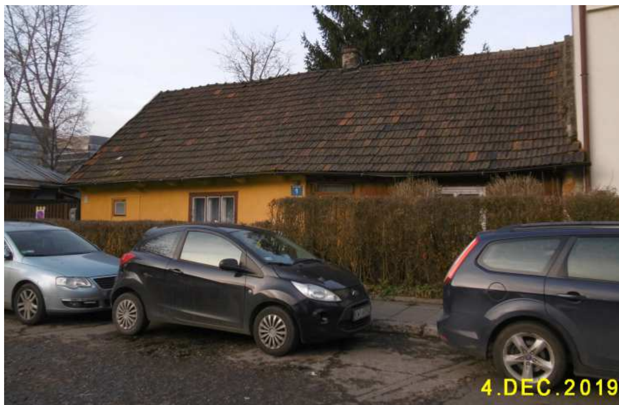
Fot. nr 179 (179-180). Ostania chałupa na terenie Dąbia przy ulicy Na Szaniec 1.
