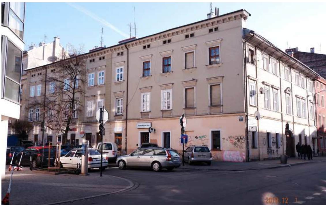
Fot. nr 406. 200-letnia kamienica z naroża ulic: Augustiańskiej 26 i Węglowej 4, której nieuporządkowana fasada budzi niesmak.
