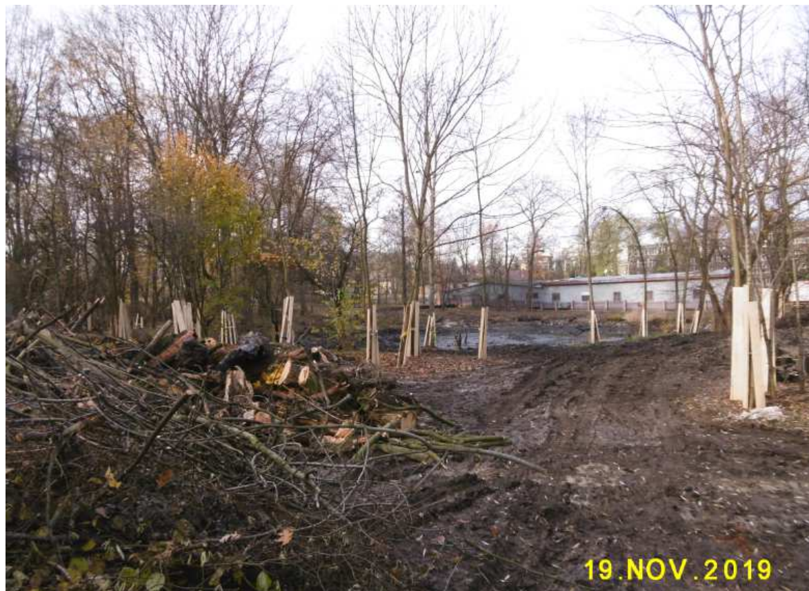
Fot. nr 467. Oczyszczanie stawu.
