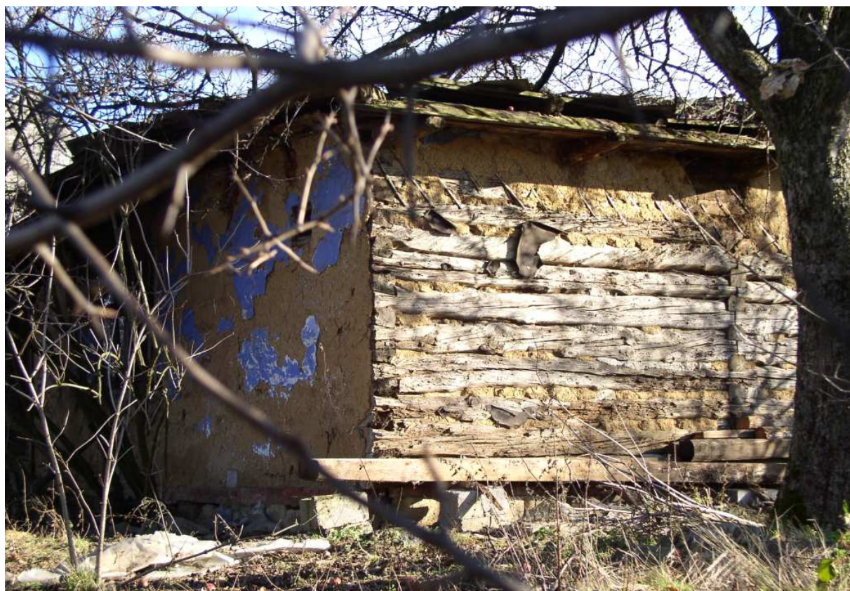
Fot. nr 143. Konstrukcja zrębowa w boku od strony drogi. Z tyłu fragment dawnego bielenia z dodatkiem siwki. (02.12.2008)
