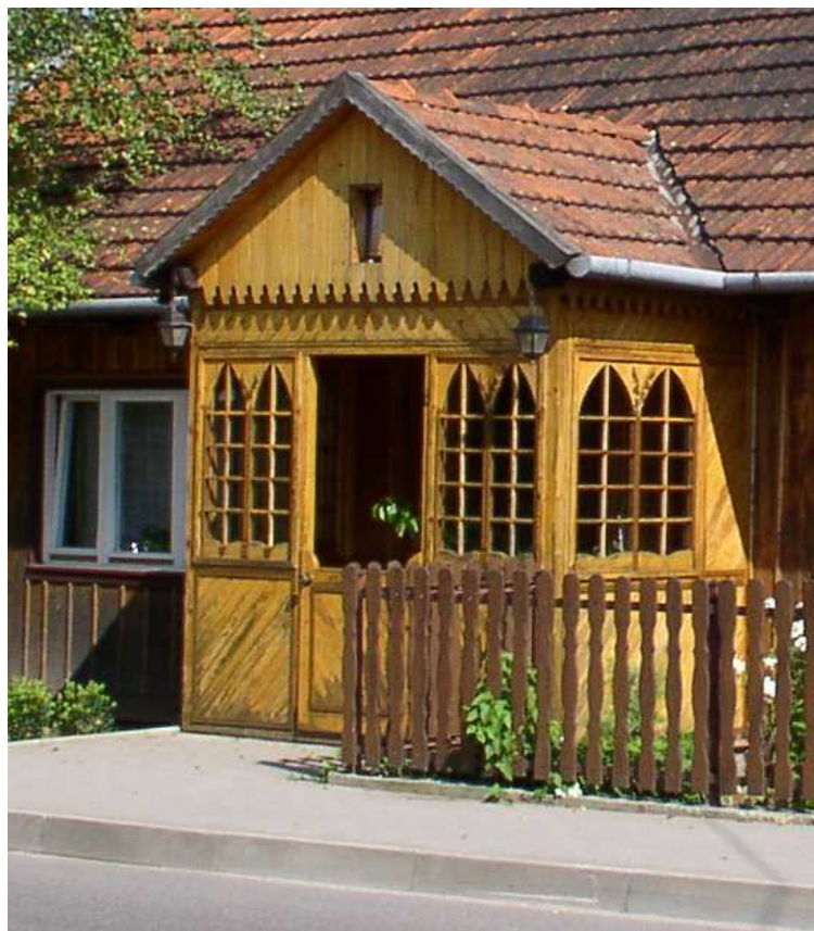
Fot. nr 12. Przysłonięty drewnianym zdobieniem ganek. (05.08.2010)
