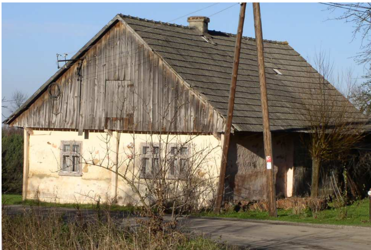
Fot. nr 131. Boczna ściana od strony drogi. (02.12.2008)
