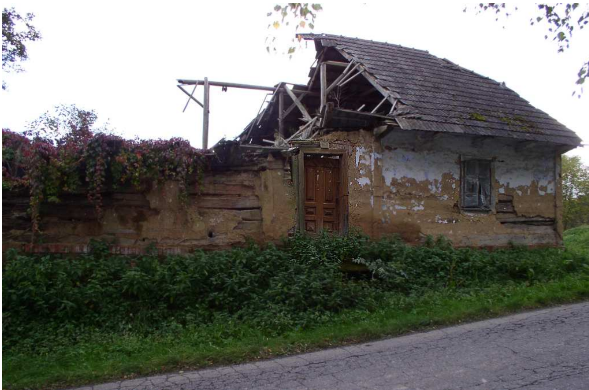
Fot. nr 153. Widok od strony drogi. Z prawej zapewne kuchnia. (11.10.2009)
