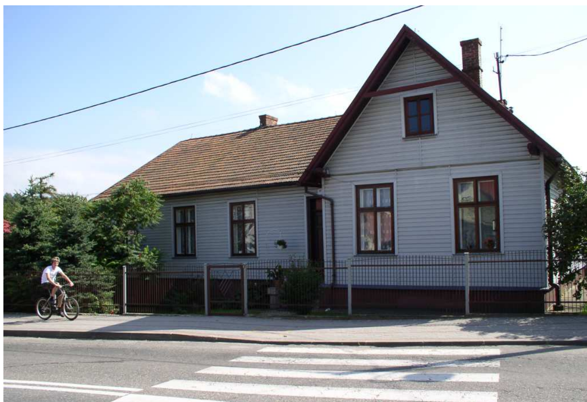
Fot. nr 18. Widok na fasadę, w której zachowały się oryginalne okna. (05.08.2010)
