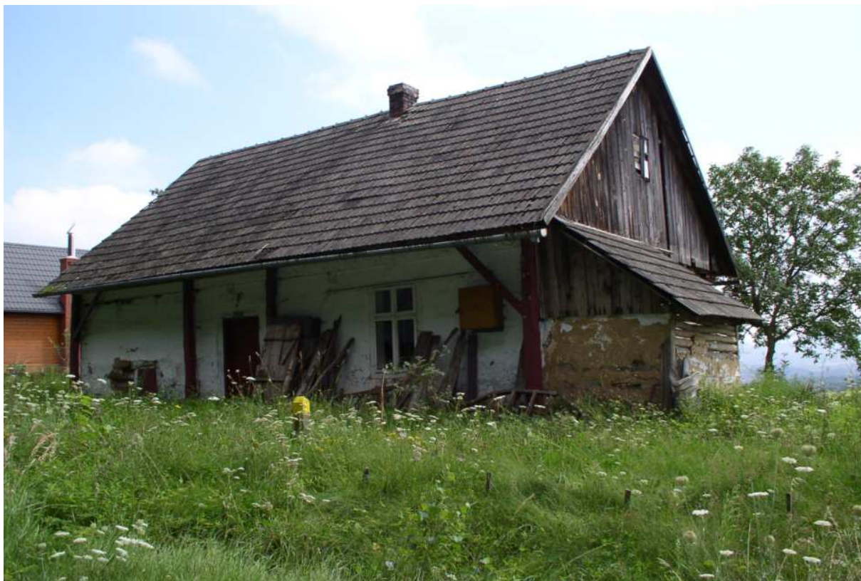
Fot. nr 81. Widok od strony drogi. (05.08.2010)
