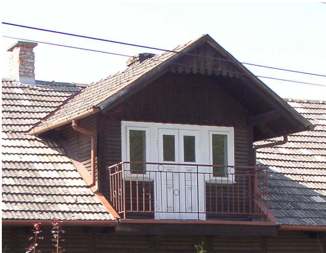
Fot. nr 9. Facjatka w dachu domu. (05.08.2010)
