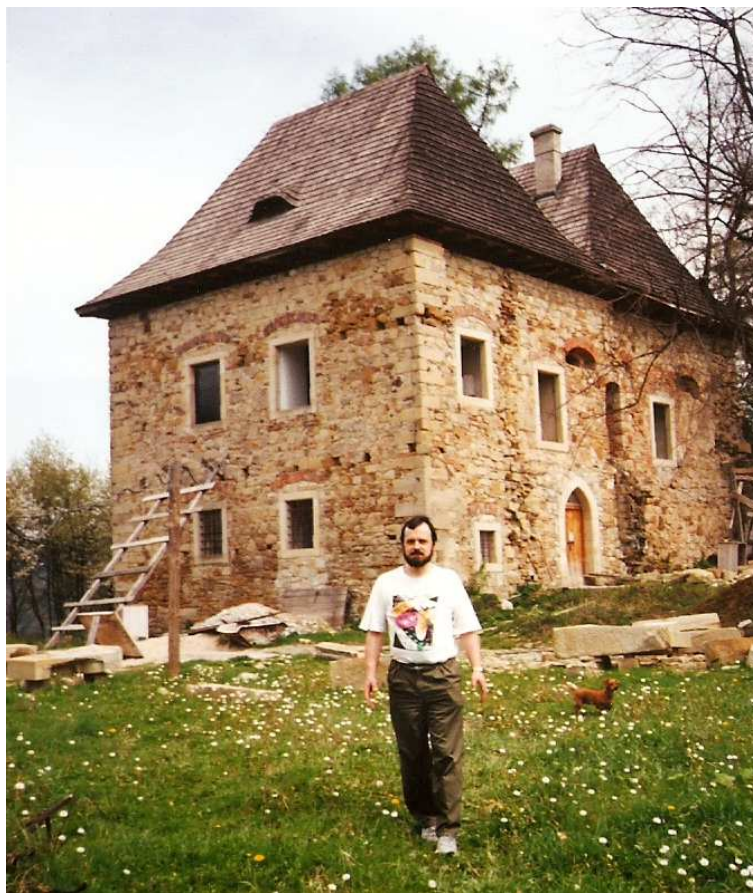
Fot. nr 166 (166-168). Trzy ujęcia dworu obronny, którego początki sięgają XVI wieku, na etapie remontu. (1994)
