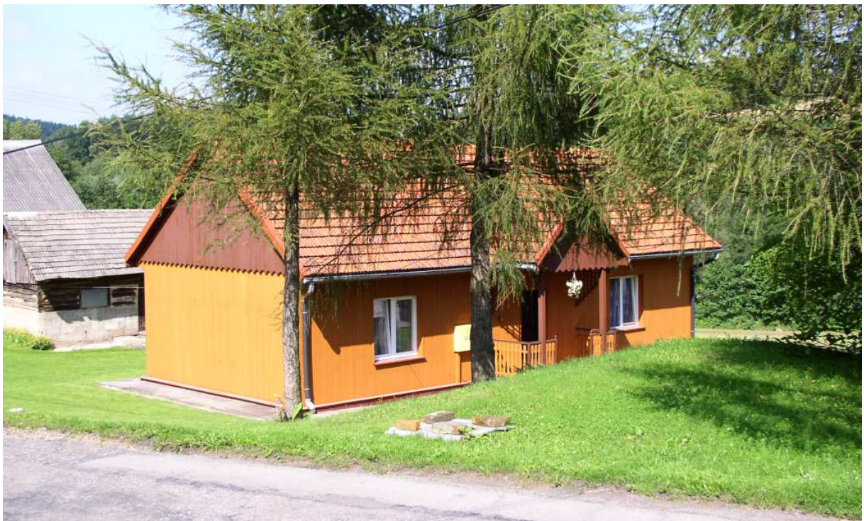
Fot. nr 56. Dom z oryginalnym gankiem i współczesnymi już oknami plastikowymi, które utrudniają jego datowanie. (05.08.2010)
