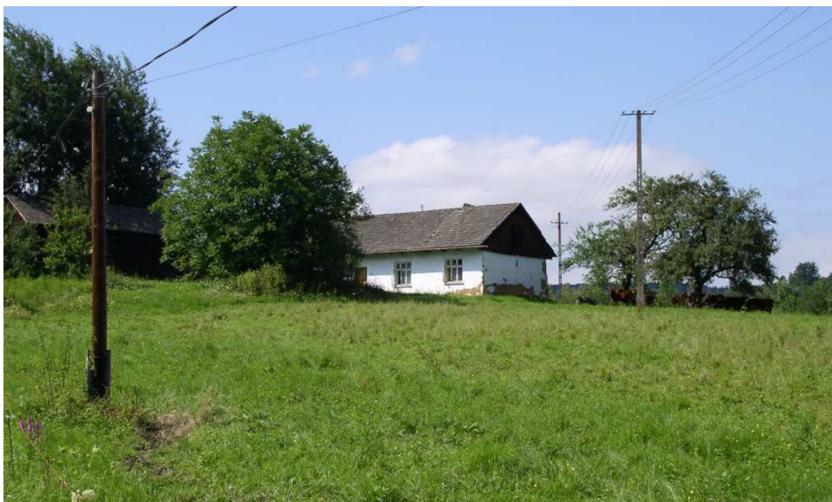
Fot. nr 58 (58-60). Zapewne przedwojenny dom pod nr 16, w którym zachowały się oryginalne okna, w kompleksie z częścią gospodarczą. (05.08.2010)
