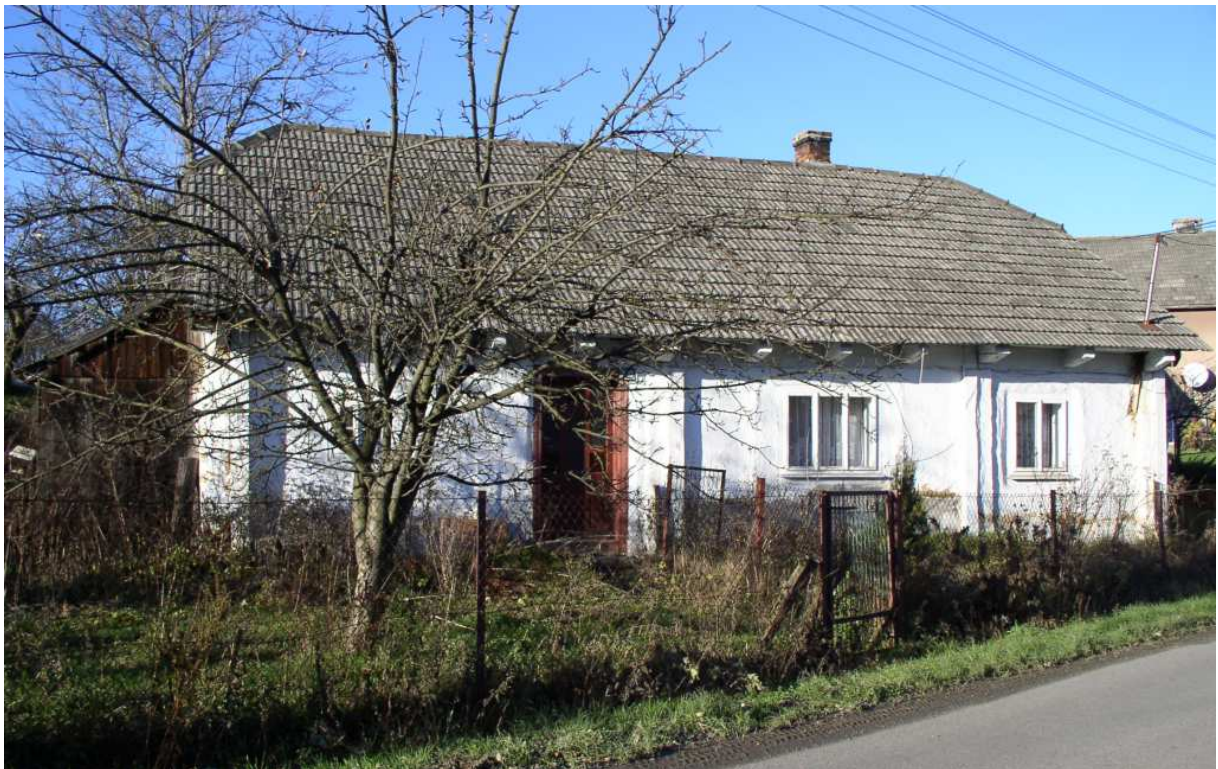
Fot. nr 111 (111-114). Nieistniejąca już, bliska oryginałowi, bielona chałupa pod nr 33. Mogła powstać na początku XX wieku. (02.012.2008)
