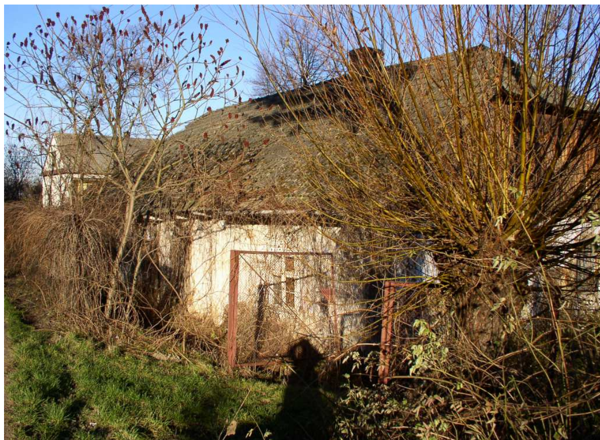
Fot. nr 109 (109-110). Widoki z drogi przelotowej. (02.012.2008)
