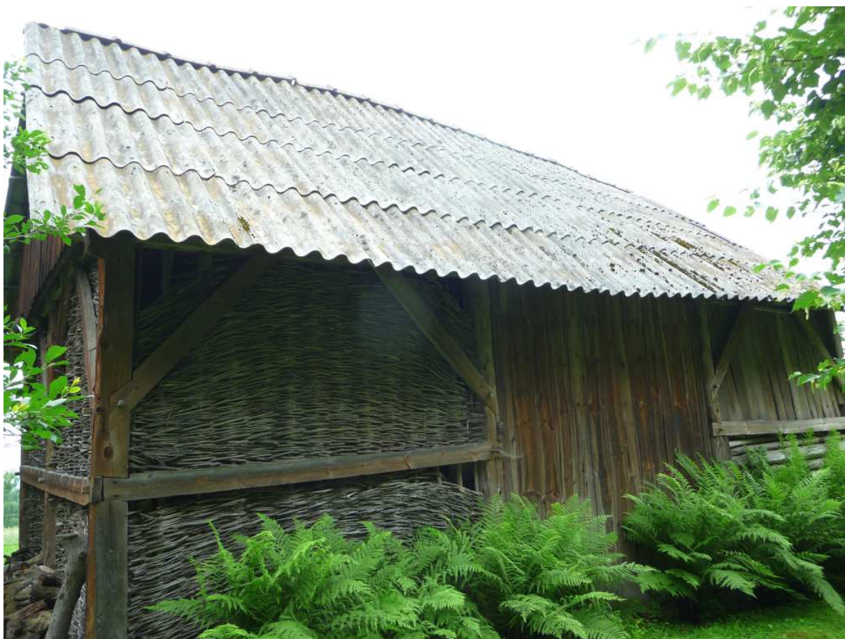
Fot. nr 88 (88-91). Nieistniejąca już archaiczna stodoła typu plecionkowego, częściowo wyplatana wikliną, na posesji pod nr 41 (?). (27.06.2013)
