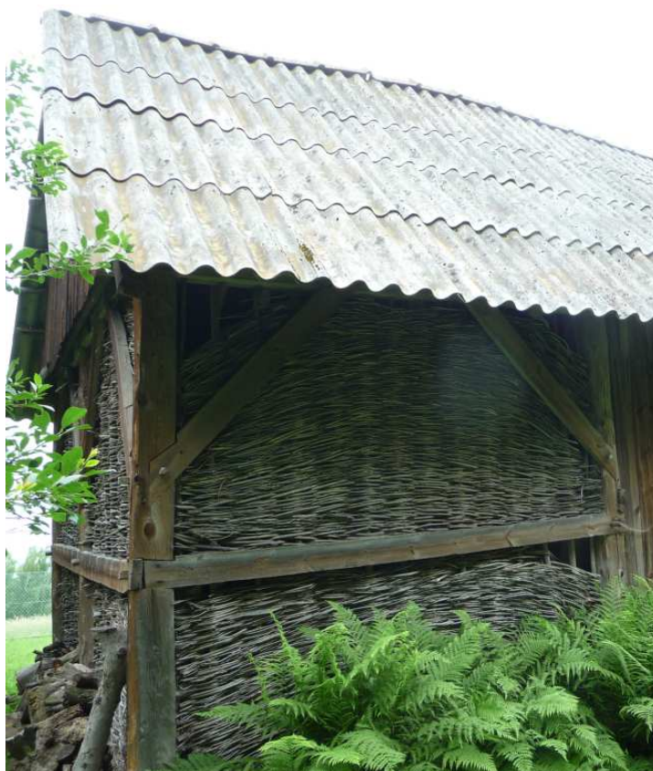
Fot. nr 89. Lewy fragment z wyplatanyimi wikliną ścianami. (27.06.2013)
