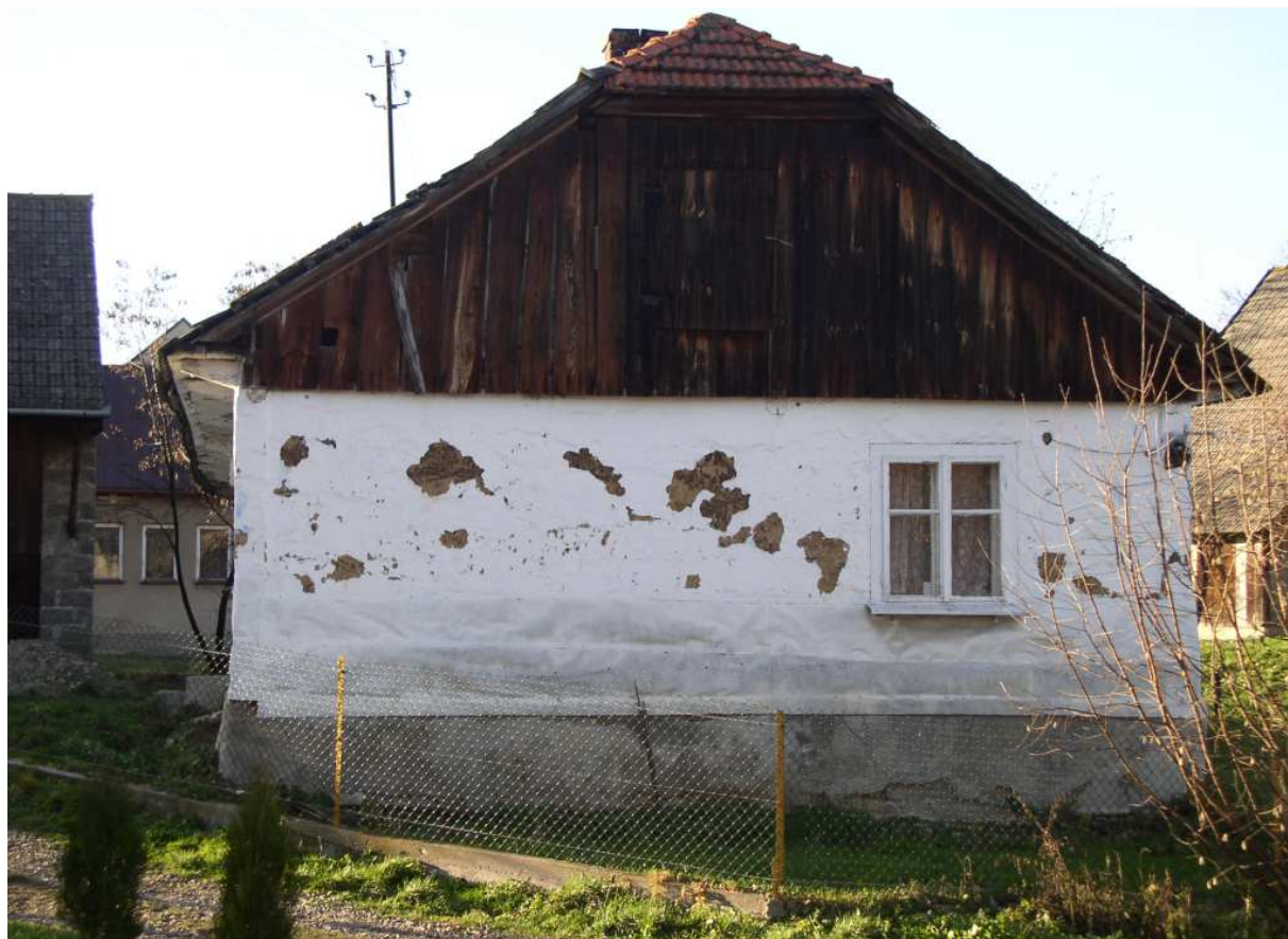
Fot. nr 122 (122-123). Boczna ściana - widoki od strony drogi. (02.12.2008)
