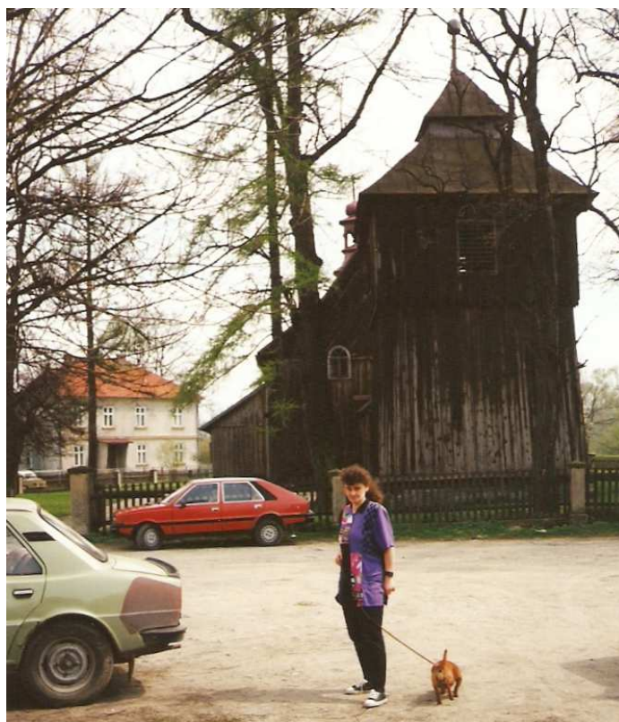
Fot. nr 30. Dzwonnica przed kościołem wg stanu z roku 2000.
