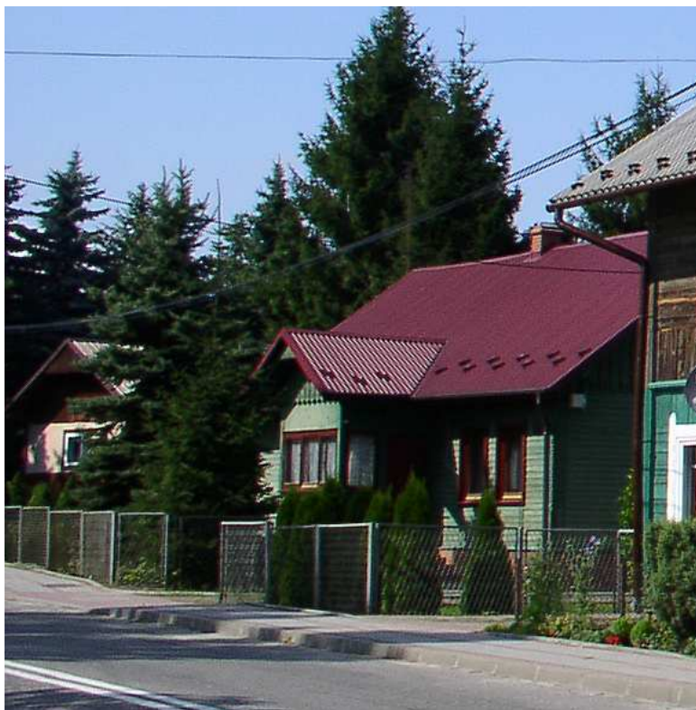
Fot. nr 5. Przebudowana chałupa z gankiem spod nr 86. (05.08.2010)
