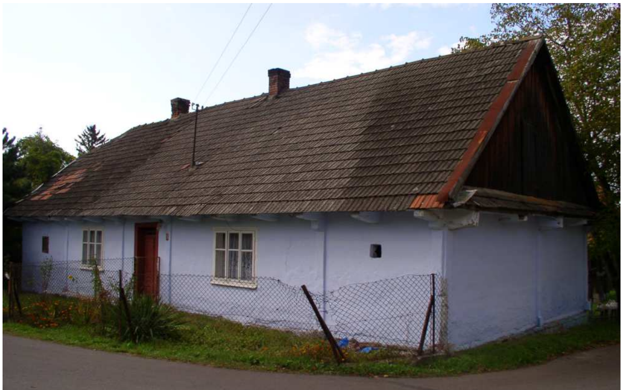
Fot. nr 163 (163-164). Dwutraktowa chałupa o konstrukcji zrębowej spod nr 13, wybudowana w okolicy przełomu XIX i XX wieku, nadal przykładnie bielona. (11.10.2009)
