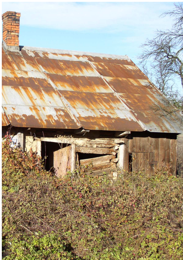
Fot. nr 137. Fragment konstrukcji zrębowej w części gospodarczej. (02.12.2008)
