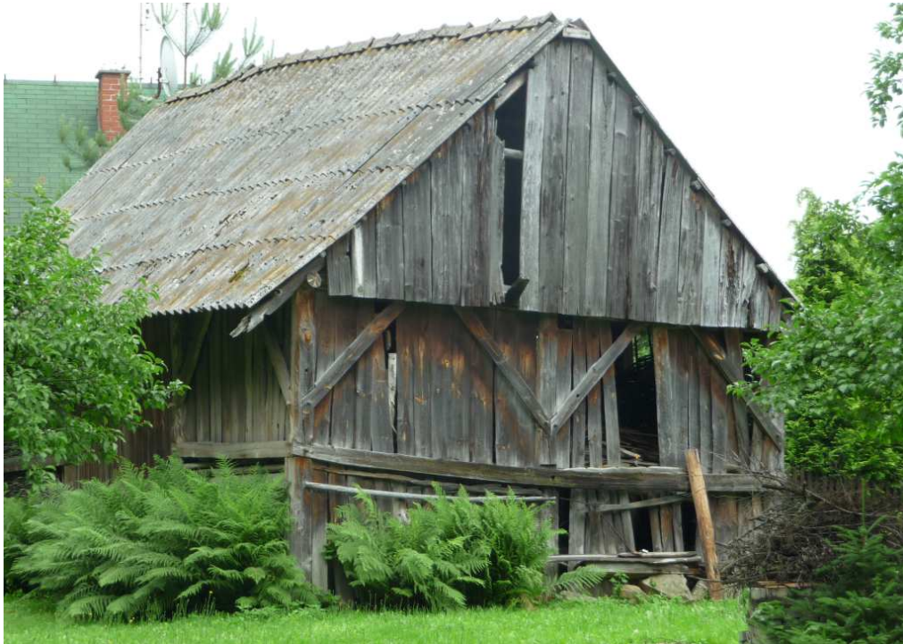
Fot. nr 91. Prawy bok kryty deskami. (27.06.2013)
