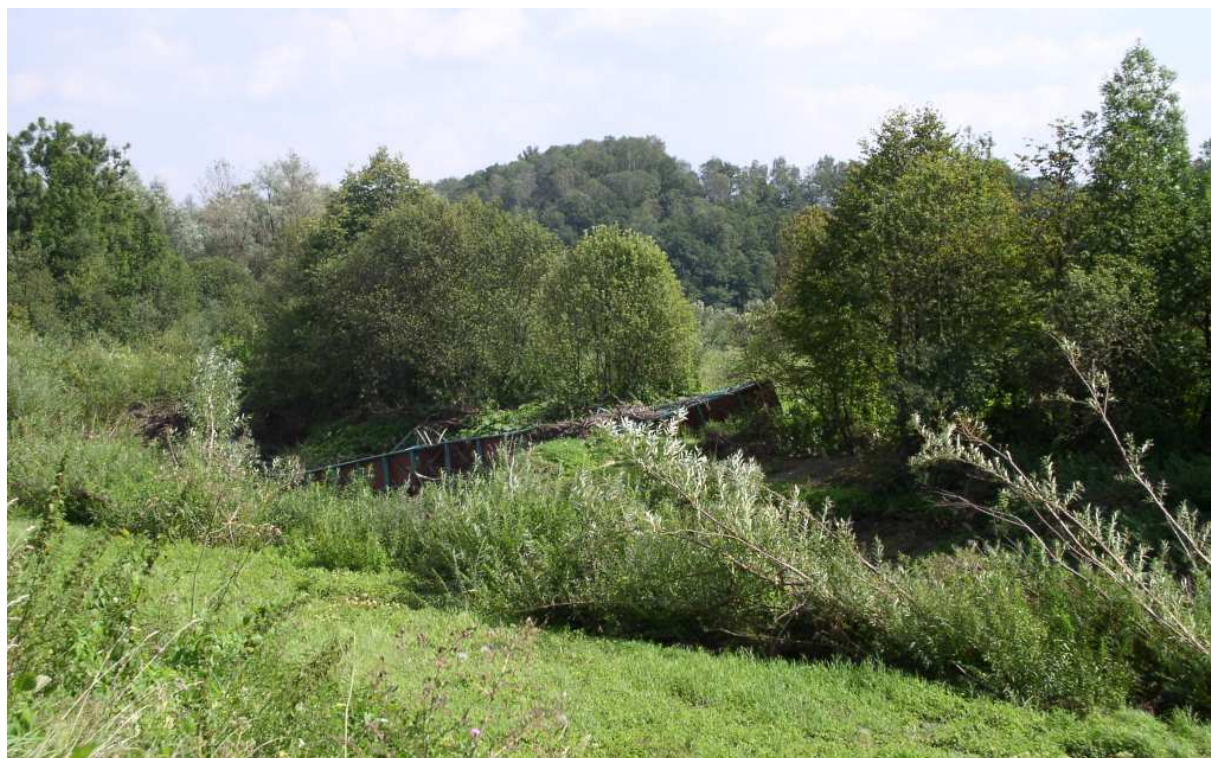
Fot. nr 40. Zerwany most po powodzi. (20.08.2010)
