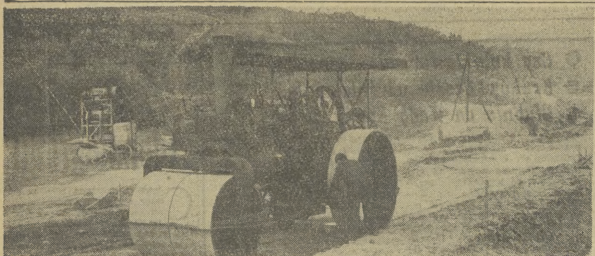
W rejonie Bleszczad położonych na południowo-wschodnich krańcach Rzeszowszczyzny prowadzi się prace mające na celu gospodarcze ożywienie tych terenów. M. in. przewidziano w br. wybudowanie lub przebudowanie 25 km dróg, 30 mostów i kilkadziesiąt przepustów. Oto budowa drogi Jabłonka — Cisna. CAF — fot. Olszewski
