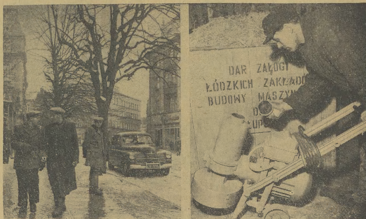
Inicjatywa współpracy m. Łodzi ze Słupskiem powstała w styczniu br. na jednym z zebranych przedwyborczych. Pomoc Słupskowi postanowił m. in. łódzkie Zakłady Budowy Maszyn, ofiarowując tamtejszemu przemysłowi terenowe urządzenie potrzebne do uruchomienia produkcji materiałów budowlanych. Słupsk posiada idealne warunki do tej produkcji: jest woda, żwir, haldy żużli w gazowni itp. Na zdjęciu z lewej: na jednej z ulic Słupska. Na zdjęciu z prawej: pierwsze maszyny dla Słupska nadeszły z Łodzi...
