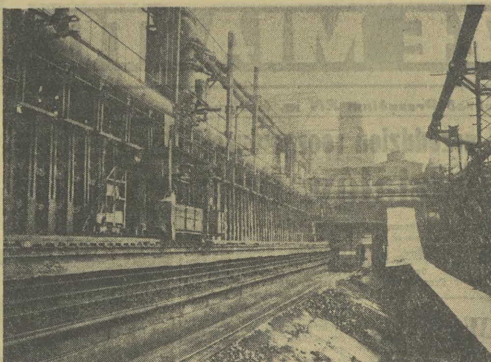
Huta „Kościszko” w Chorzowie. Na zdjęciu: Fragment baterii koksowniczej. Fot. — CAF
