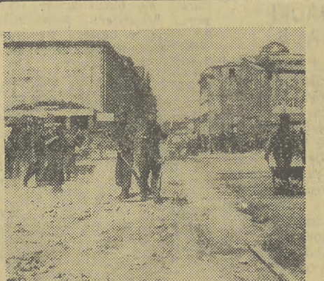
To zdjęcie wykonano na Nowym Świecie w 1949 roku. Junacy z SP układają jezdnie i chodniki.
