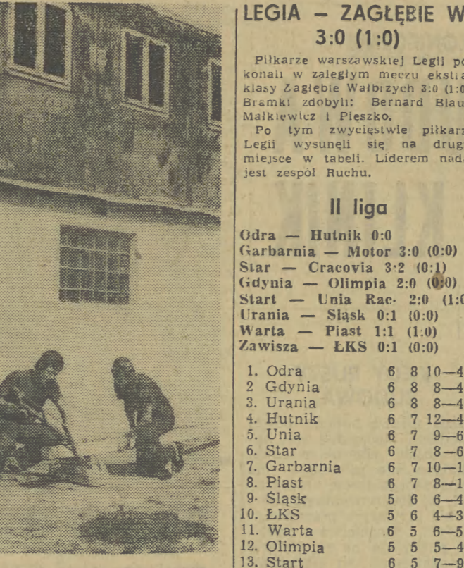
Wysiłkiem wiejskiej młodzieży w Piątkowej pow. Nowy Sącz wybudowana nowa statnia i świetlica. Na zdjęciu: Kazimierz Klimkiewicz i Bogdan Łukasik przy pracach budowlanych.
