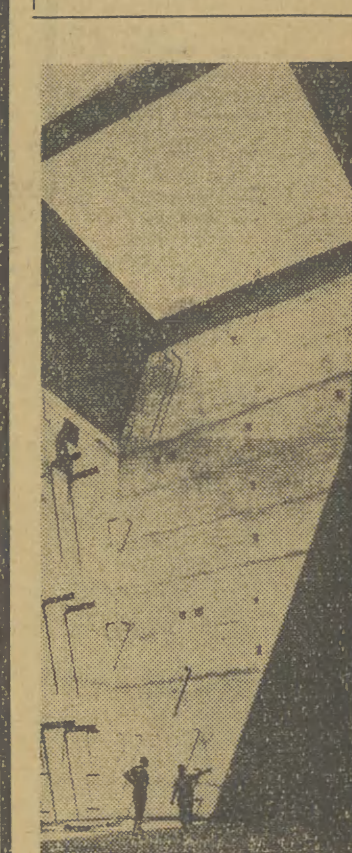
Niczym dzieło kubizmu wygląda ta żelazobetonowa hala wysokości 23 metrów, długości 12 metrów i szerokości 20 metrów. Pomieści ona wytwórnię pary pierwszej zechosławskiej elektrowni atomowej w mieście Jaslowie Bohunice. CAF
