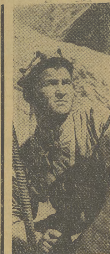
W górach Tiań-Szań, na rzece Naryn powstaje duży zakład energetyczny — Toktogulsk. Elektrownia Wodna. Żelazobetonowa zapora osiągnie wysokość 230 metrów. W skrajnej hall budowniczości ustawiają sześć agregatów o mocy dwieście tysięcy kW każdy, o wymiarach: 120 metrów długości, 30 metrów szerokości i 60 metrów wysokości. Na zdjęciu: Raimbek Ma-mylov i Atambek Dusunbekov „skalolazi” pracujący na urwistych brzegach Narynu. CAF
