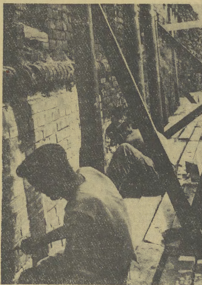
Pełną parą idą prace przy wymianie cegieł w murach Wawelu. Fot. W. Książek
