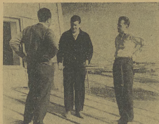
W tych dniach I sekretarz KW PZPR tow. Lucjan Motyka wizytował budowę stacji przejazdowej na Chorągwiec-Mielniowiec. Widzimy go na naszym zdjęciu w rozmowie z wykonawcami. Fot. J. Uiberall
