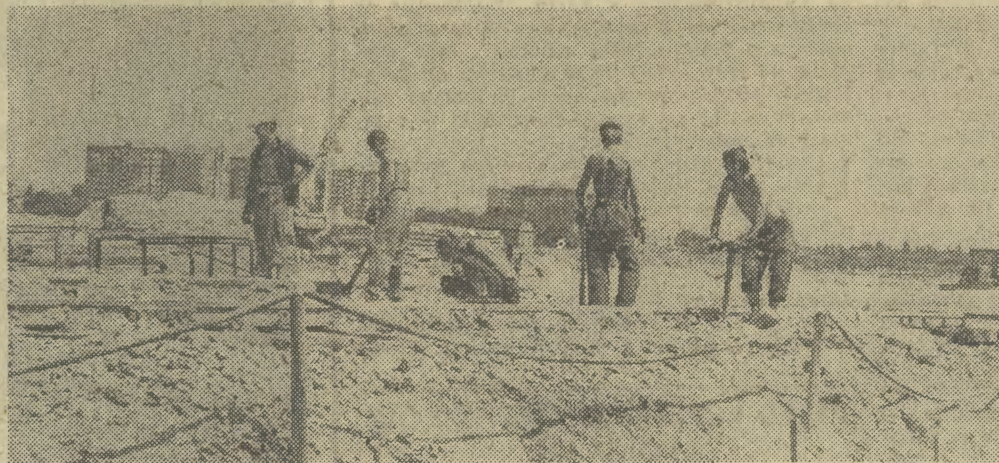
Rozpoczęto budowę nowego osiedla mieszkaniowego „Włók”. Fot. W. Klag
