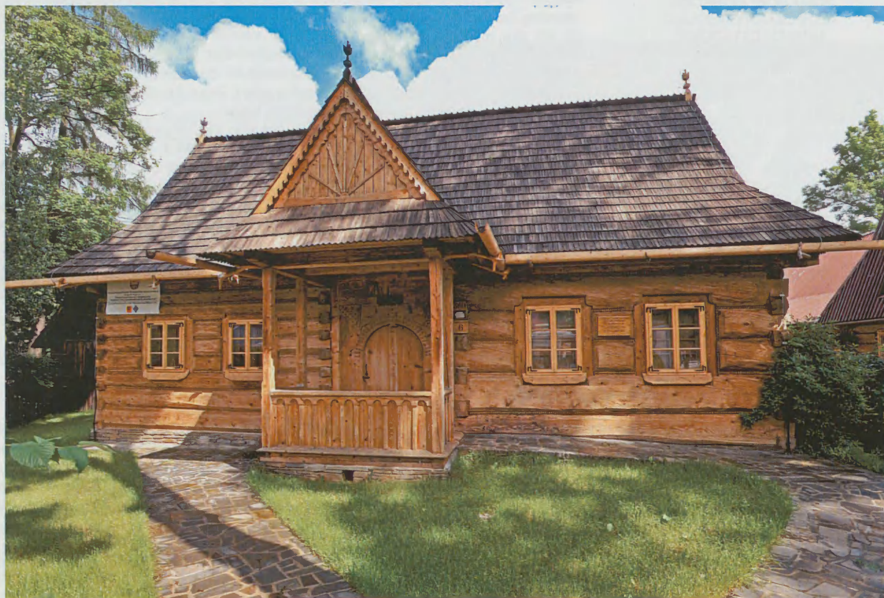
Chałupa w przeszłości należąca do góralskiej rodziny Gąsieniców Sobczaków. Najstarsza jej część została wybudowana około 1830.
