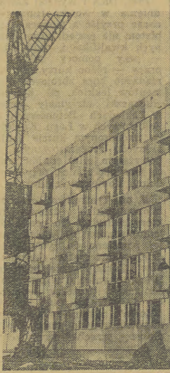
W Nowej Hucie trwają prace wykończeniowe przy budowie nowoczesnego domu mieszkalnego z elementami prefabrykowanymi tzw. „domino”. Budowla wygląda imponująco i nowoczesnie. Fot. J. Uiberall
