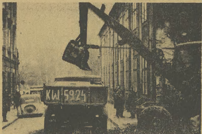
Przy ul. Krzyżak rozpoczęto prace przy budowie kotłowni, która doprowadzi ciepło do kilku najbliższych budynków. Na zdjęciu: wielki dźwig przygotowuje teren budowy. Fot. J. Uiberall
