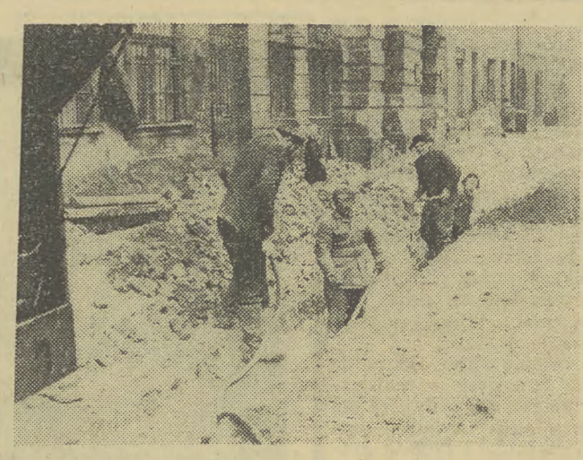
W ul. Stolarskiej od dłuższego już czasu pracownicy „Gazobudowy” zakładają instalację gazową. Fot. W. Klag
