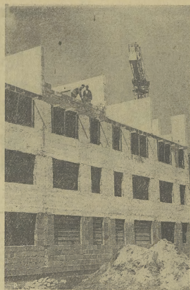
Na Azorach rośnie nowe osie dla mieszkaniowe, budowane z elementów prefabrykowanych. Fot. J. Uiberall
