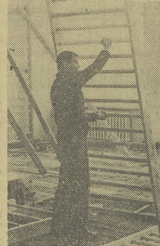
Roboty wykończeniowe w sali gimnastycznej.
