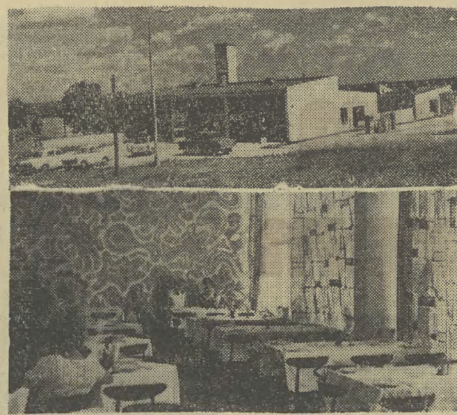
W Serocku na trasie Warszawa — Augustów otwarto nowy hotel Motoszyty. Czynny całą dobę, posiada dwadzieścia pokoi dwuosobowych. Restauracja na 70 miejsc, stacja obsługi samochodów przez 24 godziny. CAF — Uchymiak
