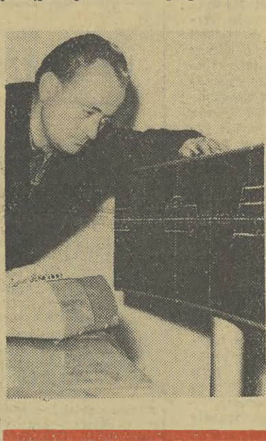
Pracownik przy sterowniku automatyzacji.
