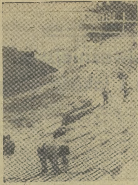
W Lesznie — mieście tegorocznych Centralnych Dożynek trwają prace końcowe nad całkowitą przebudową Stadionu im. Alfreda Smoczyka. Na zdjęciu: junacy z OHP montują ławki na koronie stadionu.
