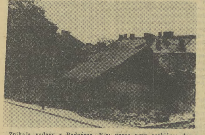
Znikają rudery z Podgórze. N/z: prace przy rozbiórce domu przy ul. Józefa. (fot. W. Klag)
