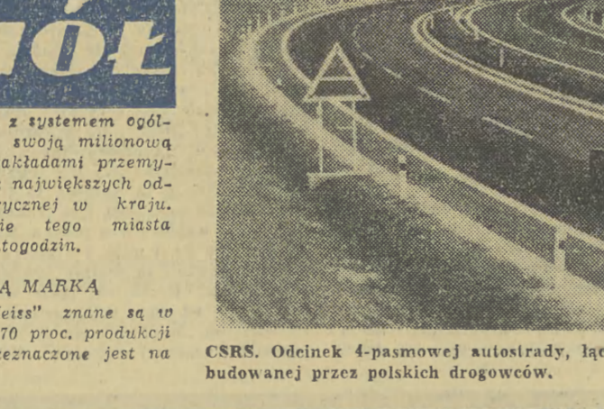
CSRS. Odcinek 4-pasmowej autostrady, łączącej Turnov i Liberec, budowanej przez polskich drogowców. CAF — CTK
