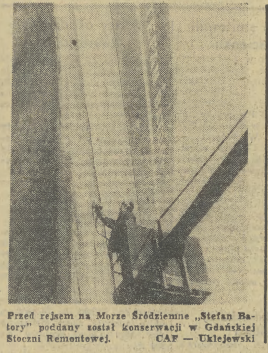
Przed rejsem na Morze Śródziemne „Stefan Batory” poddany został konserwacji w Gdańskim Stoczni Remontowej. CAF — Ukłejewski
